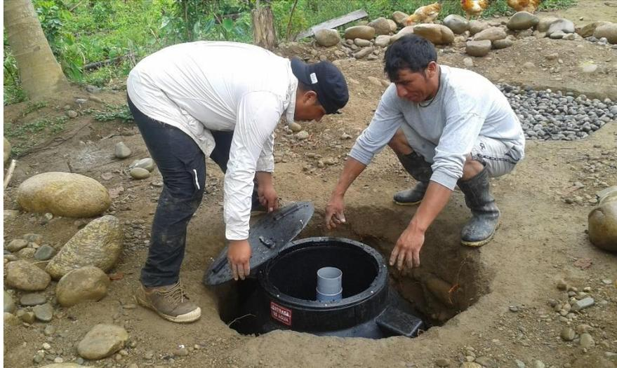
*Figura 22 posición correcta de instalaciones biodigestor ( fuente elaboración propia)*
