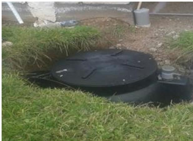
*Figura 18 biodigestor con problemas de desnivelación por la fuerza de empuje del nivel freático alto ( fuente elaboración propia)*
