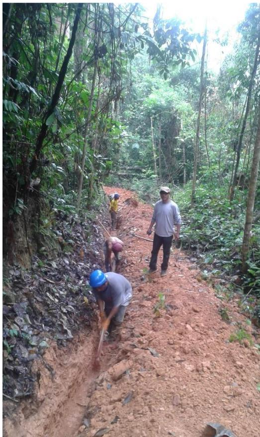
*Figura 24 excavación para línea de conducción (fuente elaboración propia)*
