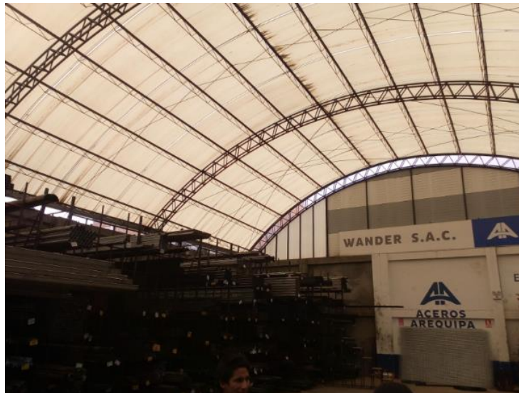
Almacén de la empresa WANDER S.A.C. separado cada producto por casilleros.
