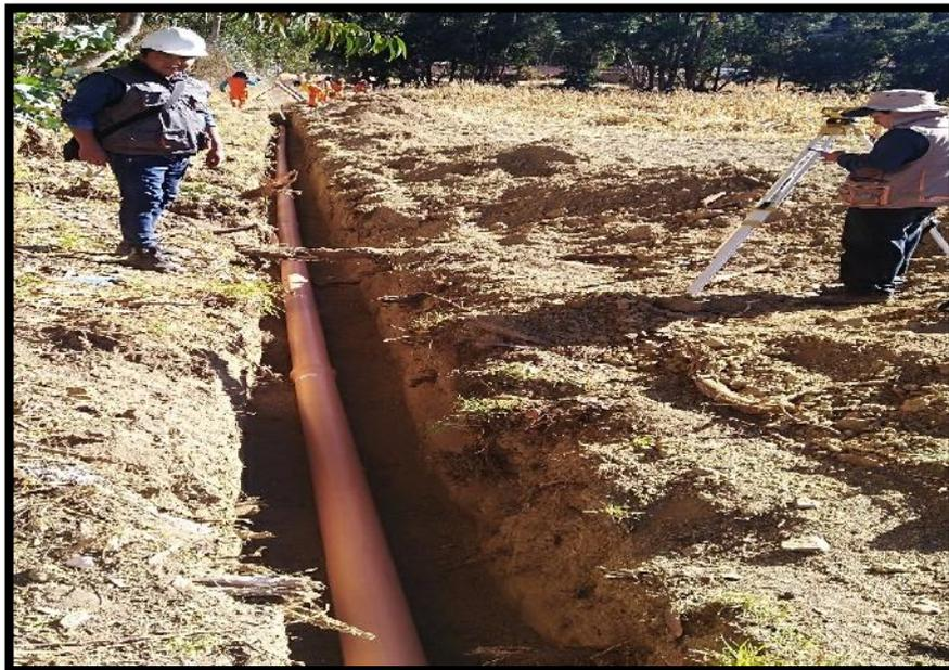
Foto 6. El tendido de tuberías es más extenso en el sistema convencional y no optimiza la longitud de redes y genera costos elevados en la ejecución.
