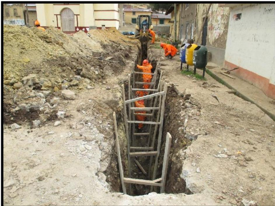
Foto 4. El sistema convencional pasa por el eje de la vía.
