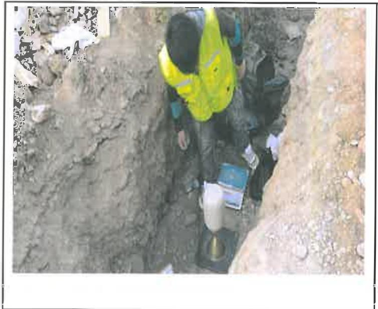
FOTO. 02.- ENSAYO DE DENSIDAD DE CAMPO, “MEJORAMIENTO Y AMPLIACIÓN DEL SISTEMA DE AGUA POTABLE Y ALCANTARILLADO DE LA LOCALIDAD DE CHACAPALPA Y BARRIOS DISTRITO DE CHACAPALPA – YAULI -JUNÍN”
