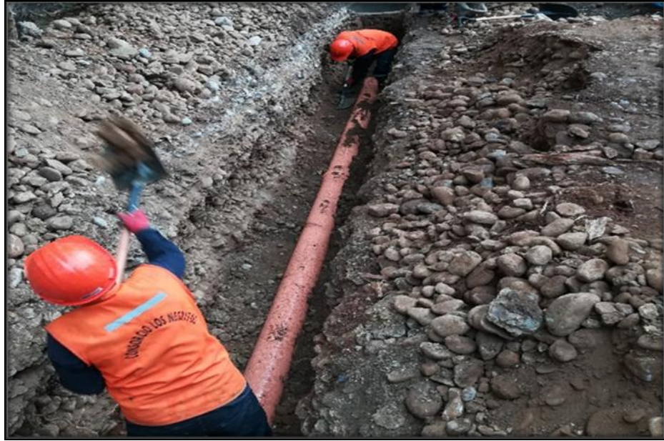
Fotografía 9.- Colocado de tubería para Desagüe
