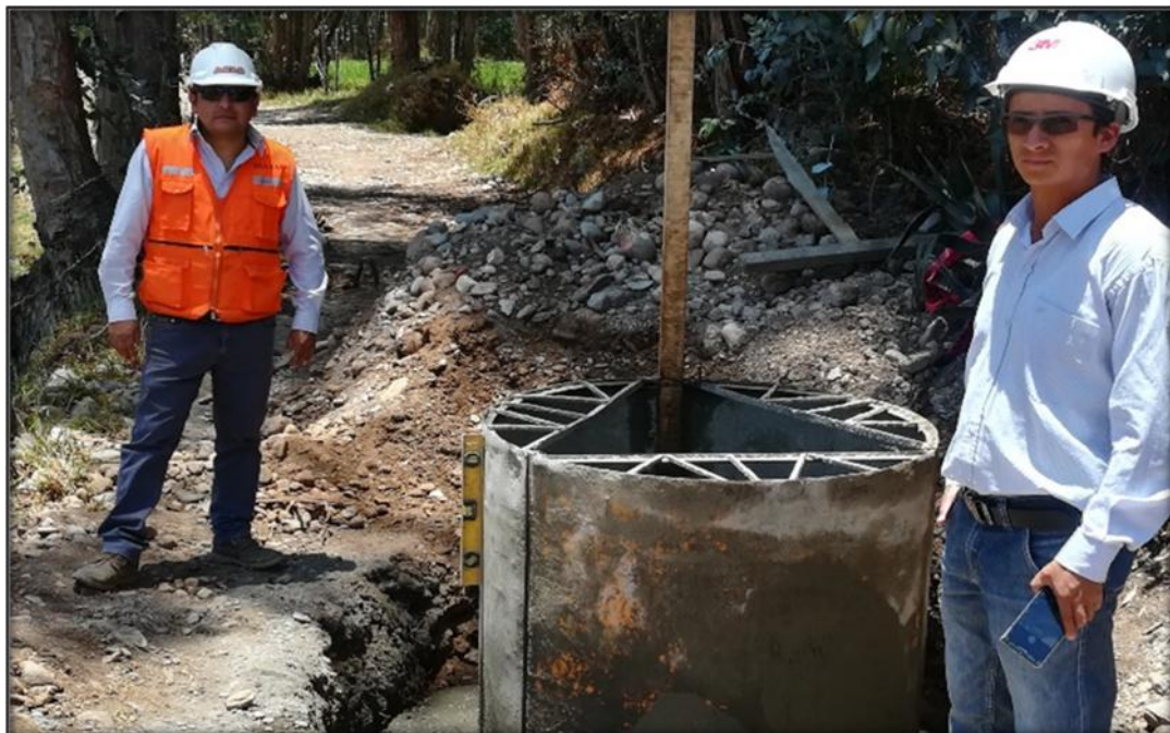
FOTO N° 08: Se observa en la imagen al Ing. Residente de obra y mi persona inspeccionada los buzones en el tramo 3 se verifico la verticalidad y espesor de muro en cuerpo de buzón.
