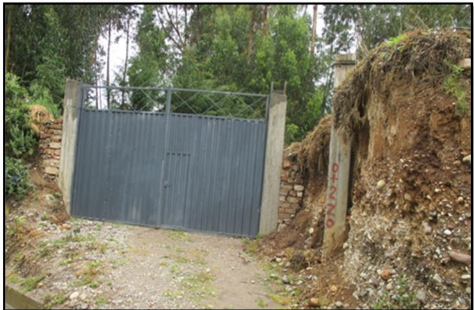
Fotografía 3.- Colocación de progresivas
