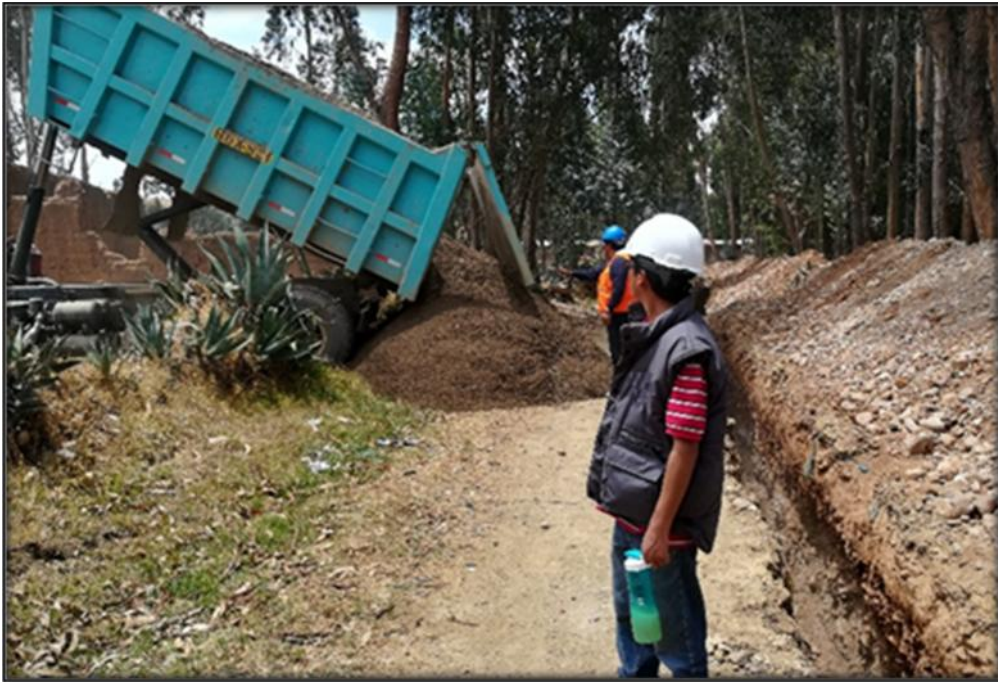
FOTO N° 15: Descarga de materia arena gruesa para el tendido de cama de apoyo. El material cumple con lo exigido por la Especificación. Tec. Del expediente.
