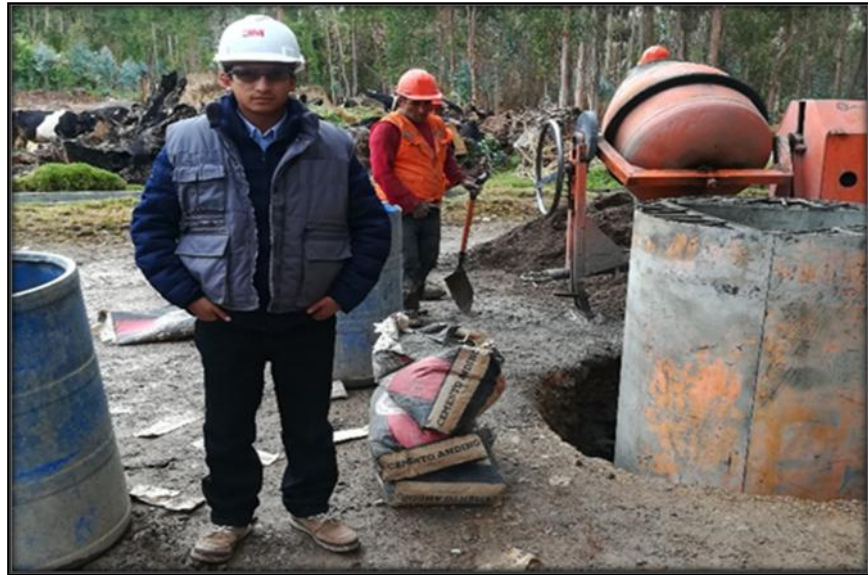
Fotografía 11. - Encofrado de Buzones
