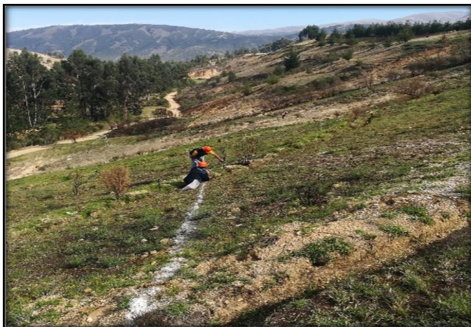
Fotografía 6. - Replanteo de Reservorio
