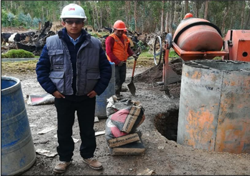
FOTO N° 03: En la imagen se observa el vaciado de concreto ( F'c=175\text{Kg/cm}^2 ) en el buzón zona 2 – denominado Alayoc
