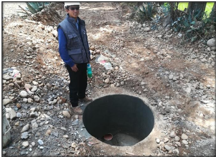
Fotografía 12.- Verificación de Vaciado de Buzón
