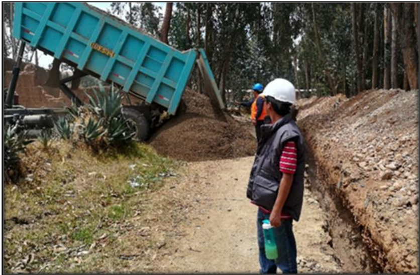
Fotografía 8.- Material para relleno de cama de arena
