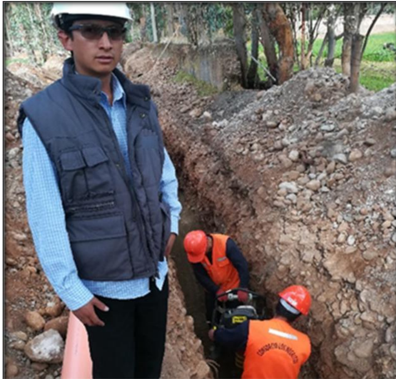
FOTO N° 07: Se observa la compactación de zanja a nivel de sub. rasante para la colocación de tubería de 200mm aproximado a 8", tipo de tubería PVC-UF
