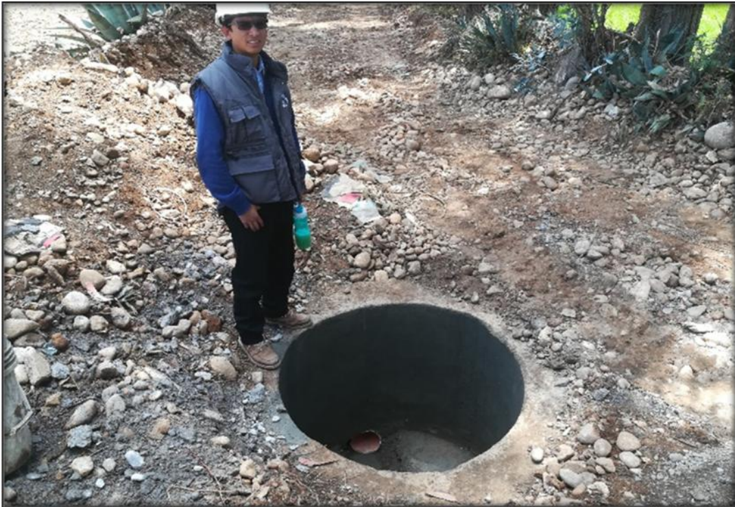
FOTO N° 04: Se visualiza el emboquillado de tubería en el buzón ejecutado.
