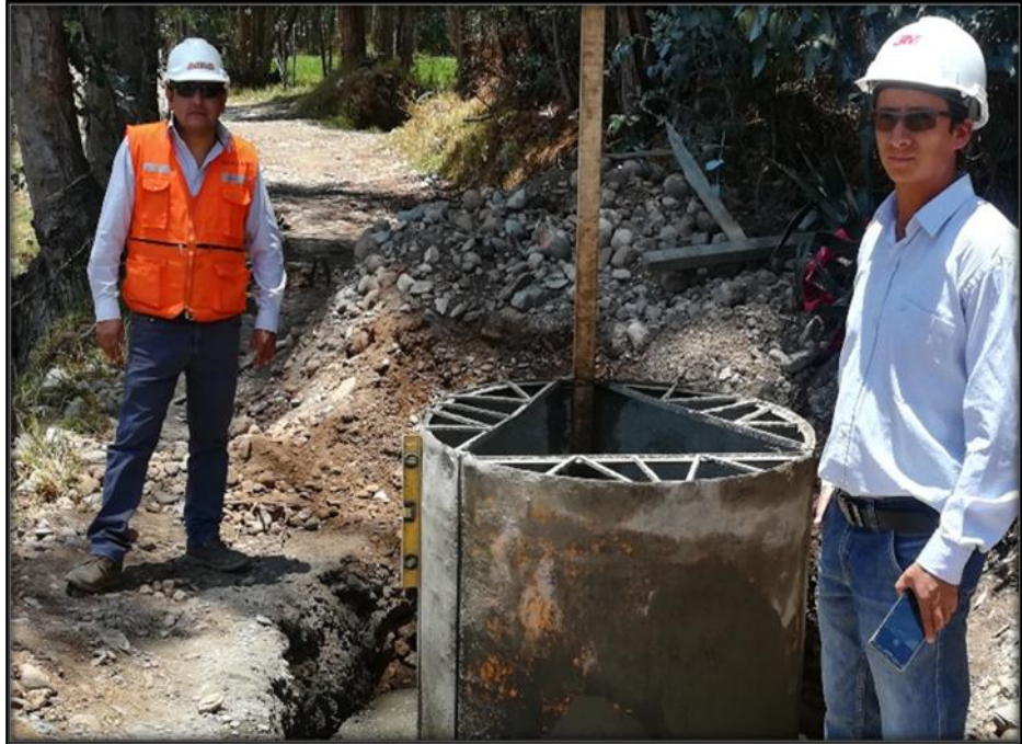
Fotografía 13.- Verificación de la dosificación del concreto
