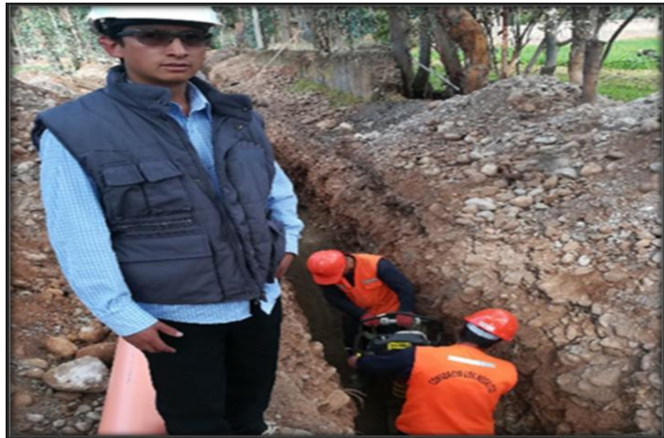
Fotografía 10.- Supervisión de compactado de Zanja
