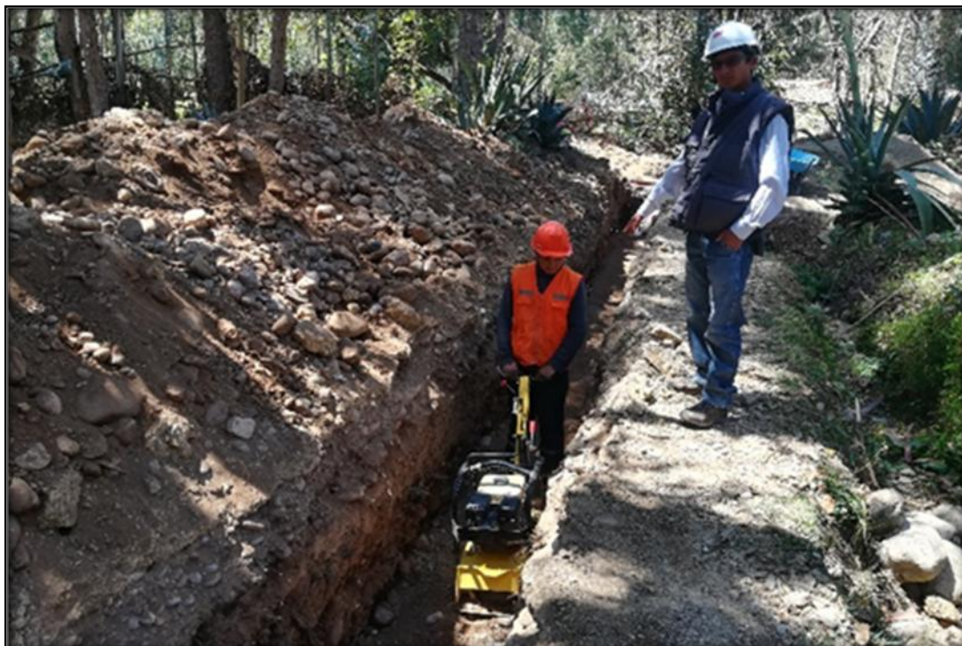
FOTO N° 10: Compactación de material de relleno posterior a la colocación de tubería y recubrimiento con arena o material seleccionado.
