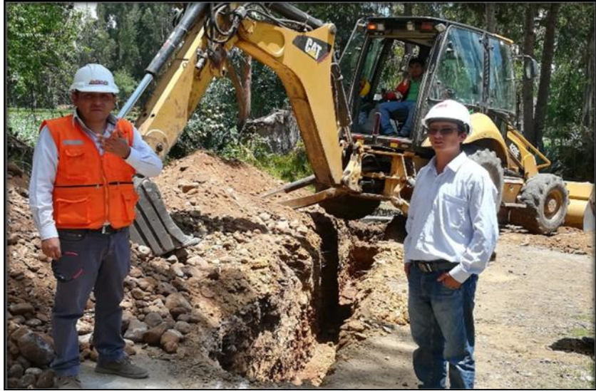
Fotografía 7.- Excavación para colocación de Tuberías
