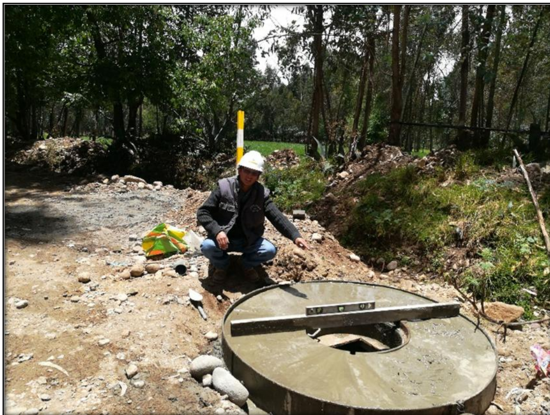
FOTO N° 18: Se observa la verificación de nivel en el techo de buzón.
