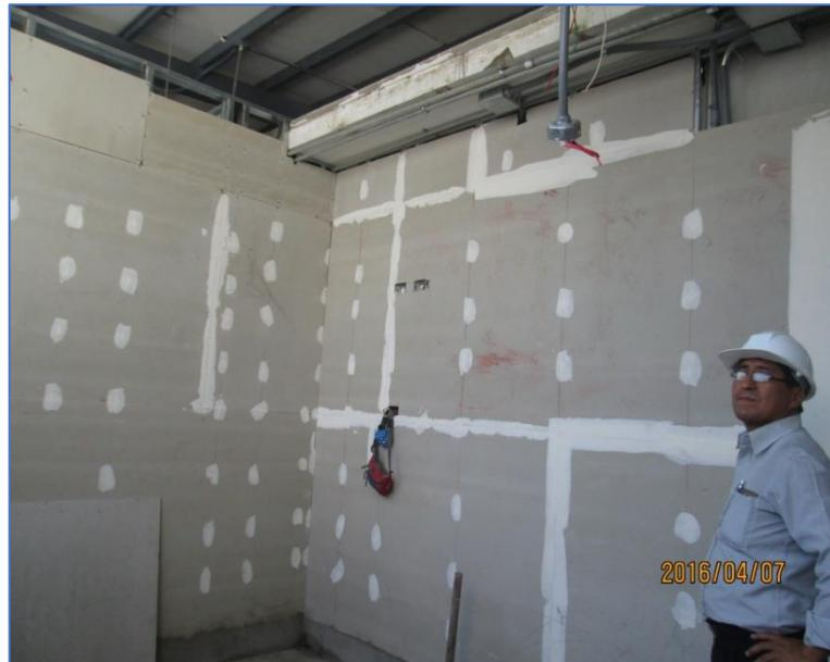
Fig. 3: Construcción en seco – Sistema Drywall
