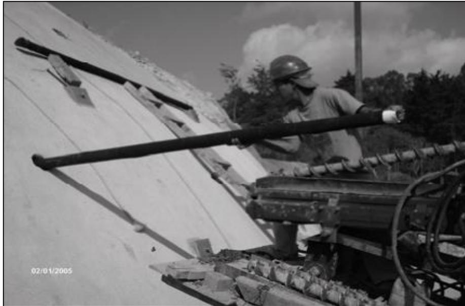
**Figura 43:** Colocación de drenajes
