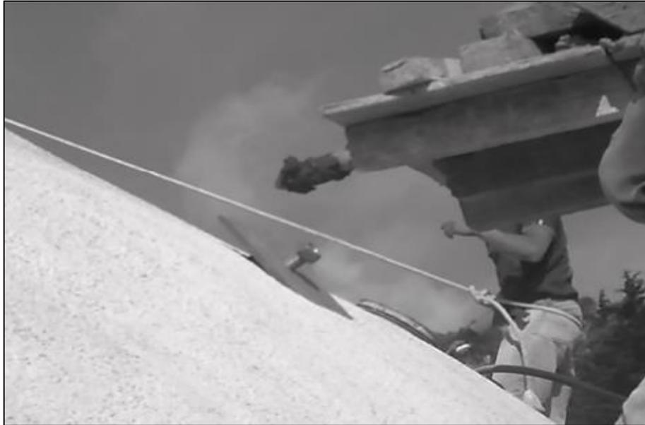
**Figura 38:** Colocación de platina
