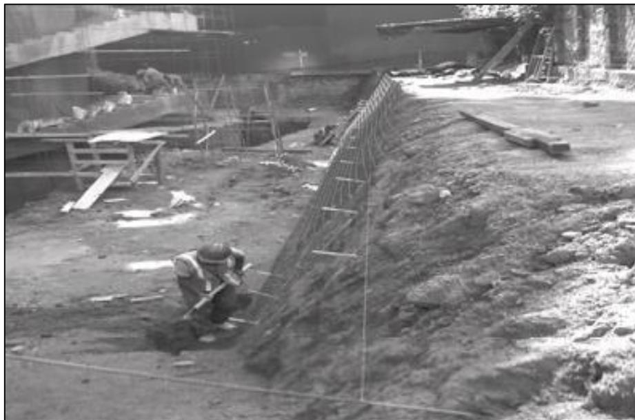
**Figura 32:** Colocación de la malla electrosoldada
