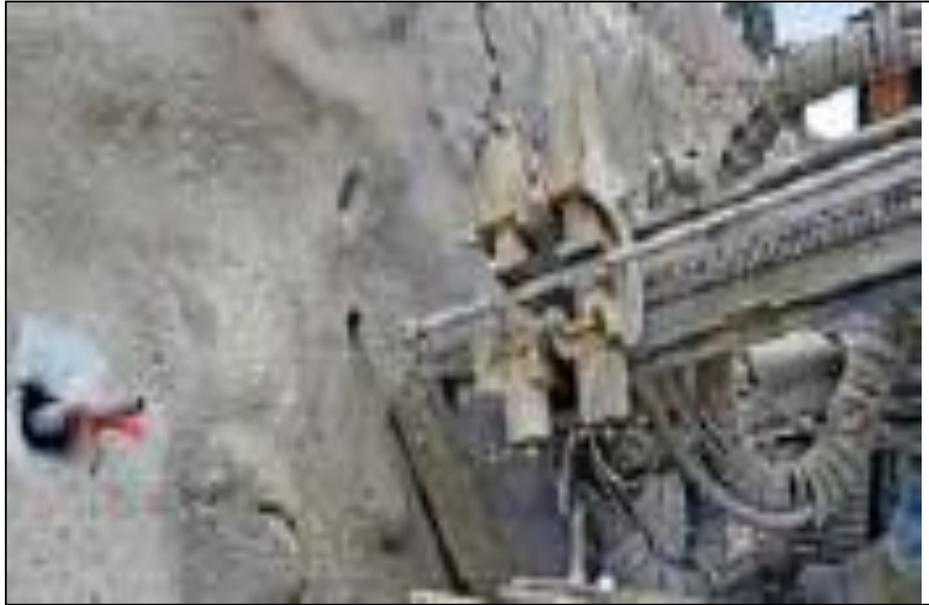
**Figura 30:** Los anclajes quedaron fundidos con una pequeña longitud fuera del suelo que tiene que ser adecuada al grosor de la pantalla de concreto lanzado y para ser sujetado con platinas y tuercas.
