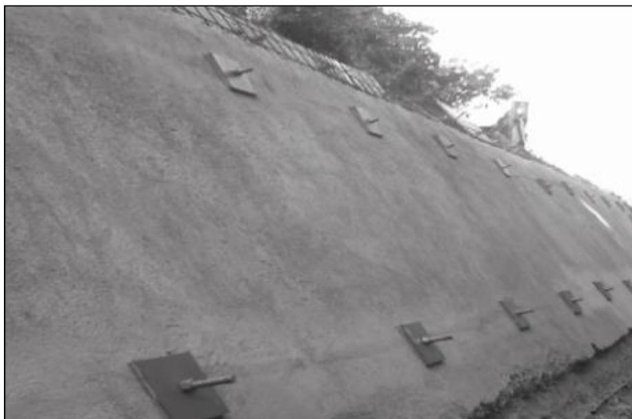
**Figura 39:** Platinas colocadas
