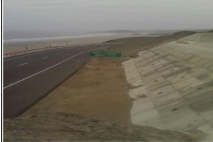
**Figura 4:** Talud Estabilizado (Ancón - MANTTO)
