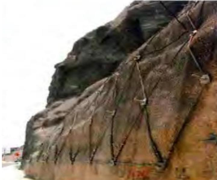
**Figura 2:** Talud anclado con Pernos de Anclaje
