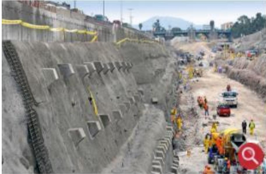
**Figura 3:** Talud Estabilizado (Vía parque Rímac)
