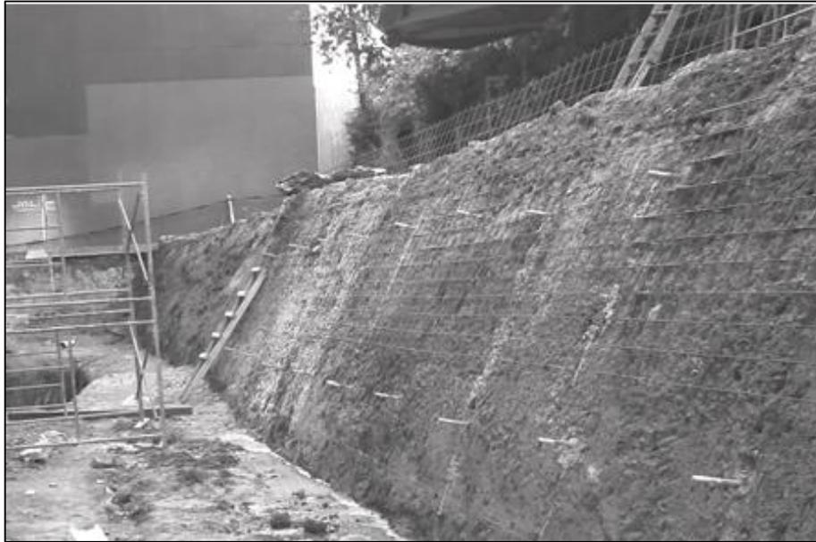
**Figura 33:** Malla electrosoldada fijada en el talud
