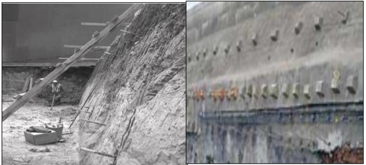
**Figura 31:** Antes y Después de la estabilización del Talud
