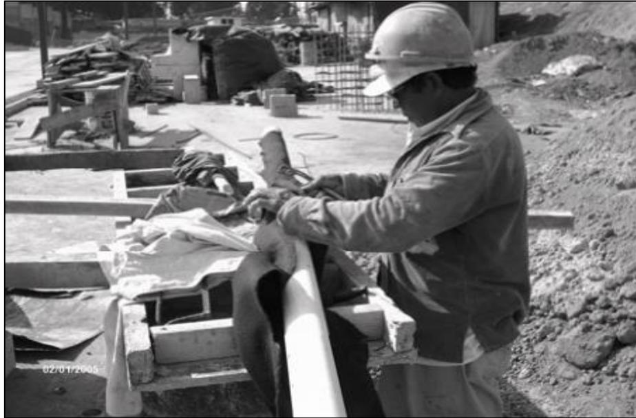
**Figura 41:** Colocación de Geotextil no tejido
