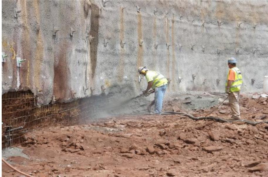
**Figura 64:** Aplicación de hormigón proyectado inicial
