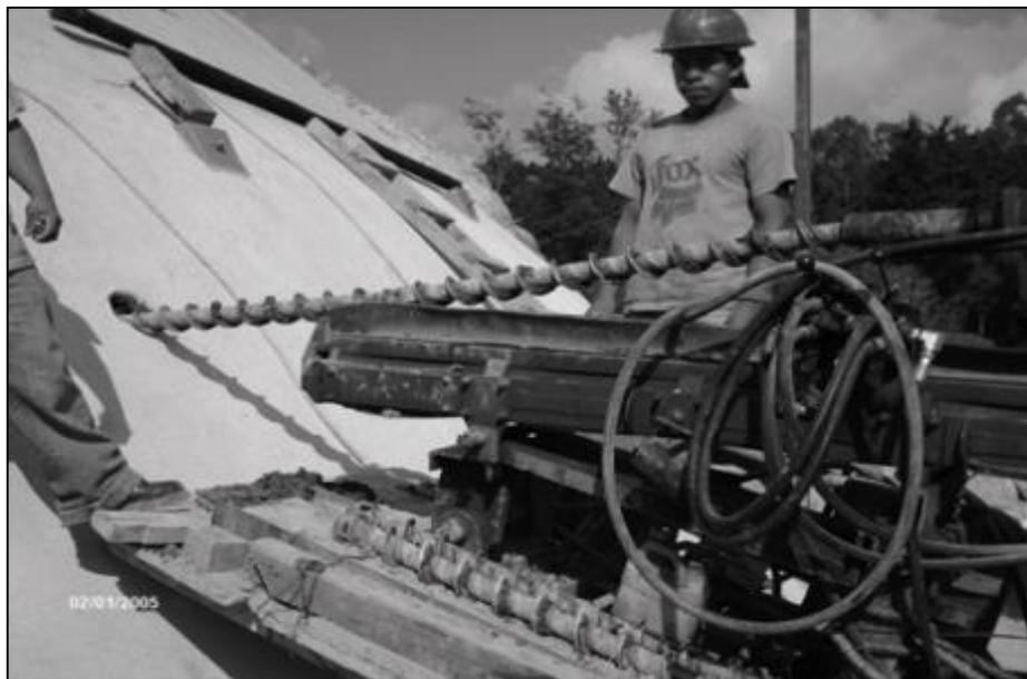
**Figura 42:** Perforación para drenajes
