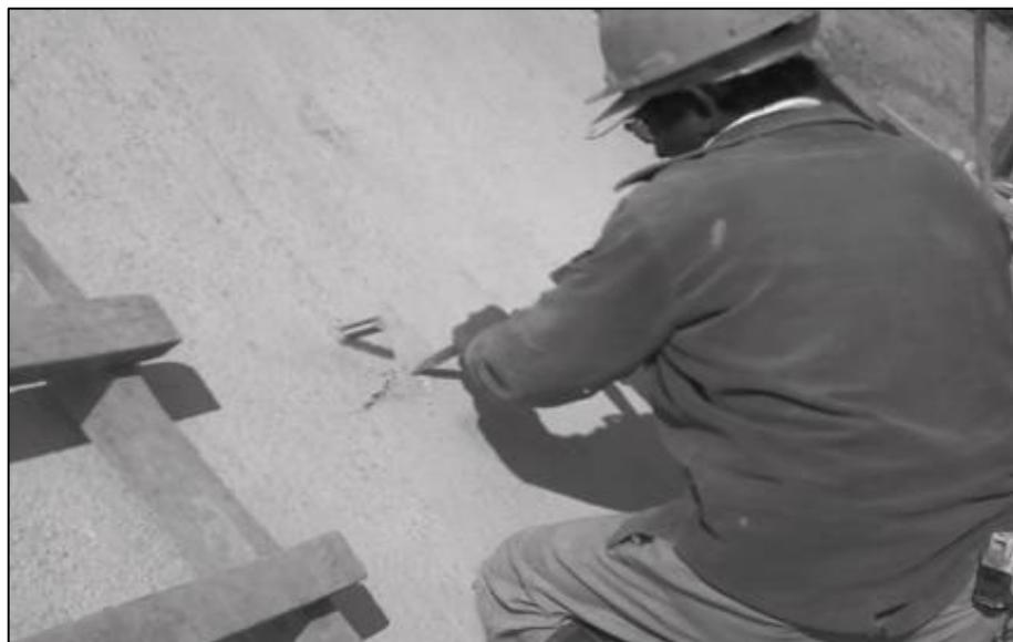
**Figura 36:** Preparación de superficie para colocar platina
