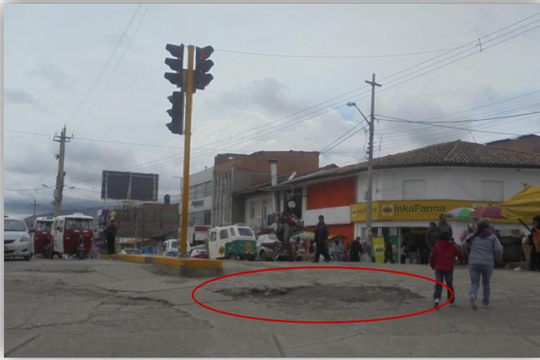
EL PAVIMENTO RÍGIDO PRESENTA DAÑOS PRONUNCIADOS, OCASIONADOS ÉSTOS POR EL TIEMPO Y LA AUSENCIA DE MANTENIMIENTO.
