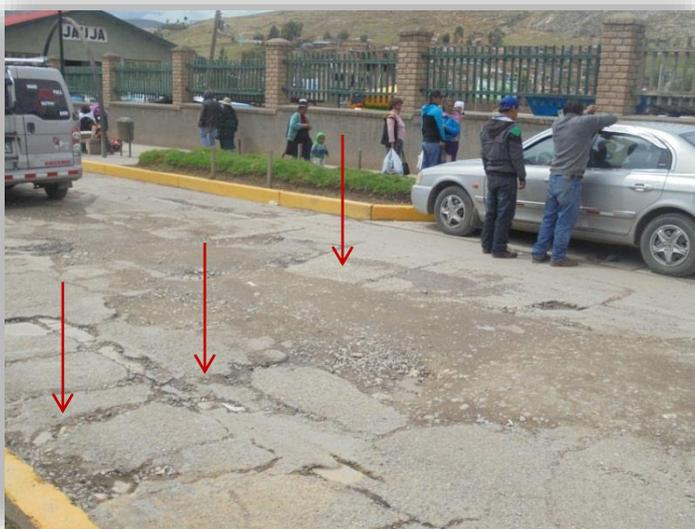
EL PAVIMENTO RÍGIDO PRESENTA FALLAS DE SEVERIDAD ALTA, COMO SON LOS AGRIETAMIENTOS Y ROTURA EN EL PAVIMENTO.
