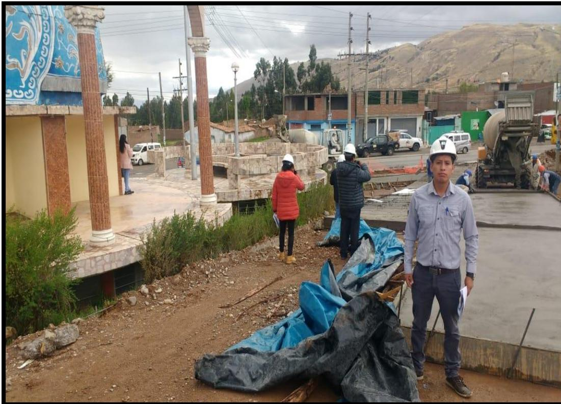
**FOTO N°03: PAVIMENTACION DE CONCRETO PREMEZCLADO F`C=210 kg/cm2**
