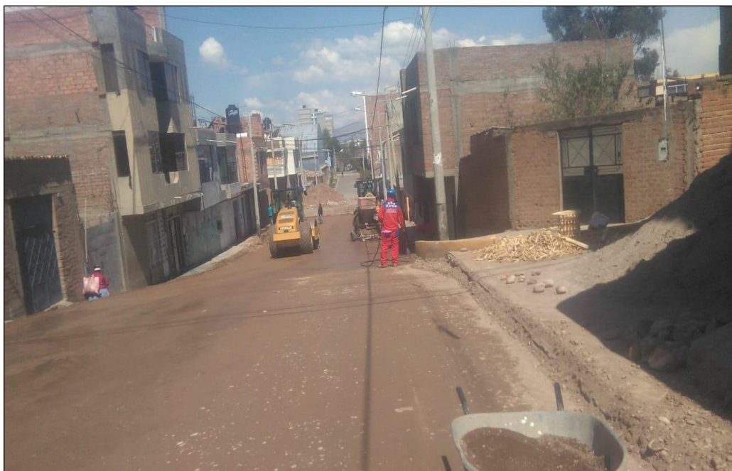
Figura N° 02: Trabajo del Proyecto.
