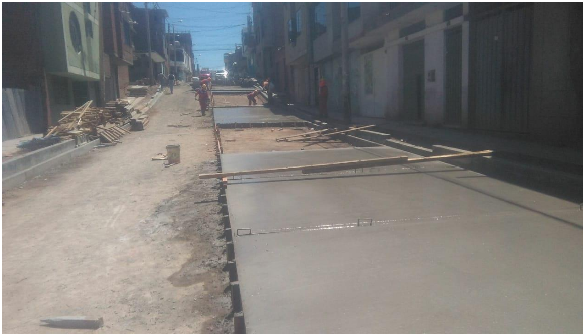
Foto N°05: Vaciado de pavimento
