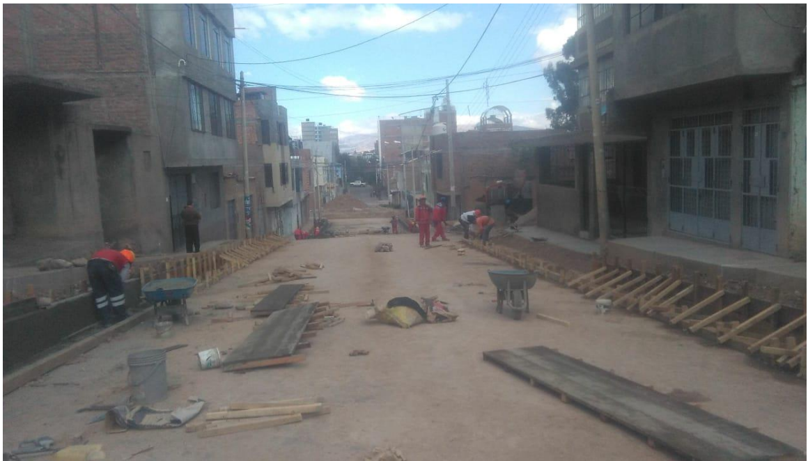
Foto N°02: Encofrado y Desencofrado de Sardinel
