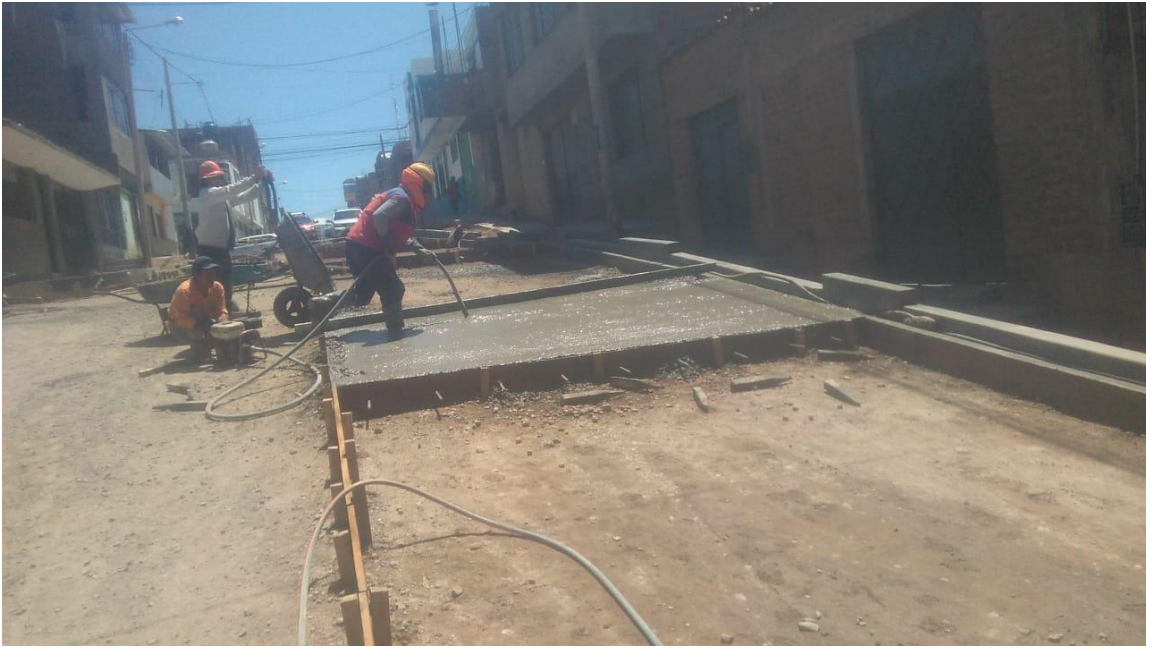
Foto N°03: Vaciado con buggy y vibrado del concreto
