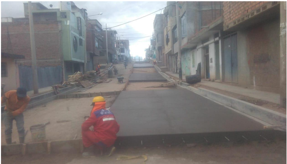
Foto N°04: Verificación de colocación de dowell y encofrado
