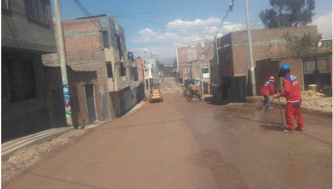
Foto N°01: Riego y compactación de la Subbase
