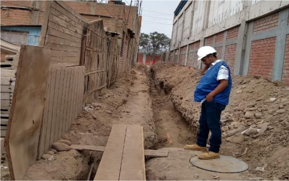
Foto13: verificación de trabajos de los UBS en obras similar al proyecto
