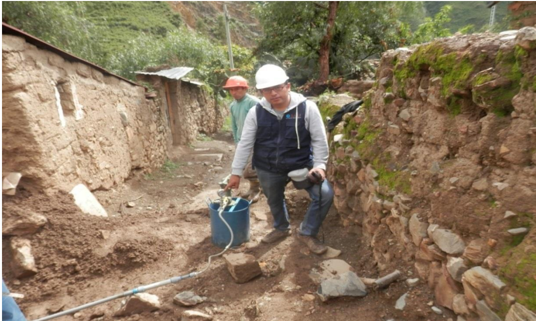
Foto 4: Verificación de Pruebas hidráulicas en la red de distribución
