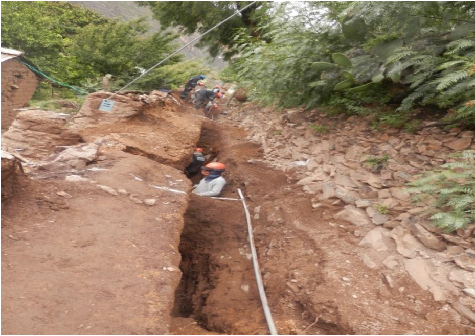
Foto 3: Verificación de la excavación de zanjas manuales en la red de distribución
