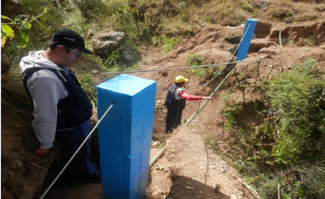
Foto 7: Verificación del cruce aéreo con tubo HDPE
