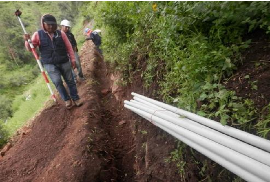
Foto 2: Verificación del Canal de conducción
