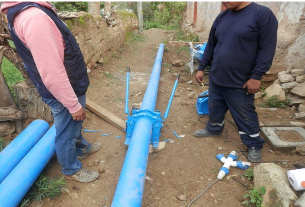
Foto12: trabajos de uniones con electrofusión en tubos HDPE verificaciones den obras similar al proyecto
