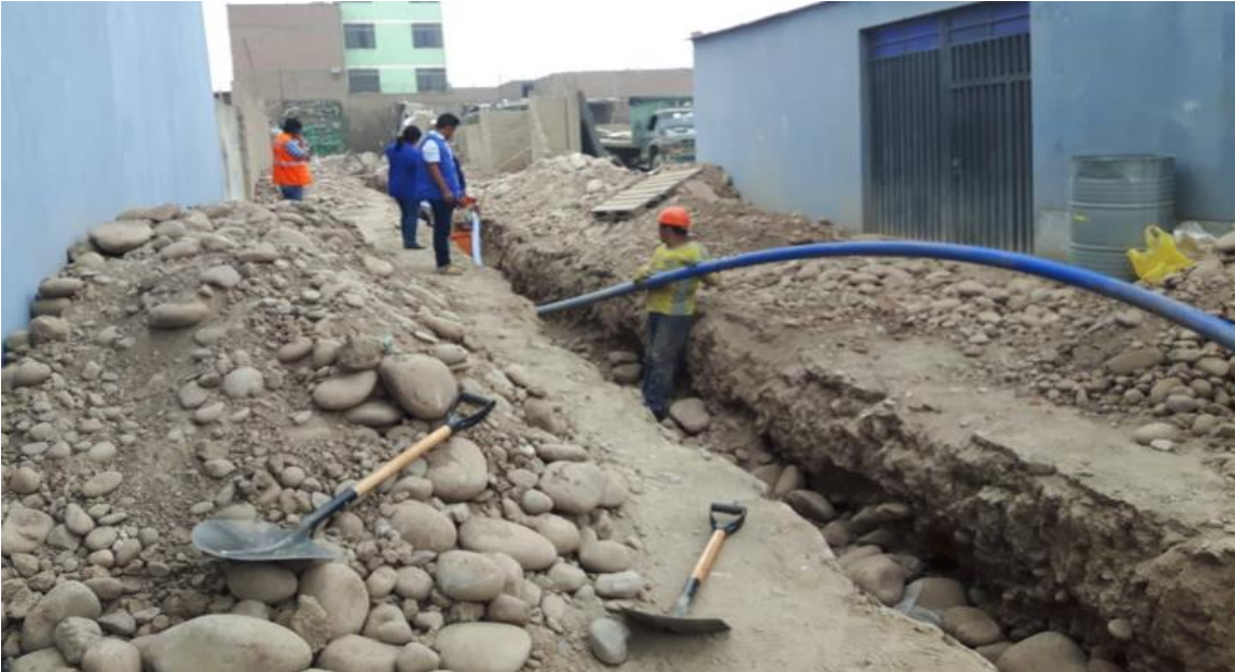
Foto11: verificaciones de obras similares al proyecto
