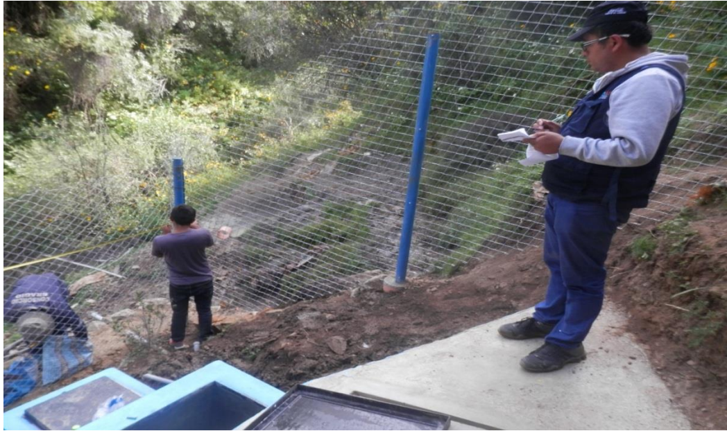
Foto 5: Verificación del cerco perimétrico de la captación
