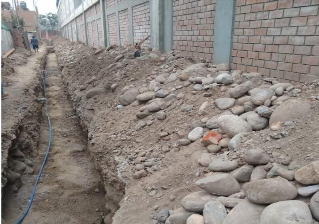
Foto15: Instalación de la cama de arena para nivelar
