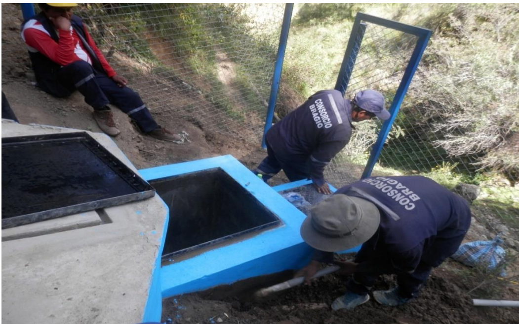
Foto 6: Otra Verificación del cerco perimétrico de la captación
