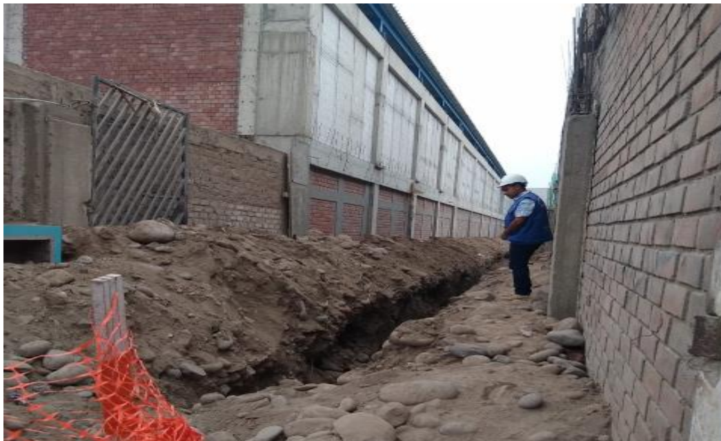
Foto 8: Otra vista de la Verificación de la Instalación con tubo HDPE en obras similares del proyecto
