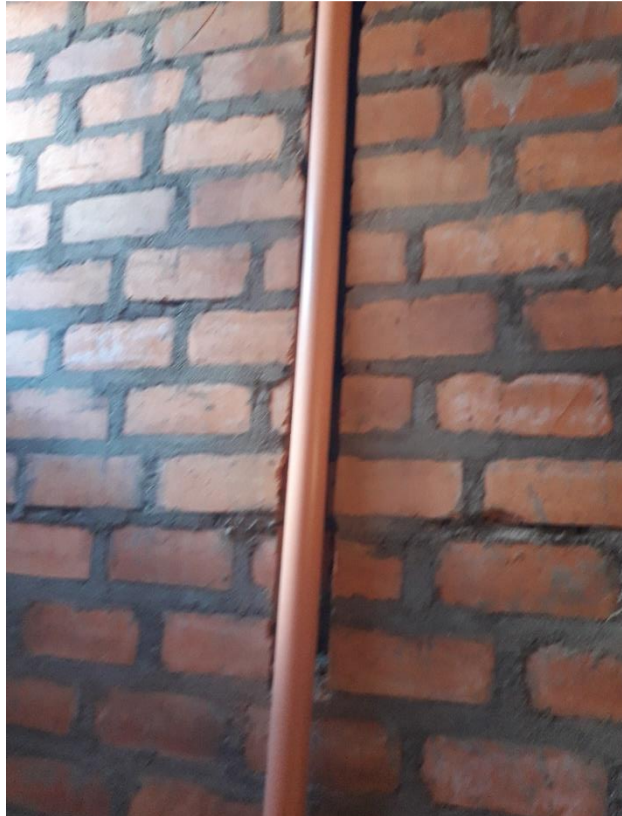
Fotografía N°34: Se cortó el muro para alojar la tubería.
