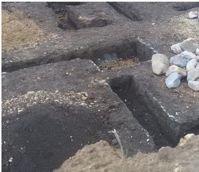
Fotografía N°08: Fondo de zapata igual al de sobrecimiento
