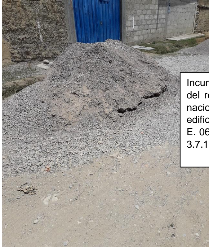
Fotografía N°41: Almacenamiento de agregado, no se encuentra cubierto para evitar que cambie sus propiedades
