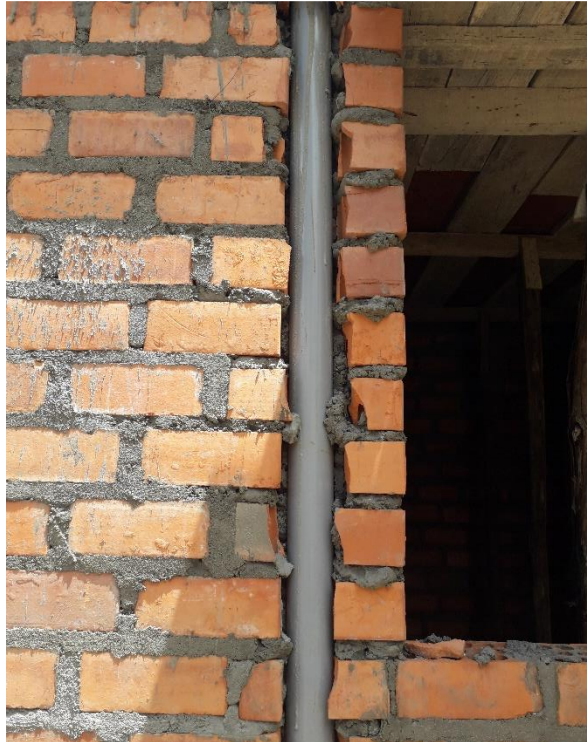
Fotografía N°32: Se picó el muro para poder alojar la tubería.
