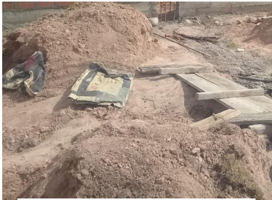
Fotografía N°07: Material extraído dentro de la zona de trabajo
