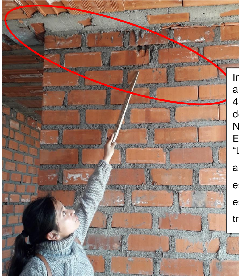
Fotografía N°25: Ladrillos de muro dañados al igual que en techo
