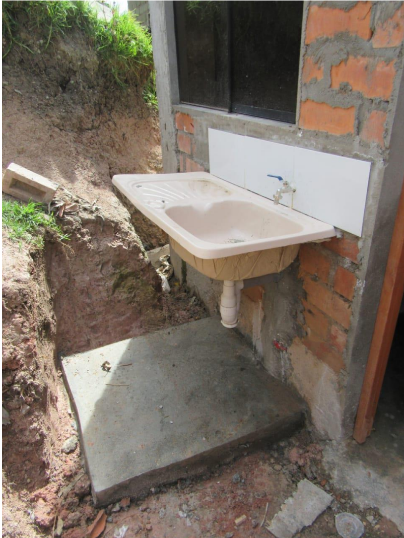
Fotografía N°23: Junta del muro en la parte exterior con exceso de mortero
