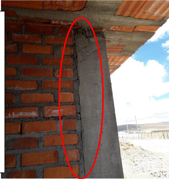
Fotografía N°21: Junta entre columna y el muro fragmentado
