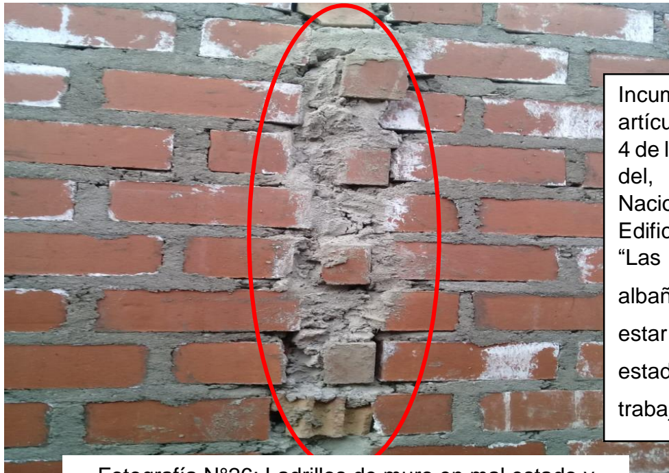
Fotografía N°26: Ladrillos de muro en mal estado y con concreto mal vaceado.
