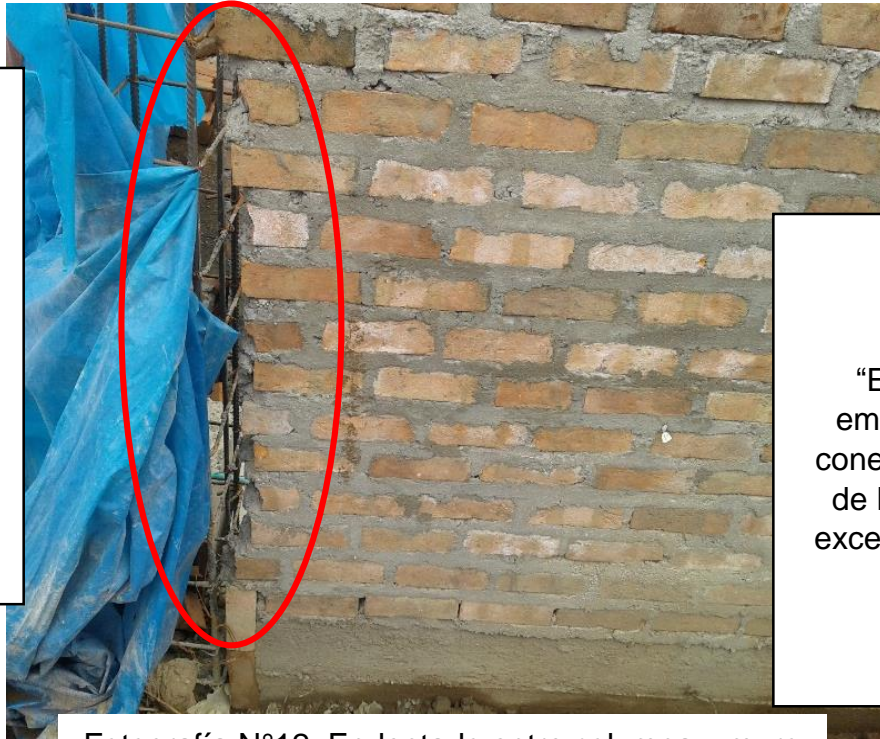
Fotografía N°12: Endentado entre columna y muro mal hechos.
