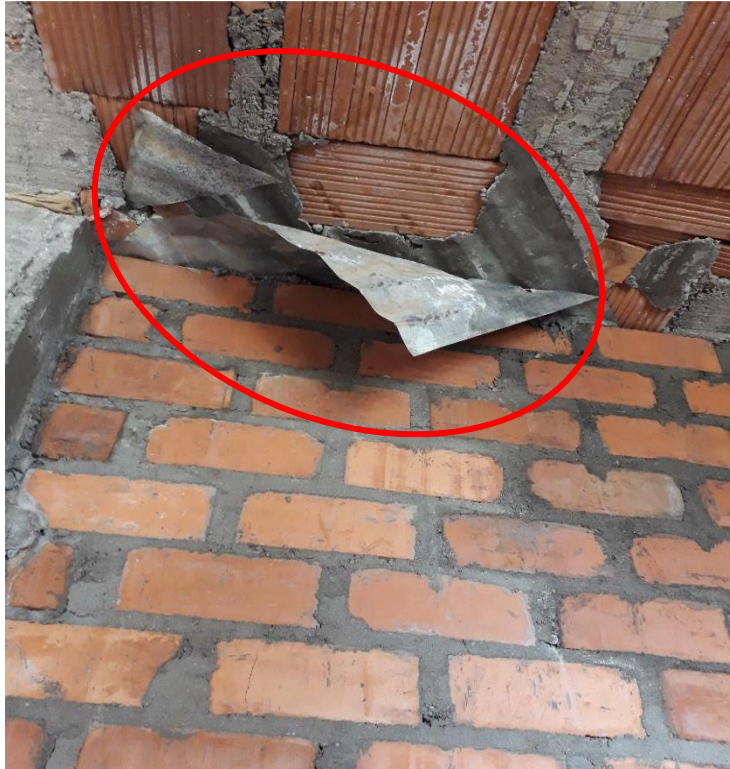
Fotografía N°29: Se utilizó calamina para realizar el vaciado del concreto en el techo
