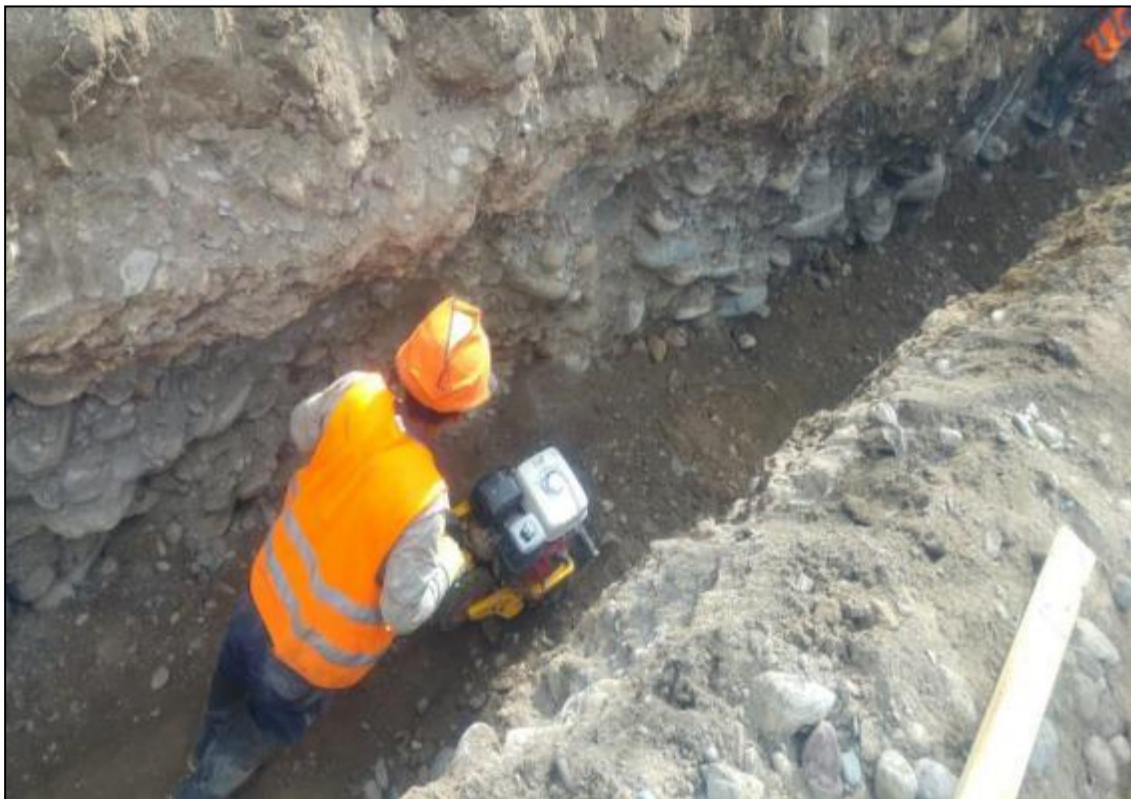
FOTOGRAFIA 4 - TRABAJO DE COMPACTACION DE ZANJA SEGUNDA CAPA
