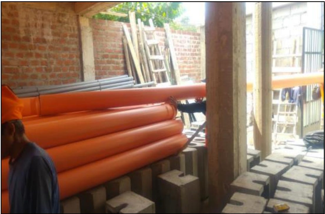
FOTOGRAFIA 20 - ALMACENAMIENTO DE TUBERIA DE ALCANTARILLADO
