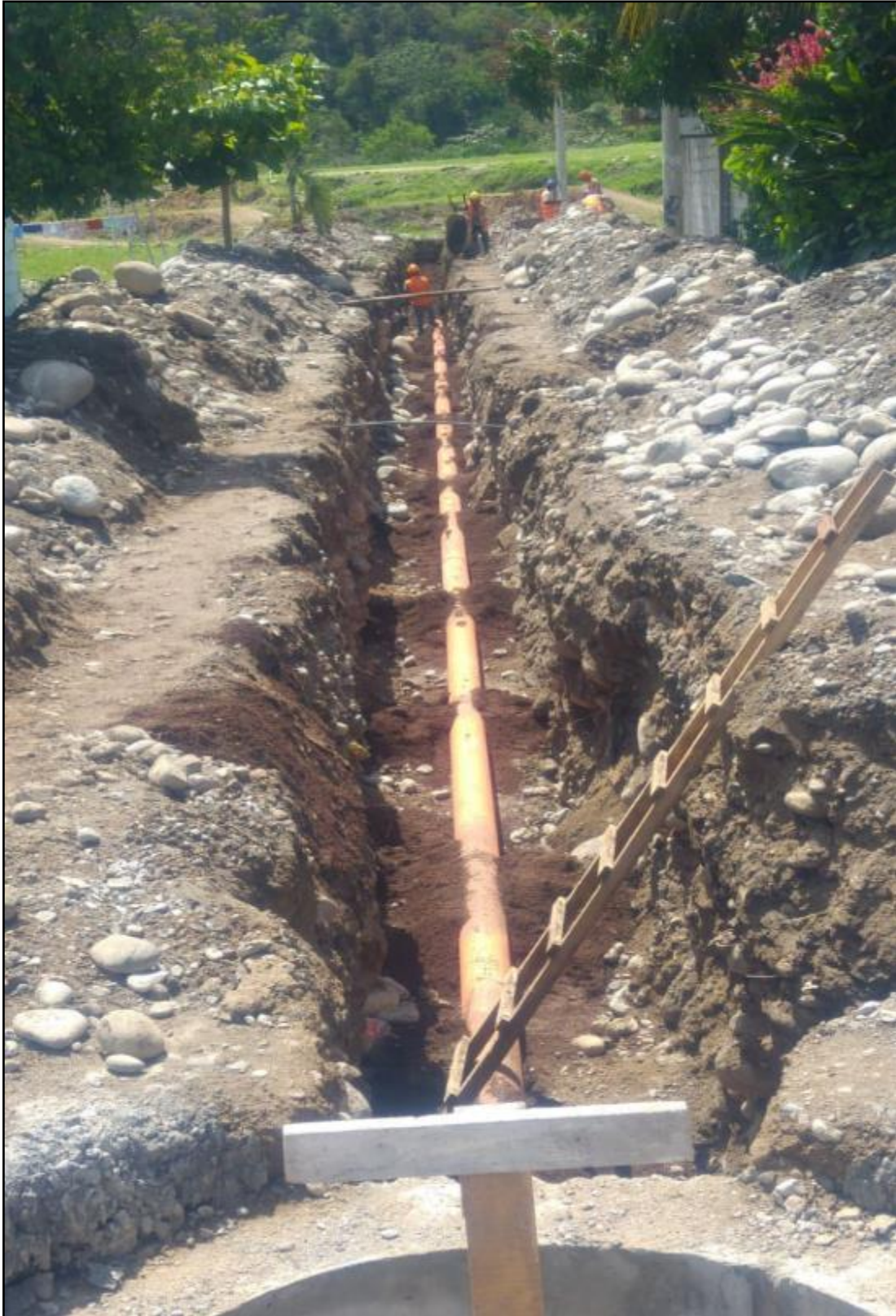
FOTOGRAFIA 13 - TRABAJO DE INSTALACION DE TUBERIA DE ALCANTARILLADO
