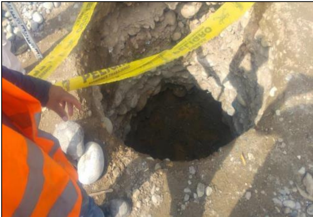
FOTOGRAFIA 2 - TRABAJO DE SEÑALIZACION EN BUZON EXCAVADO
