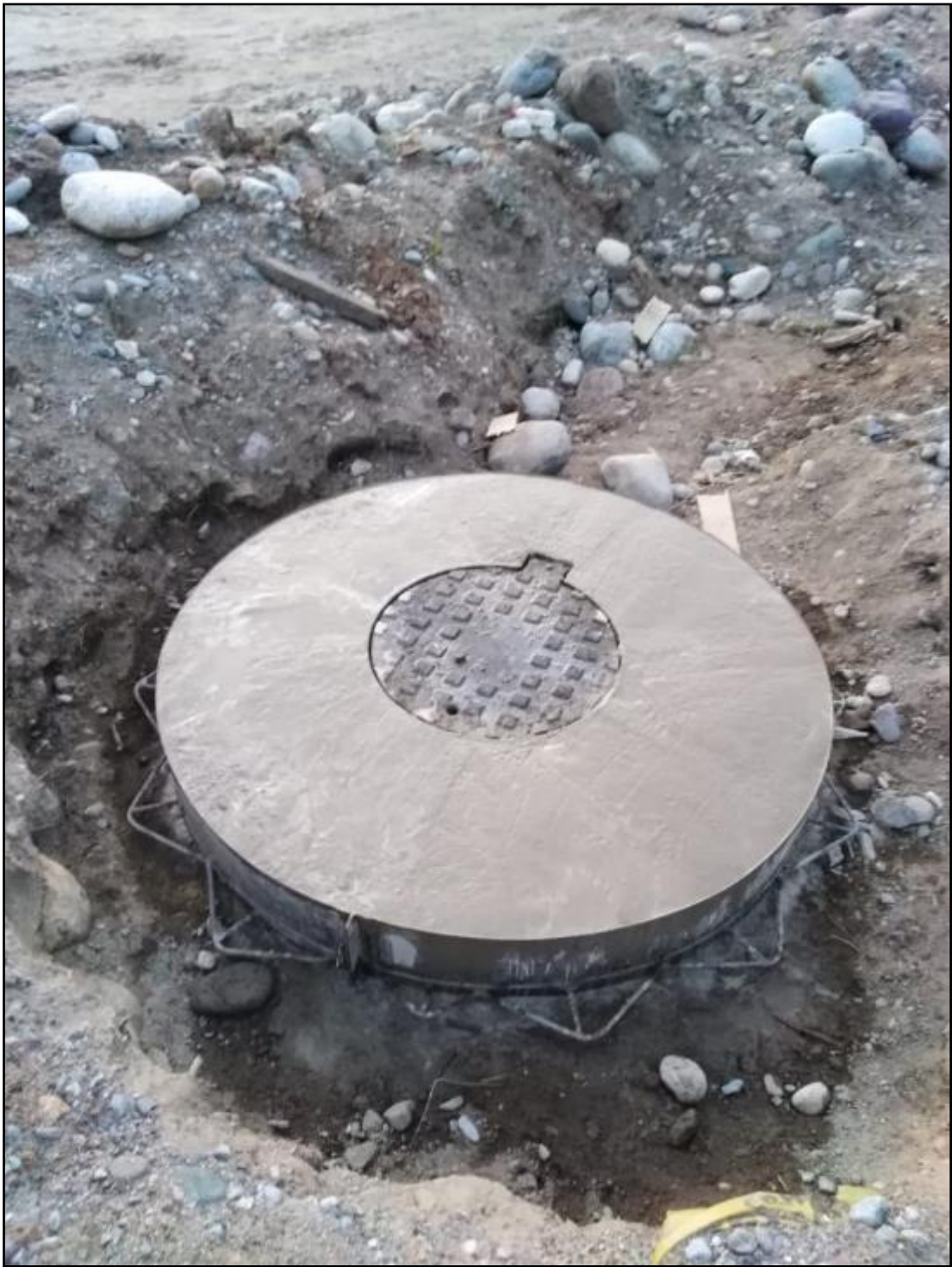
FOTOGRAFIA 24 - TRABAJO DE CONSTRUCCION DE TAPAS DE BUZON
