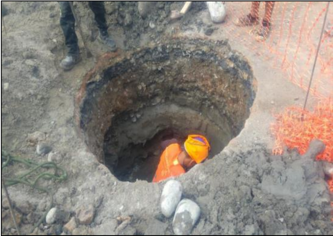
FOTOGRAFIA 21 - TRABAJO DE EXCAVACION DE BUZON
