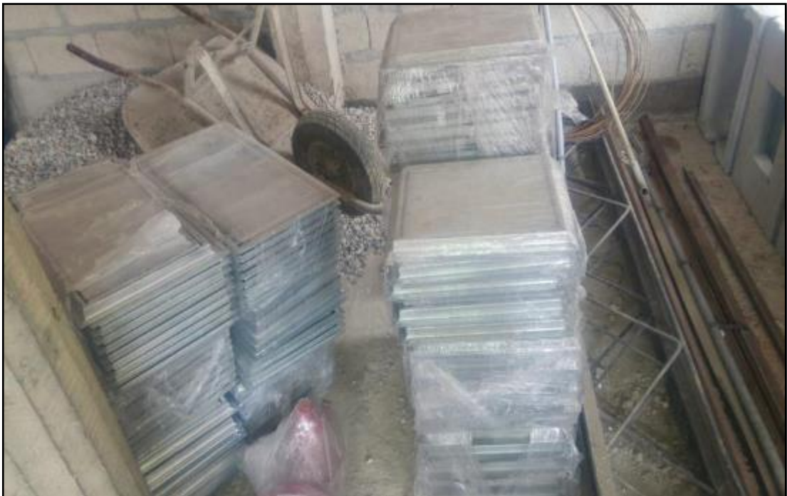
FOTOGRAFIA 18 - ALMACENAMIENTO DE TAPAS PARA CAJAS DE REGISTRO DE AGUA POTABLE Y ALCANTARILLADO
