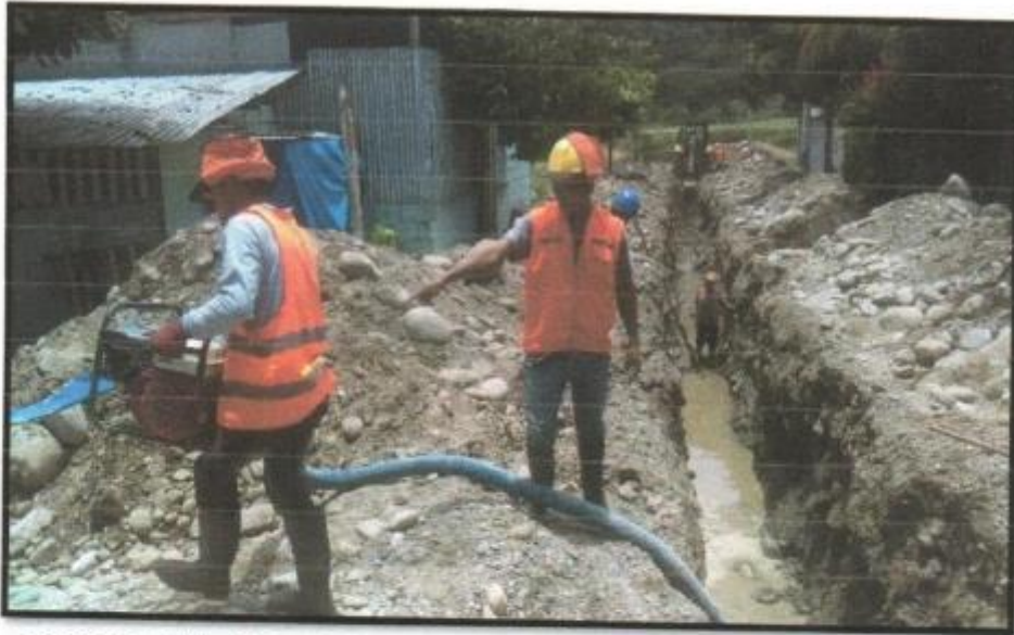
FOTOGRAFIA N°5.- EXCAVACIONES DE ZANJA CON MAQUINARIA PRESENCIA DE AGUA SUBTERRANEAS Y USO DE MOTOBOMBA DE 3" EN LA OBRA DEL PROYECTO "AMPLIACIÓN DE LA RED DE AGUA POTABLE Y ALCANTARILLADO DEL ASENTAMIENTO HUMANO JULIO LA ROSA – LA MERCED – CHANCHAMAYO – JUNÍN"
