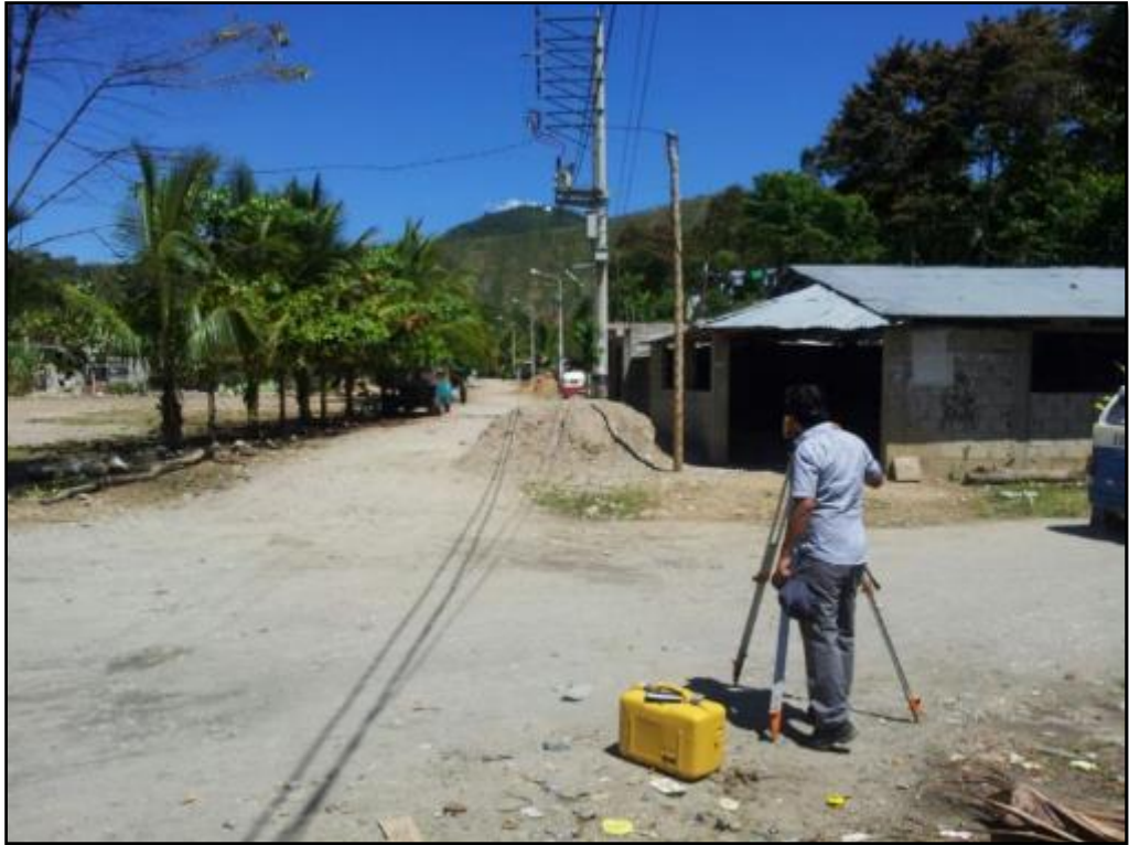
FOTOGRAFIA 1 - TRAZO Y REPLANTEO
