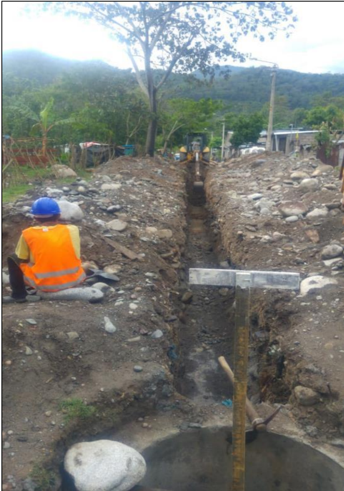
FOTOGRAFIA 5 - TRABAJO DE EXCAVACION DE ZANJA CON MAQUINARIA PESADA
