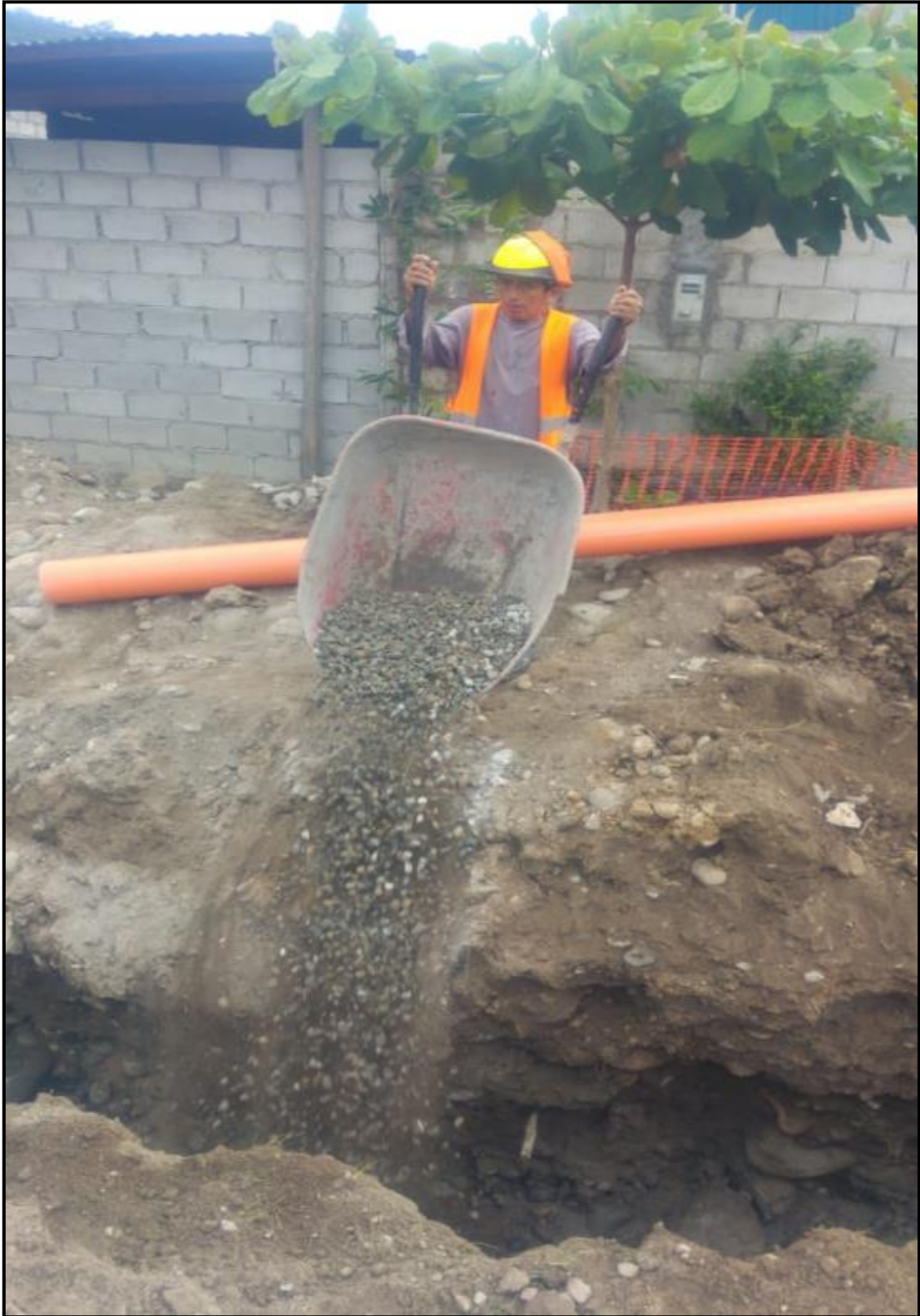
FOTOGRAFIA 23 - TRABAJO DE RELLENO DE ZANJA CON MATERIAL PROPIO
