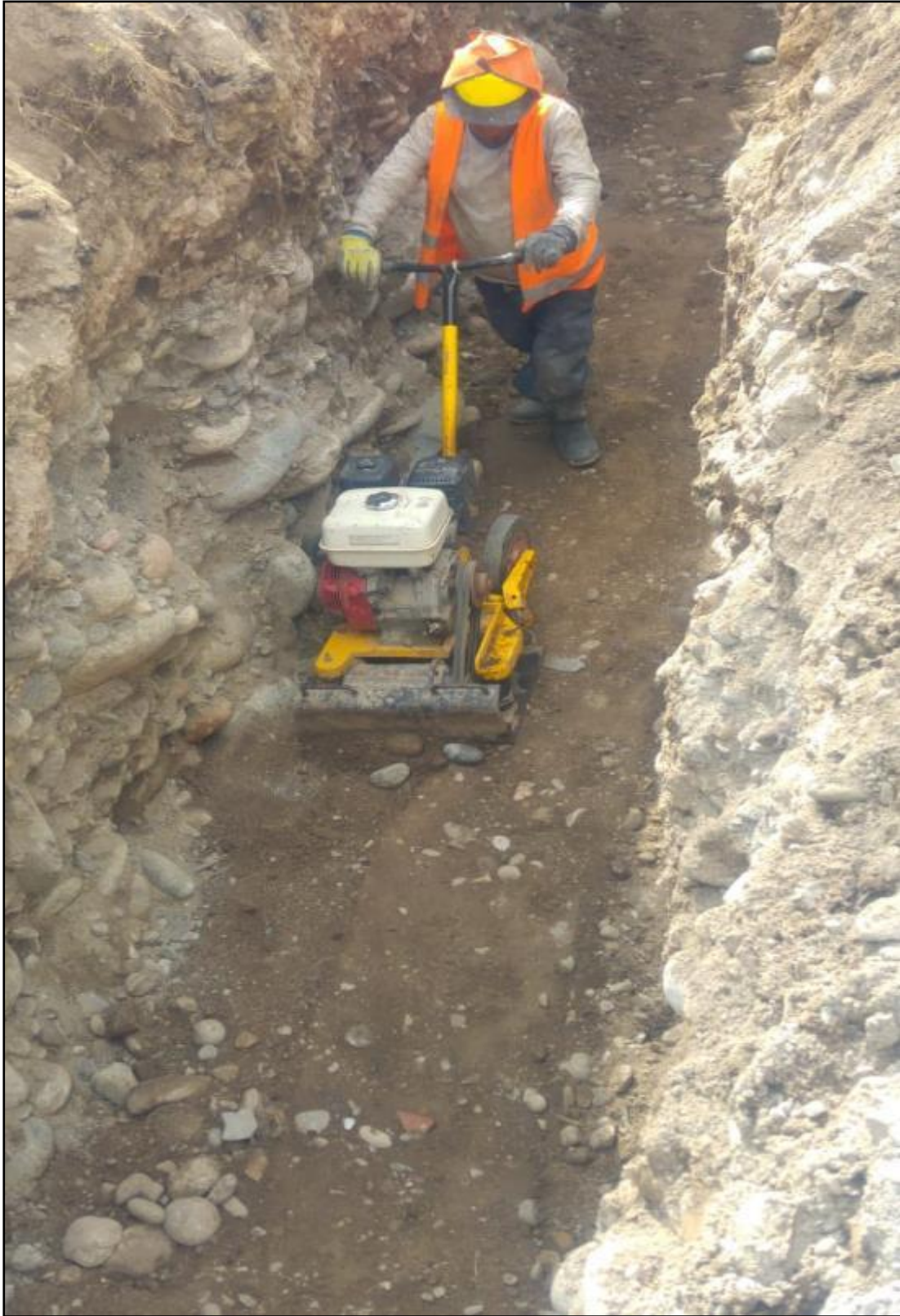
FOTOGRAFIA 9 - TRABAJO DE COMPACTADO DE ZANJA
