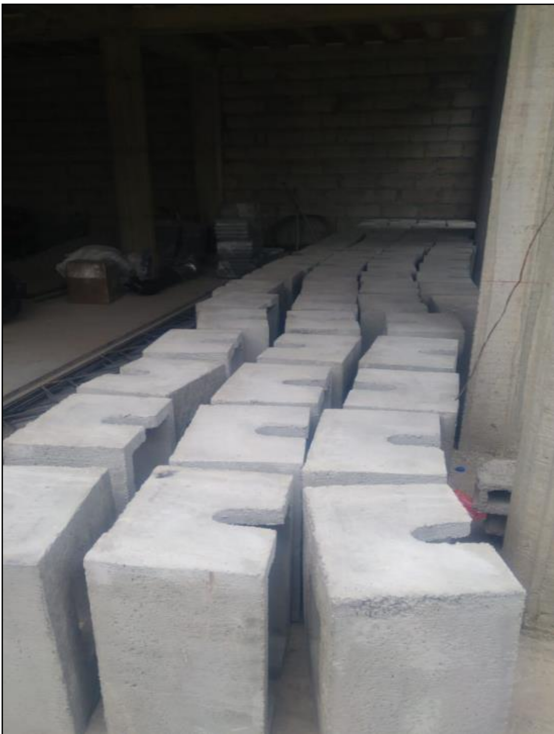
FOTOGRAFIA 16 - ALMACENAMIENTO DE CAJAS DE REGISTRO DE ALCANTARILLADO
