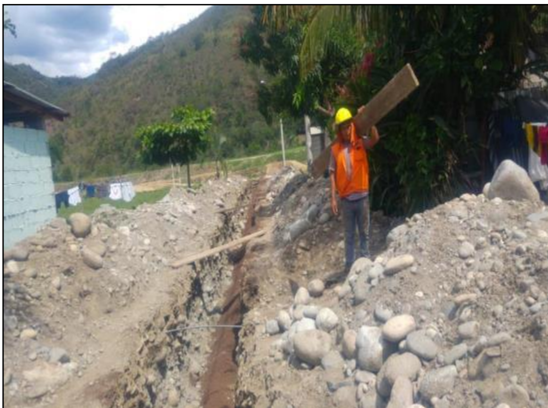
FOTOGRAFIA 14 - RELLENO DE ZANJA CON MATERIAL ZARANDEADO
