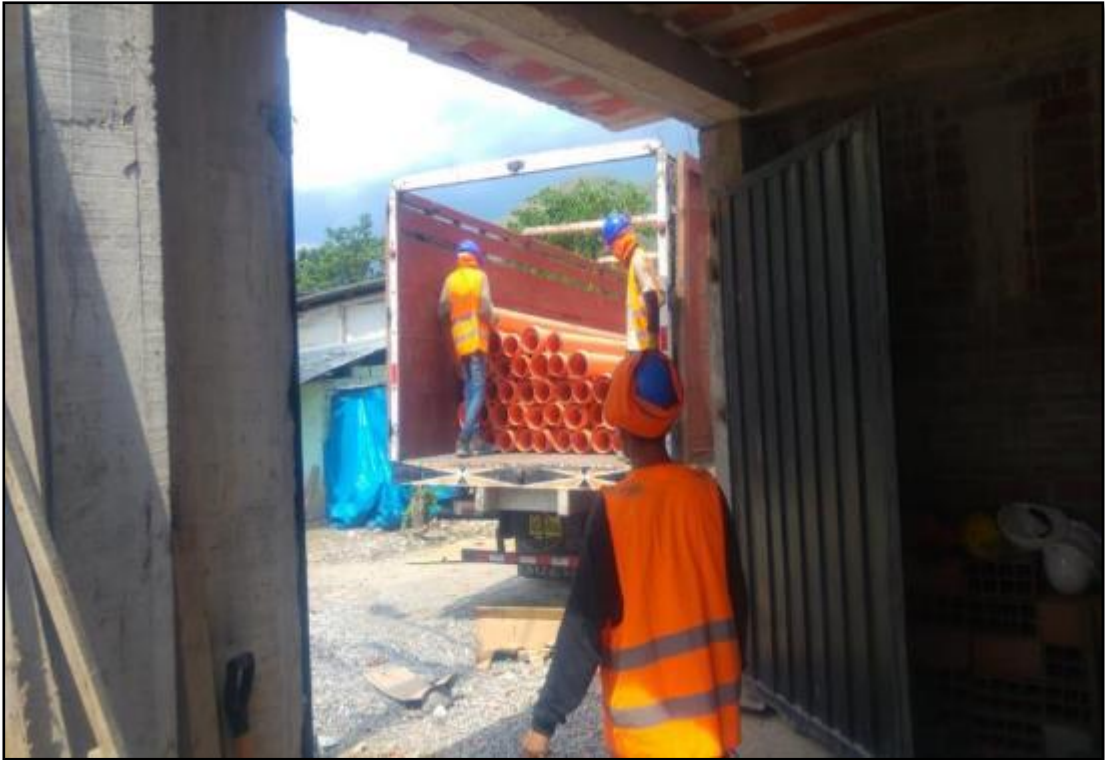
FOTOGRAFIA 19 - DESCARGA DE TUBERIA DE ALCANTARILLADO
