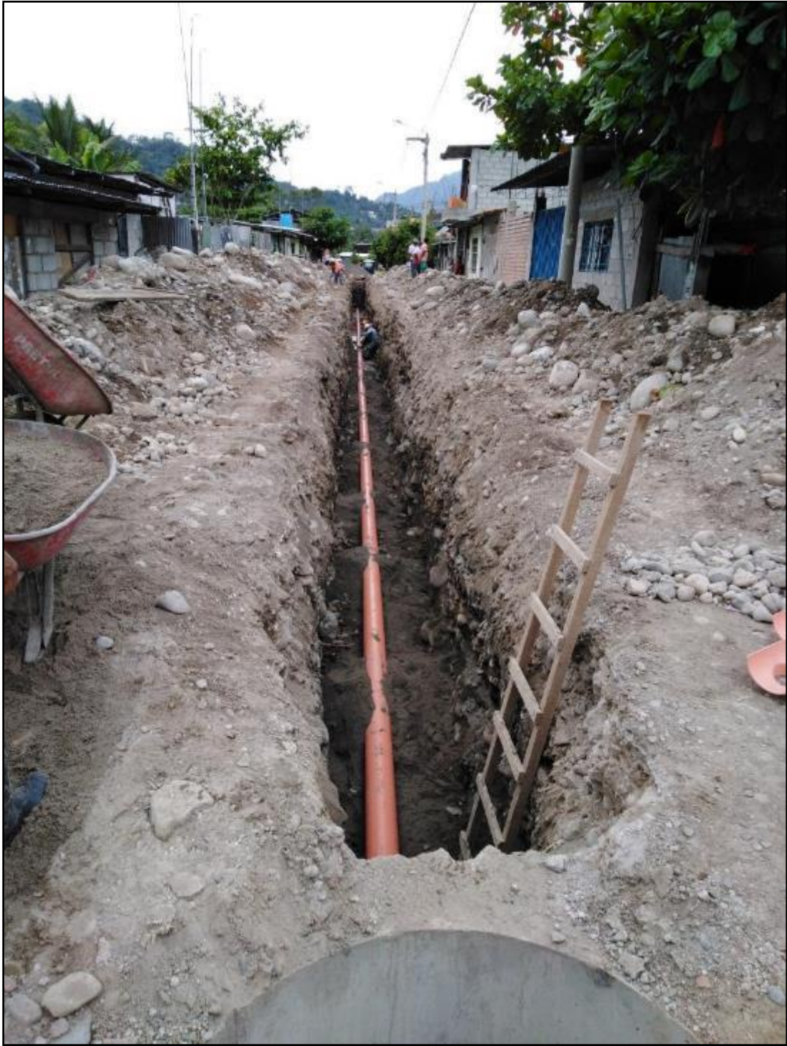
FOTOGRAFIA 6 - INSTALACION DE TUBERIA DE ALCANTARILLADO
