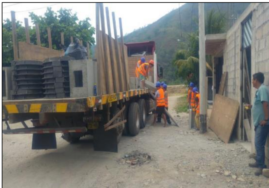
FOTOGRAFIA 15 - TRABAJOS DE DESCARGA DE MATERIALES
