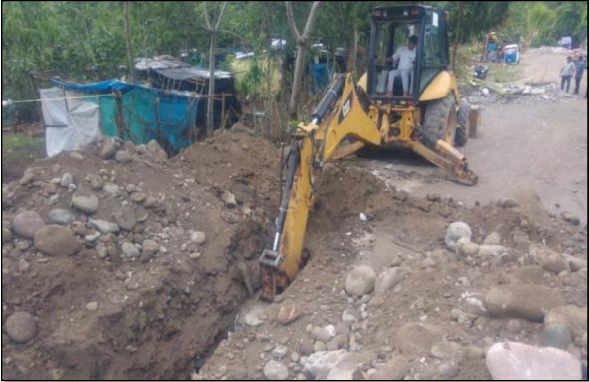
FOTOGRAFIA 7 - TRABAJO DE EXCAVACION DE ZANJA CON MAQUINARIA PESADA
