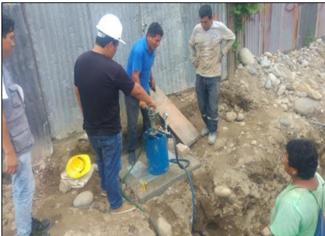
FOTOGRAFIA 22 - PRUEBA HIDRAULICA EN RED DE AGUA POTABLE CON BALDE HIDRAULICO
