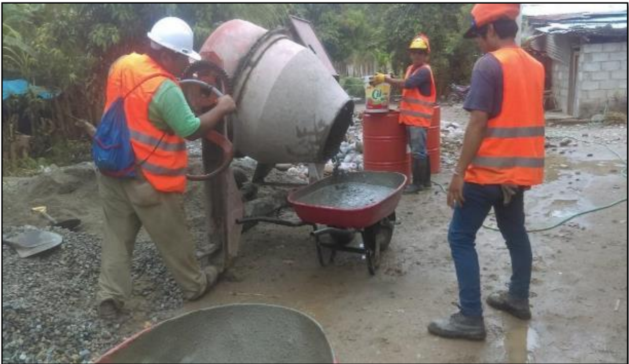
FOTOGRAFIA 8 - ELABORACION DE CONCRETO PARA BUZON
