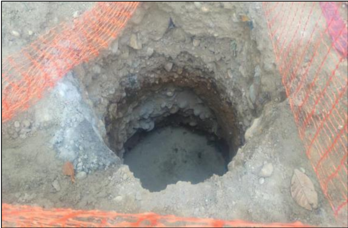
FOTOGRAFIA 3 - TRABAJO DE EXCAVACION DE BUZON
