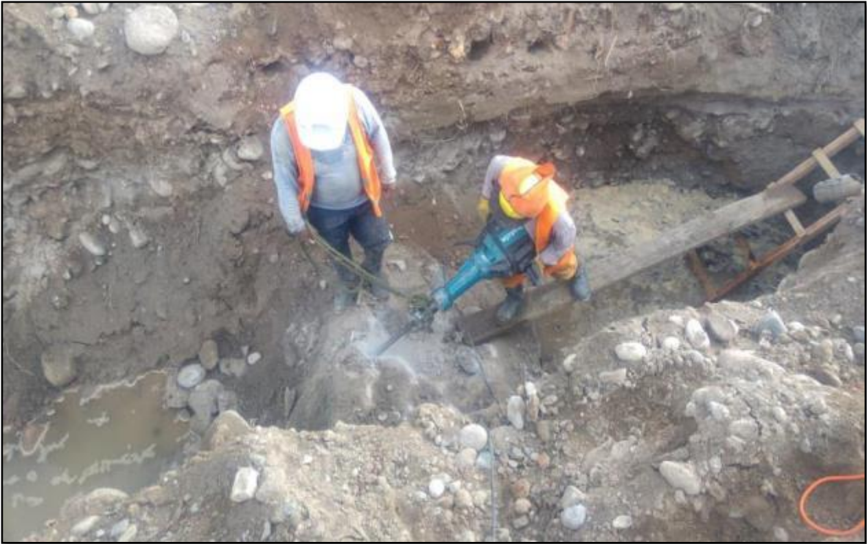
FOTOGRAFIA 11 - TRABAJO DE ROTURA DE ROCA
