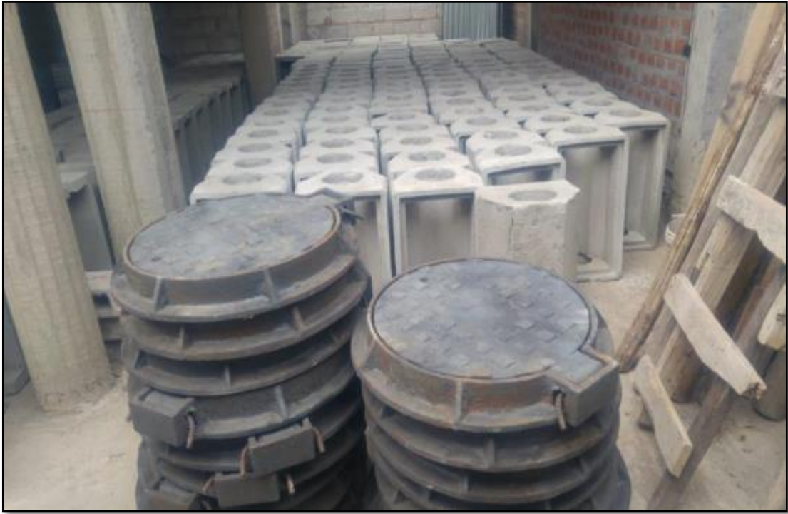
FOTOGRAFIA 17 - ALMACENAMIENTO DE CAJAS DE REGISTRO Y TAPAS PARA BUZON
