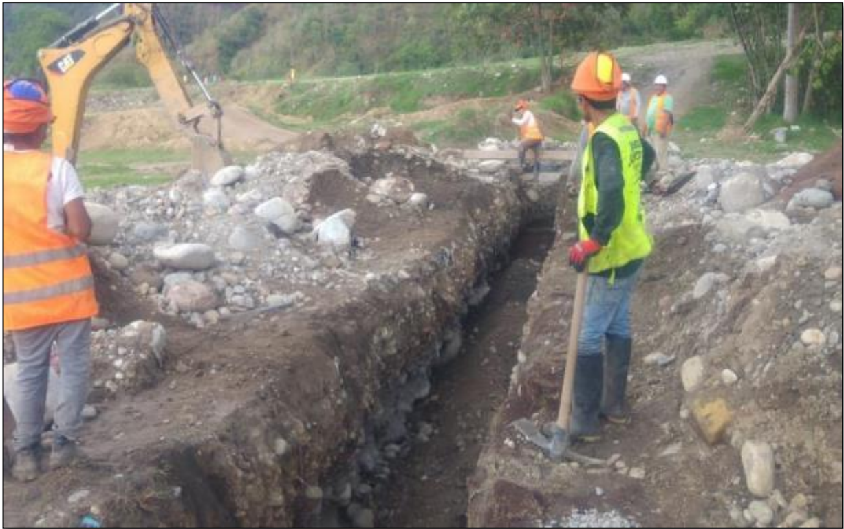
FOTOGRAFIA 10 - TRABAJOS DE EXCAVACION Y RELLENO DE ZANJA
