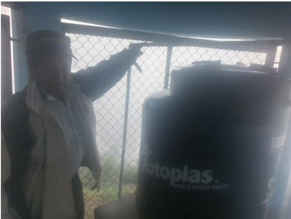
Fotografía 2. Inspección del antiguo sistema de cloración.
