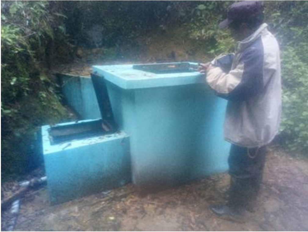
Fotografía 3. Inspección de la captación desde el exterior.
