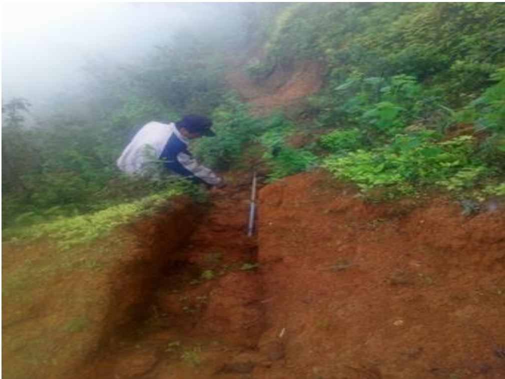
Fotografía 4. Inspección de la línea de conducción del sistema.
