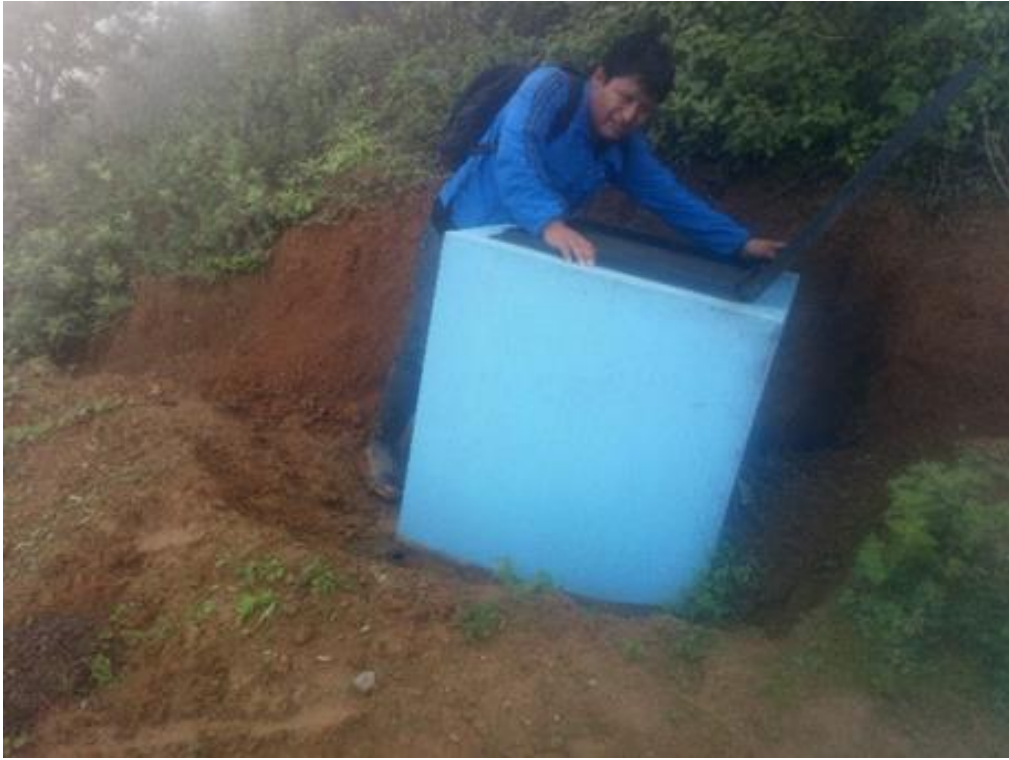
Fotografía 5. Inspección de la cámara rompe presión en la línea de conducción.
