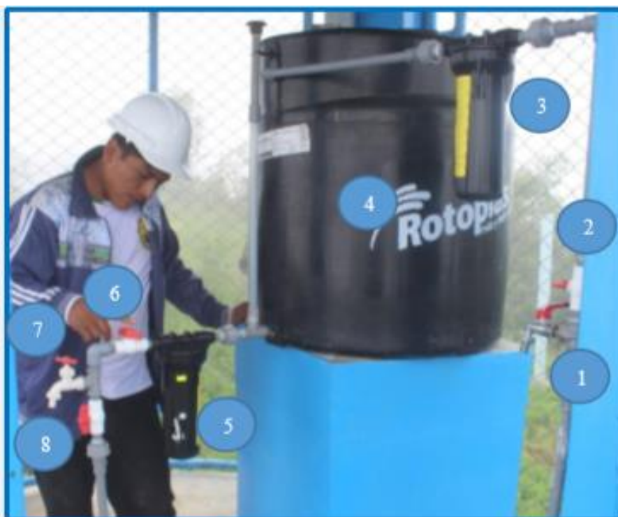
Figura 10. Instalación del sistema de goteo controlado.
