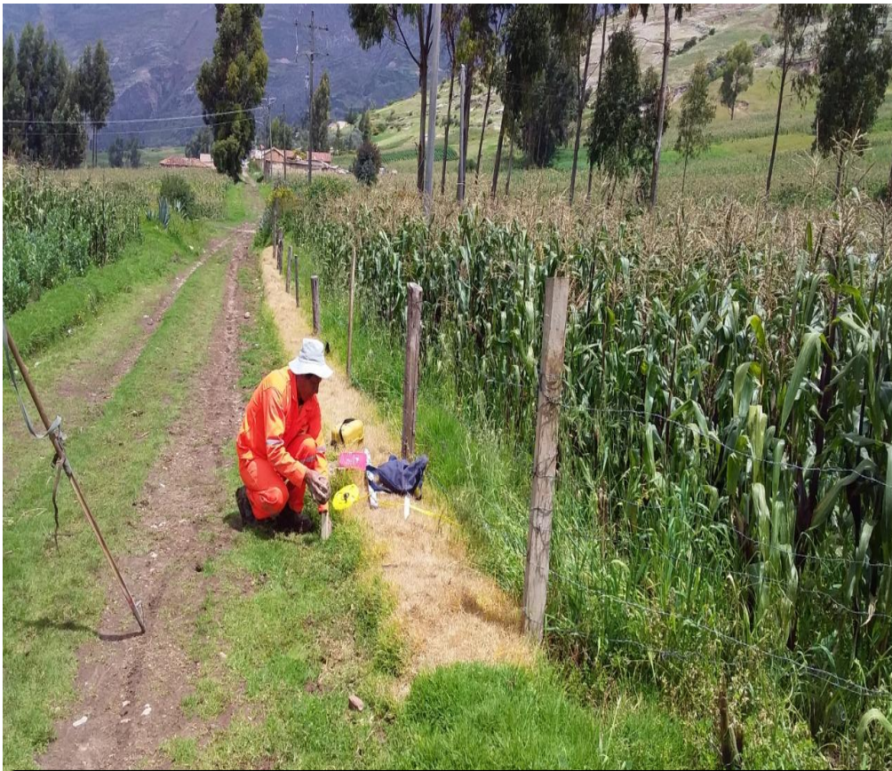
FOTO N° 06: En la fotografía se puede apreciar la colocación de los puntos con estacas, donde se construirán las válvulas, cámaras y para el trazado de la red.
