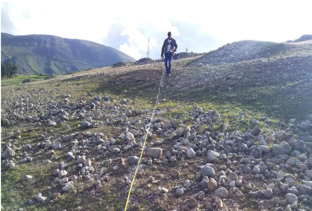
FOTO N° 02: En la imagen se puede apreciar realizando trabajos de medición con wincha, en el terreno por donde se trazaré el diseño del riego tecnificado.
