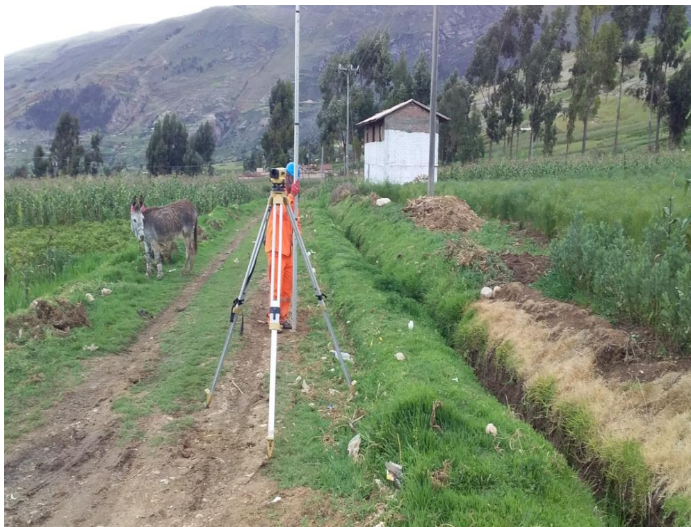
FOTO N° 07: En la imagen se puede observar que la red de distribución se construirá a lado de las carreteras y por el medio de los terrenos de cultivos.
