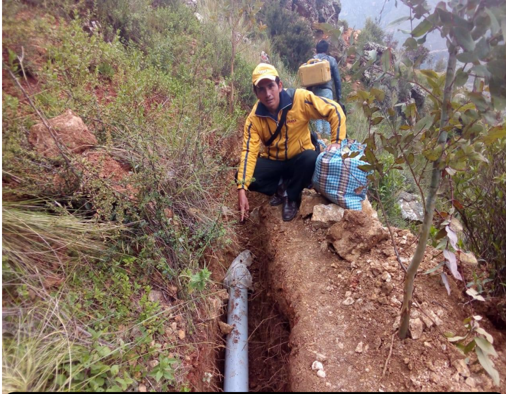
FOTO N° 11: En la fotografía se puede apreciar el lugar donde empezara la línea de distribución para el servicio de riego tecnificado por aspersión para la producción agrícola de la zona en el distrito de Chambara - Concepción – Junín.
