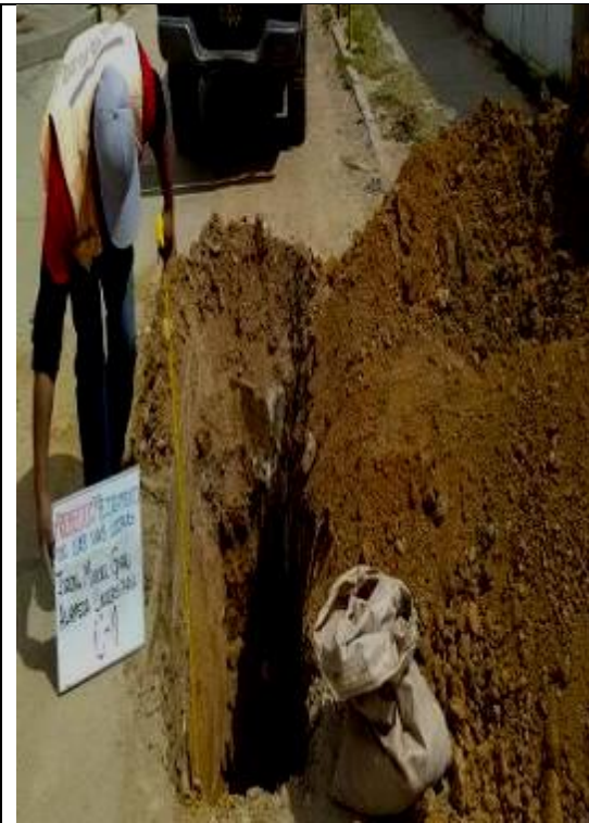
Medición de la profundidad y muestreo de la calicata 01
