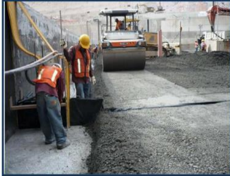
Figura 1: Construcción de represas con Concreto Compactado con Rodillo
