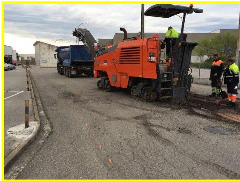
IMAGEN 10.Fresado de Pavimento.
