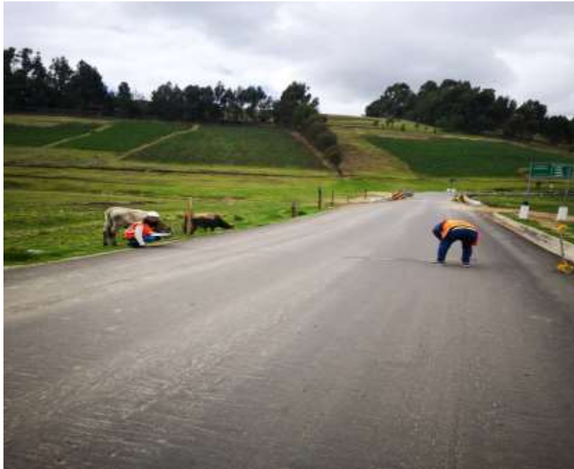
FOTOGRAFIA N° 31: Medición de calzada
