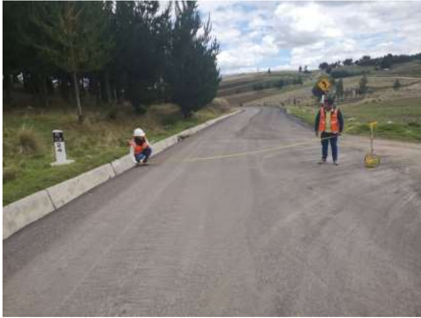
FOTOGRAFIA N° 36: Medición de calzada al termino del tramo KM 24
