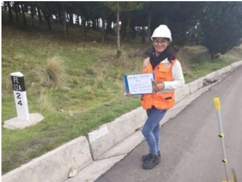
FOTOGRAFIA N° 37: Medición de calzada (FIN DEL TRAMO)
