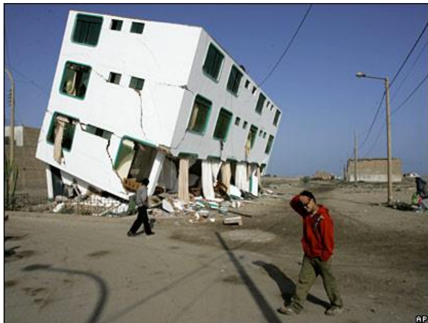
Fig. N°3 Colapso de edificio Multifamiliar sismo de Pisco 2007
