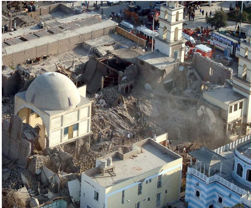
Fig. N°4 Colapso de la iglesia de Pisco 2007
