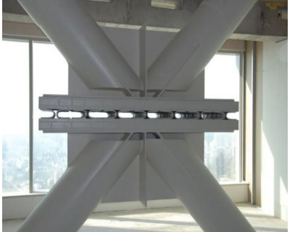
Fig.8 Disipadores por fricción.
