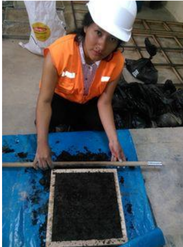
Vista del enrasado del slurry seal en el molde
