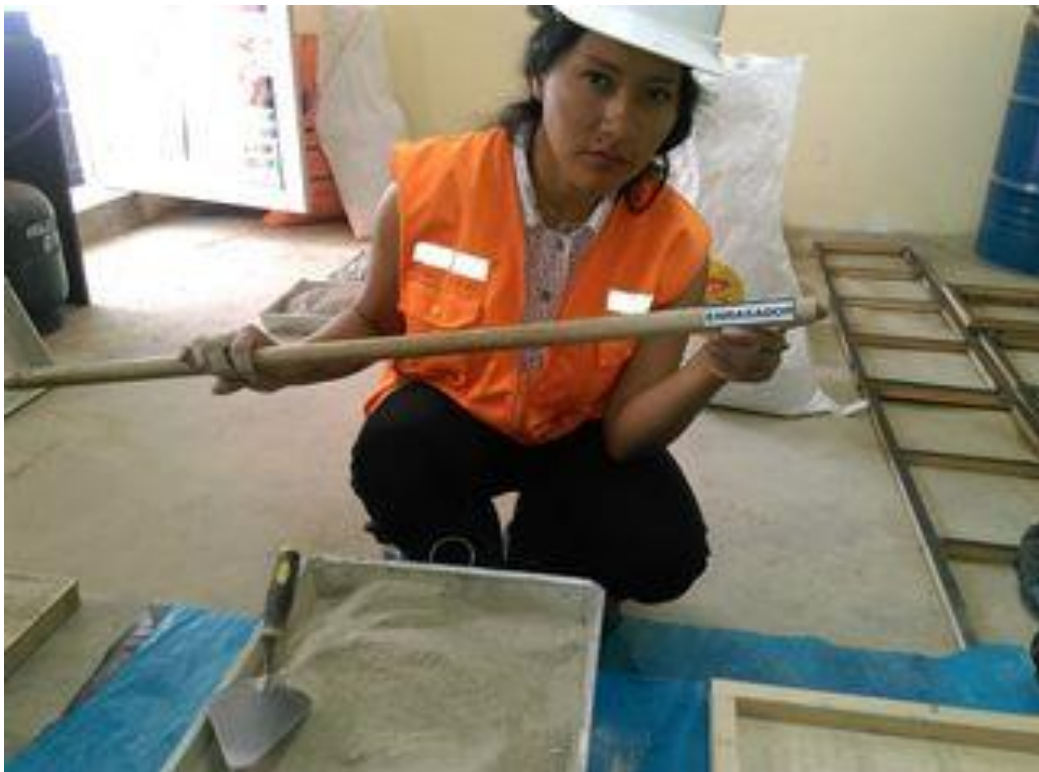
Vista del material para mezcla con la emulsión asfáltica
