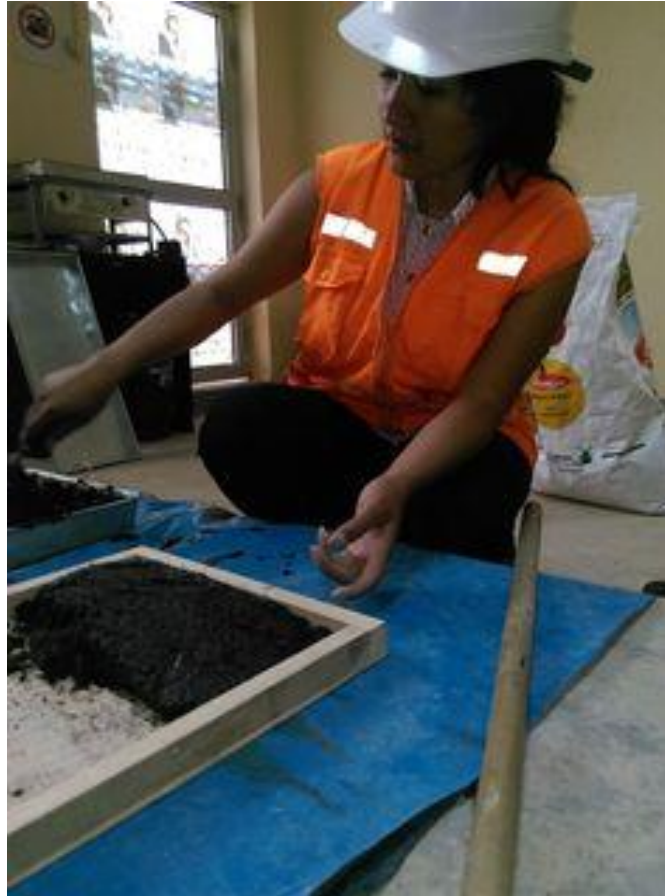
vista de la colocación del slurry seal en los moldes de 30cm x 30 cm
