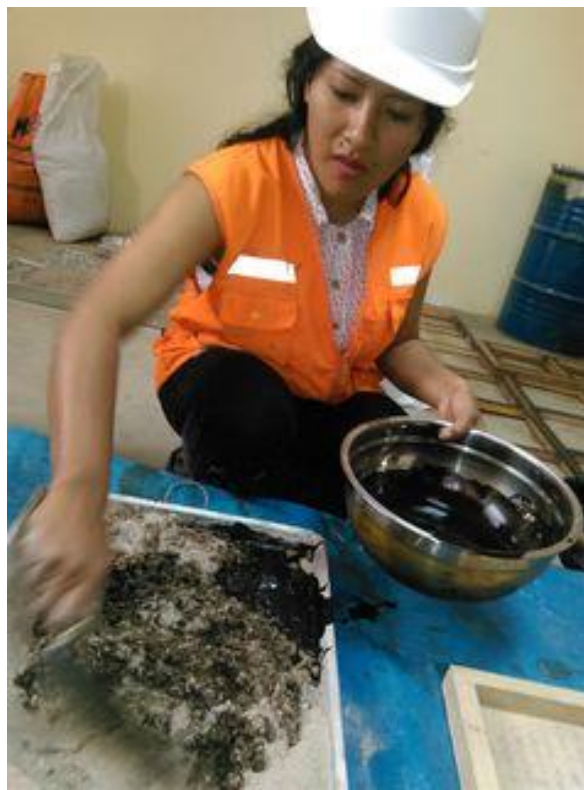
Vista de la mezcla manual del agregado con el asfalto en frio
