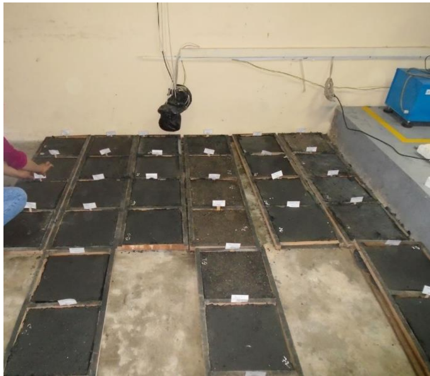
Vista de los moldes para diferentes tipos de agregado y diferente % de emulsión asfáltica.
