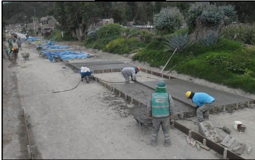
NIVELADO DEL CONCRETO DEL PAVIMENTO
