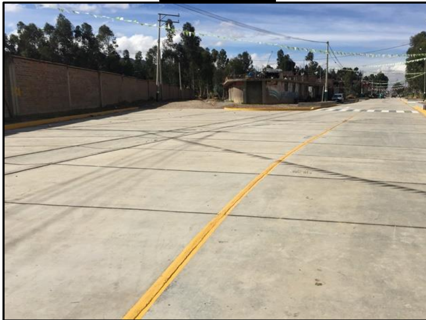
VISTA FINAL DE LA OBRA CONCLUIDA
