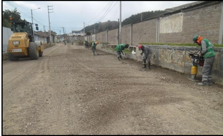
COMPACTACION DEL MEJORAMIENTO DE LA SUB RASANTE CON MATERIAL DE BASE
