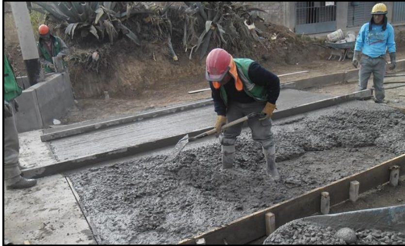
VACIANDO DEL PAVIMENTO CONCRETO F´C=280KG/CM2 PROG 0+500
