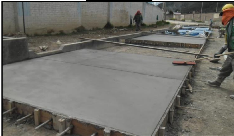
ACABADO EN LOSAS DE CONCRETO
