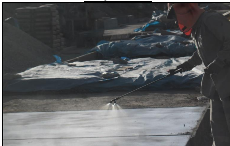
CURADO DEL PAVIMENTO – CURADO ADITIVO
