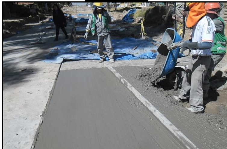
VACIANDO DEL PAVIMENTO CONCRETO F´C=280KG/CM2 PROG 0+500 – PROG 0+540
