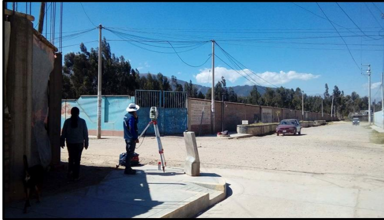
LEVANTAMIENTO TOPOGRÁFICO EN LA PROGRESIVA 0+000 AV. ALAMEDA Y JR. BOLIVIA.
