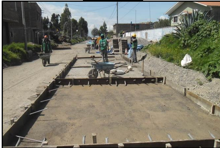
ENCOFRADO Y COLOCADO DE DOWELL
