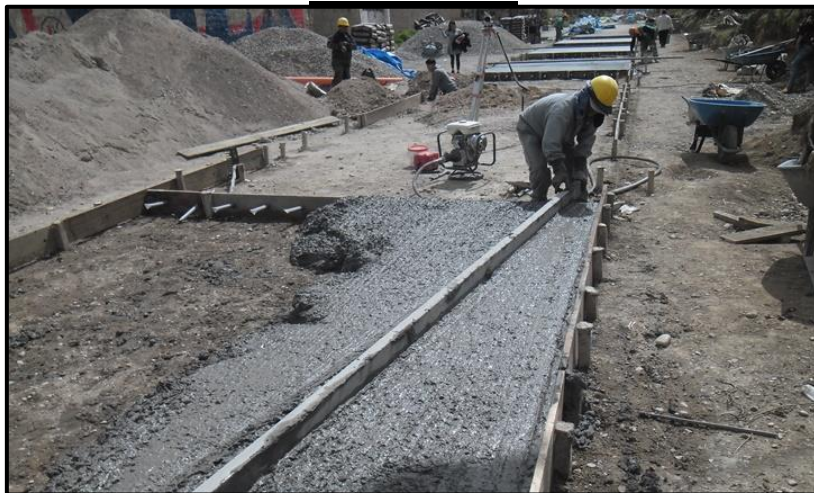
REGLEADO DEL PAVIMENTO RIGIDO
