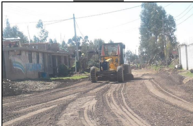
CONFORMACION DEL MEJORAMIENTO DE LA SUB RASANTE CON MATERIAL DE BASE
