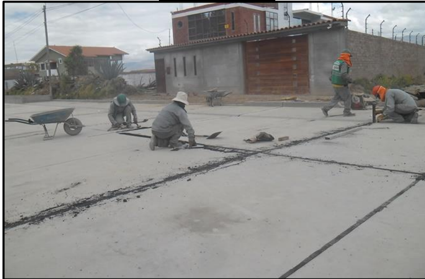
SELLADO DE JUNTAS EN EL PAVIMENTO RIGIDO
