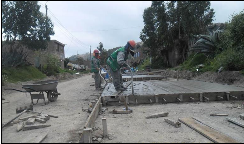
VIBRADO DEL VACIADO DEL CONCRETO DEL PAVIMENTO
