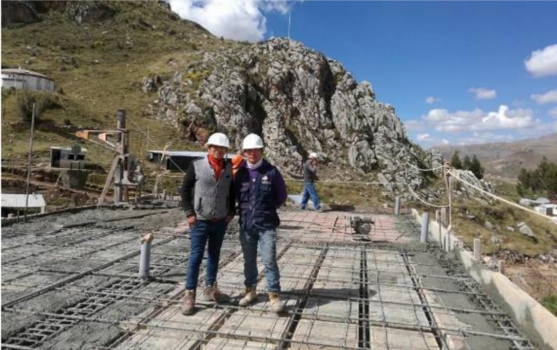
Fotografía 03: Colocación de concreto en losa aligerada de 25cm
