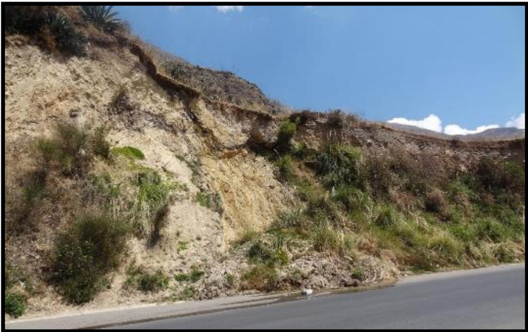
Fotografía N° 08 En el cuarto talud hay la presencia de flujos de limos.
