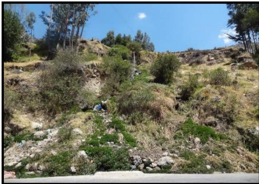
Figura 17. Segundo talud inestable, mal drenaje
