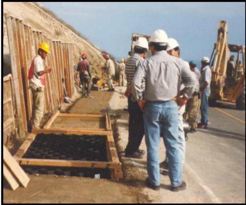
Fotografía N° 09 Forma de instalación de las geoceldas
