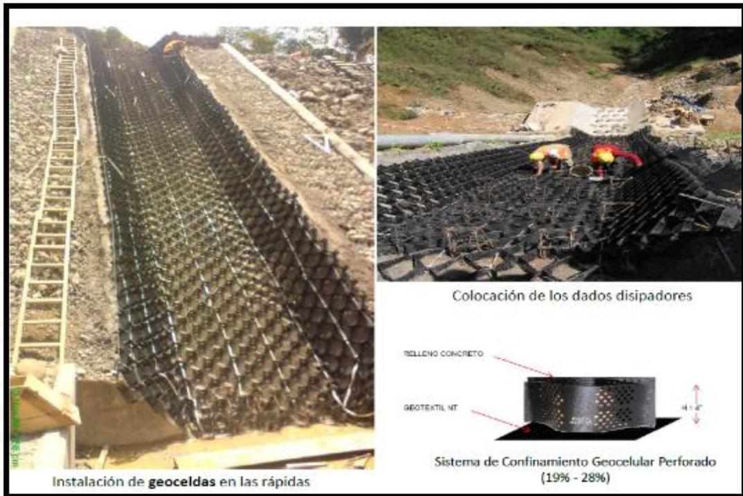
Fotografía N° 11 Diseño de las cunetas con geoceldas y rellenas con concreto.
