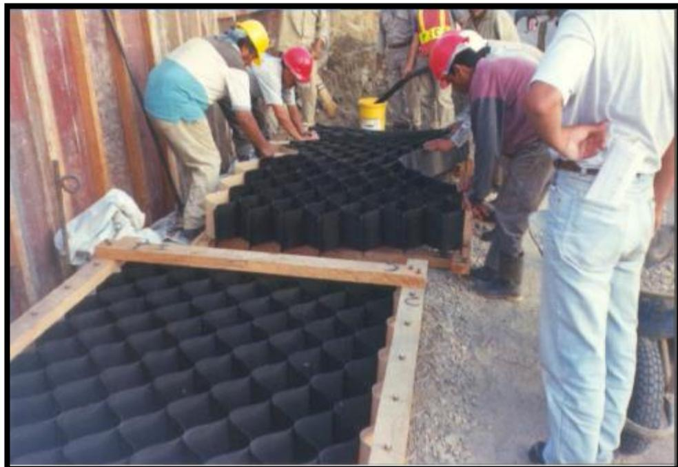
Fotografía N° 10 Forma de instalación de las geoceldas
