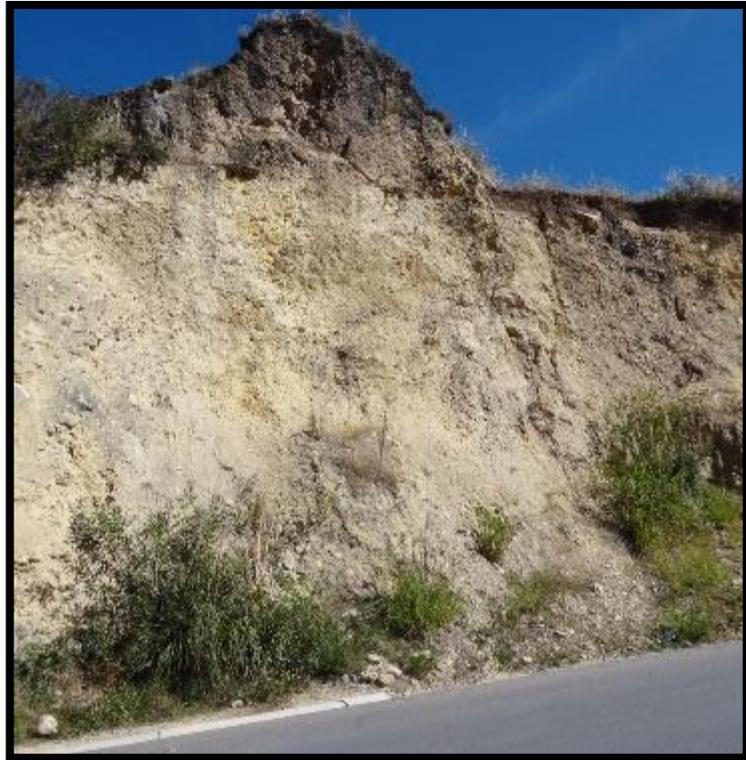
Figura 18. Tercer talud inestable, está en peligro la caída de una roca
