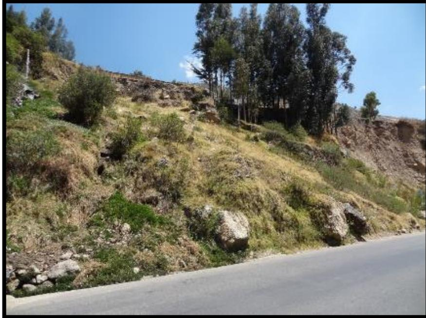
Figura 16. Segundo talud inestable, deslizamiento traslacional.
