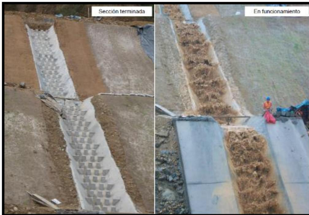
Figura 52. Cunetas diseñadas con geoceldas y rellenas con concreto que contienen reductoras dentadas.
