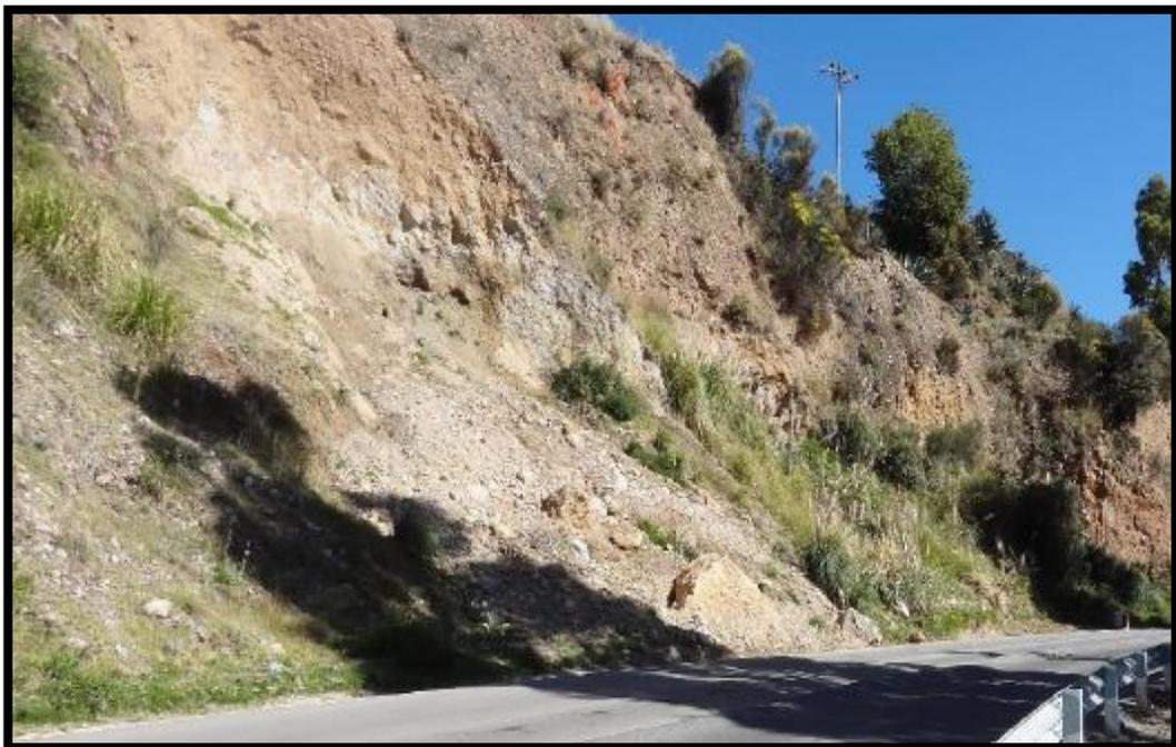
Figura 15. Primer talud inestable, colada de derrubios
