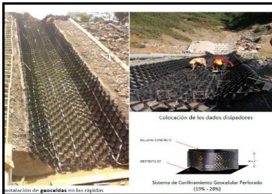
Figura 50. Instalación de las geoceldas en la cuneta
