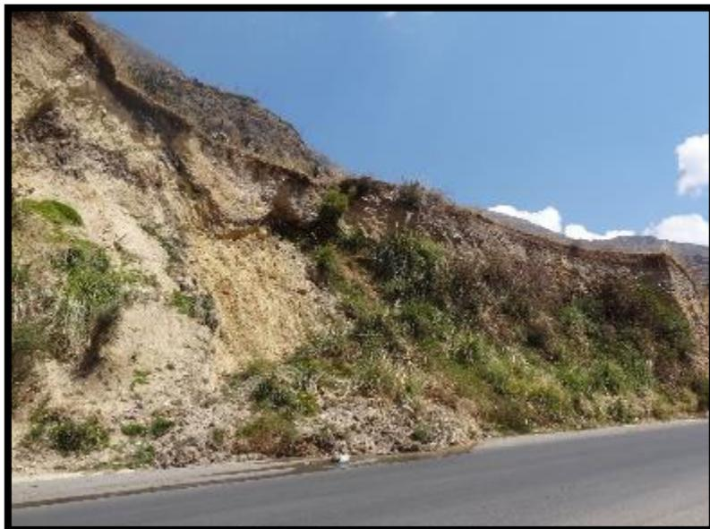
Figura 19. Tercer talud inestable, talud con movimiento de flujos
