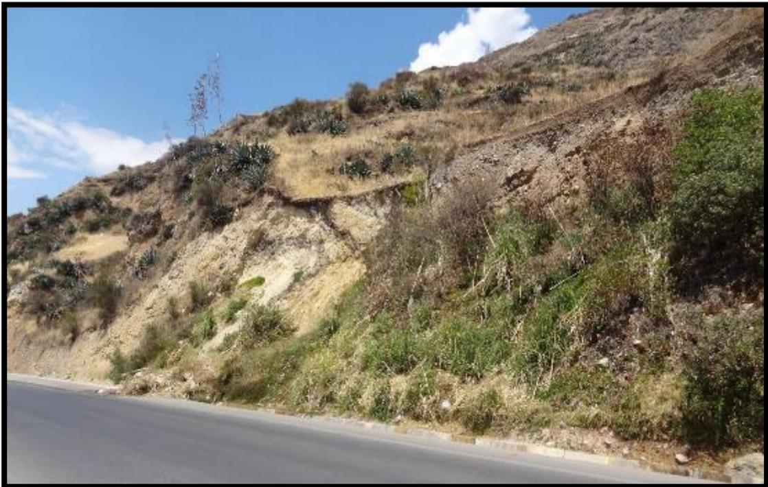
Fotografía N° 06. Cuarto talud crítico “deslizamiento traslacional y flujos o coladas”
