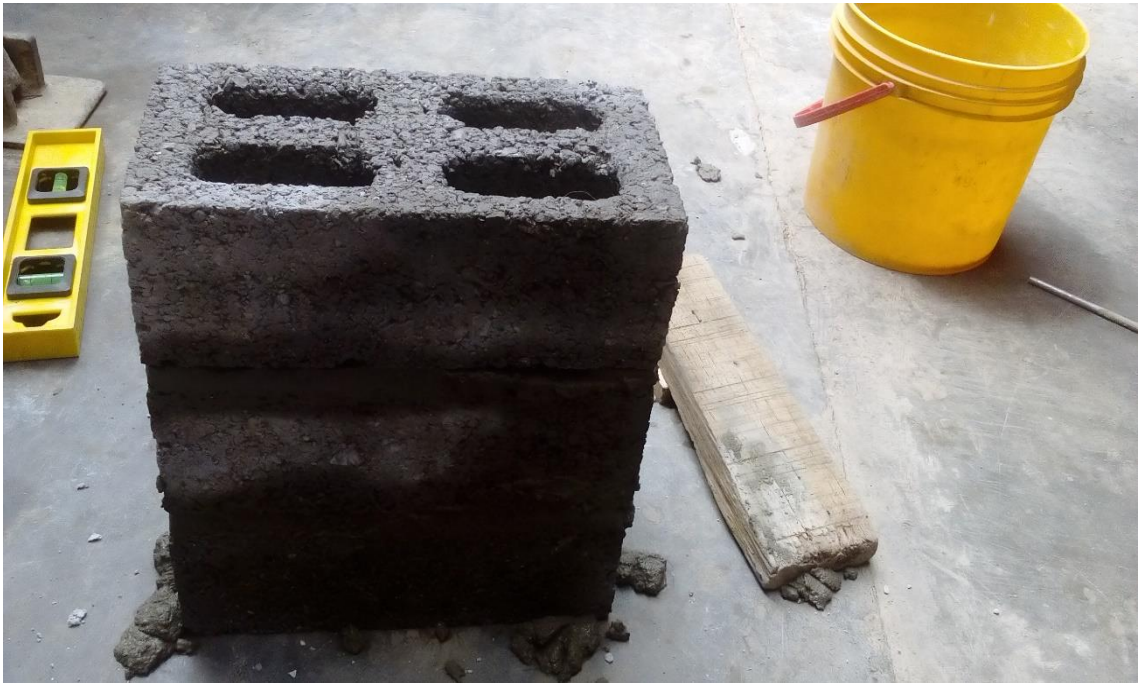
Fotografía 39. Construcción de pila con PET- porcelanato
