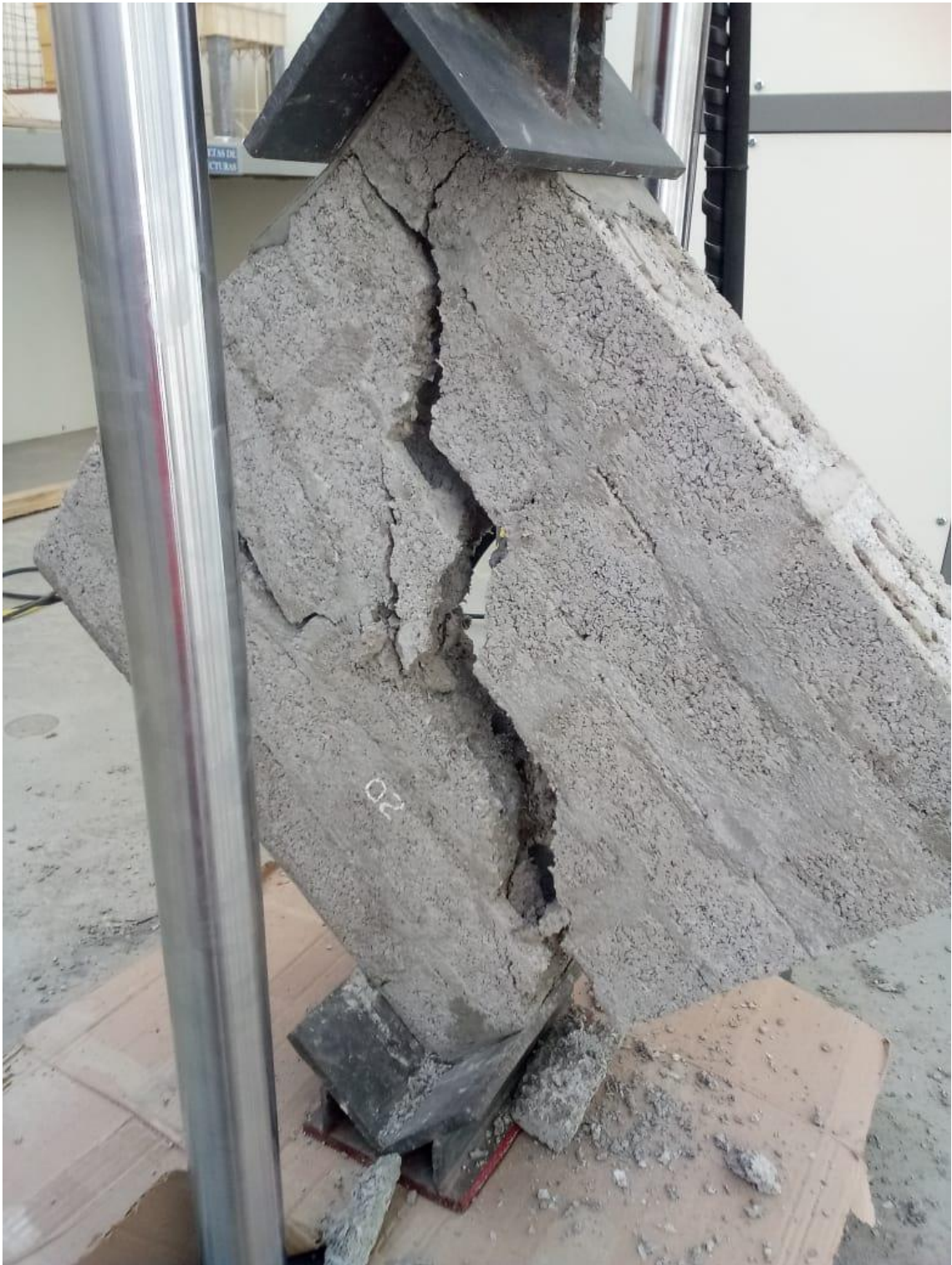
Fotografía 56 Ensayo de resistencia a compresión diagonal en murete con 20 % falla por escalonamiento
