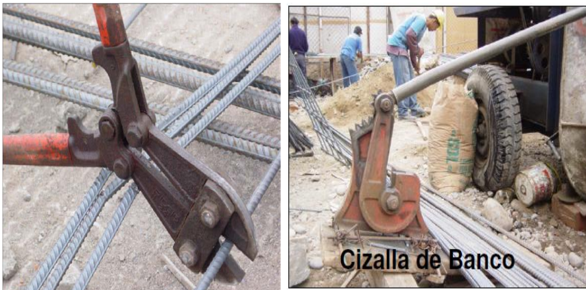
FIGURA N° 13: HABILITACION DE ACERO EN OBRA.
