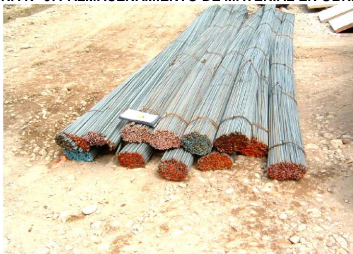
FIGURA N° 07: ALMACENAMIENTO DE MATERIAL EN OBRA.
