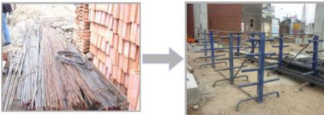
FIGURA N° 17: COMPARATIVO DE ALMACENAMIENTO DE MATERIAL. HABILITAR EN OBRA ACERO DIMENSIONADO
