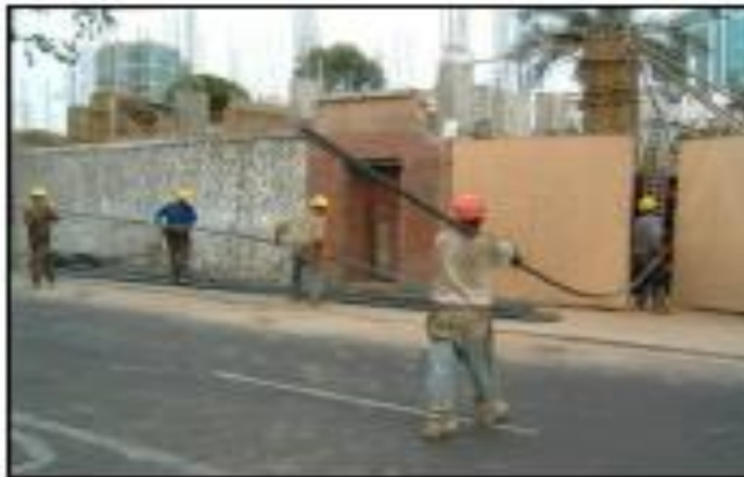
FIGURA N° 06: PERSONAL REQUERIDO PARA EL TRASLADO DE MATERIAL.
