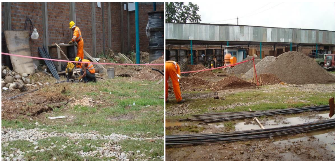
FIGURA N° 02: METODO TRADICIONAL DE CORTE DE VARILLAS DE ACERO.
