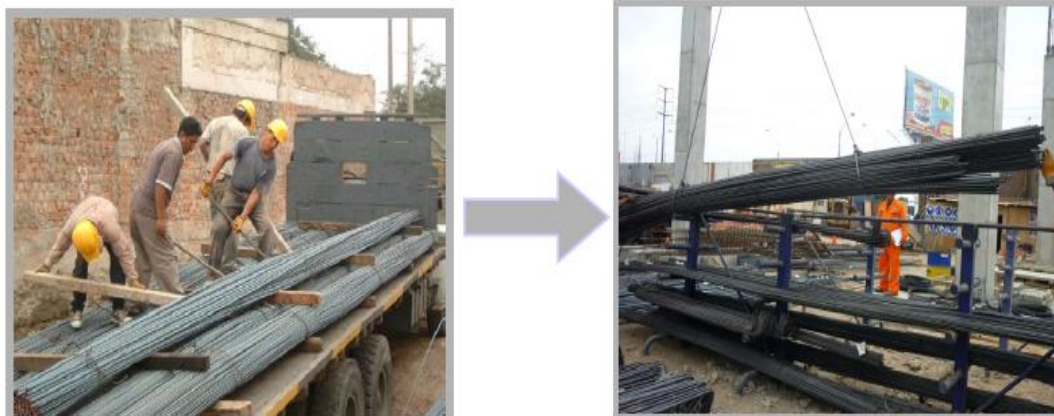
FIGURA N° 16: COMPARATIVO DE RECEPCION DE MATERIAL. HABILITAR EN OBRA ACERO DIMENSIONADO
