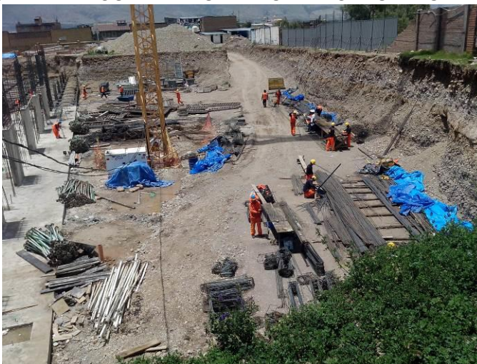
FIGURA N° 12: CORTE Y DOBLADO DE ACERO EN OBRA.
