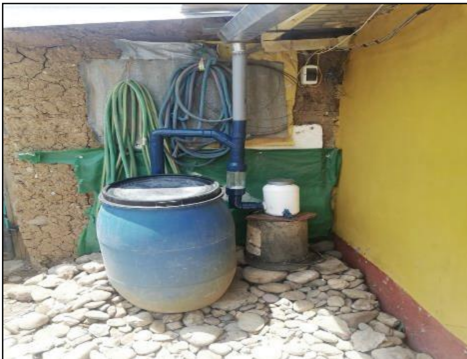
Fotografía N.º 13: Instalación del Sistema Interceptor de Primeras Aguas con capacidad de 3.6 litros para edificación rustica con área de techo de 1.8m de ancho por 2 m de largo en Huancayo 2018.
