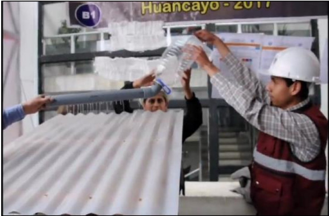
Fotografía N.º 10: Demostración de la acción de la lluvia que tiende a lavar los techos dentro de los 15 – 30 min, siendo almacenados en el Sistema Interceptor de Primeras Aguas
