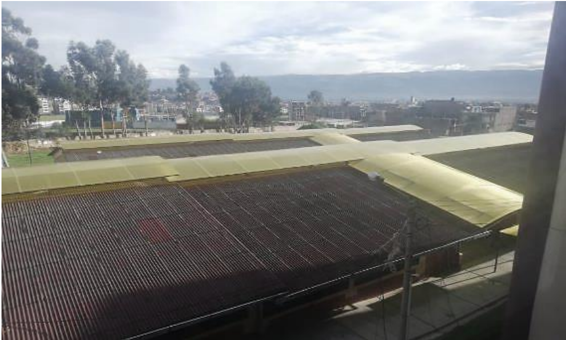
Fotografía N.º 19: Techo del Pabellón “J” y “K” de la Facultad de Ingeniería de la Universidad Peruana Los Andes, 2019.
