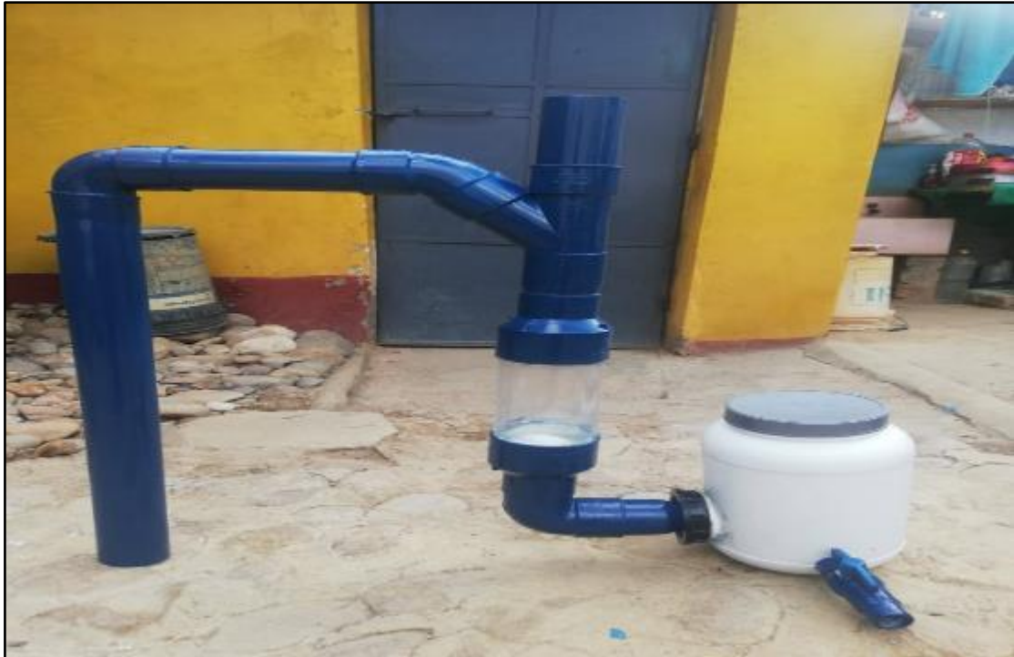
Fotografía N.º 12: Armado del Sistema Interceptor de Primeras Aguas con capacidad de 3.6 litros para edificación rustica con área de techo de 1.8m de ancho por 2 m de largo, Huancayo 2018.
