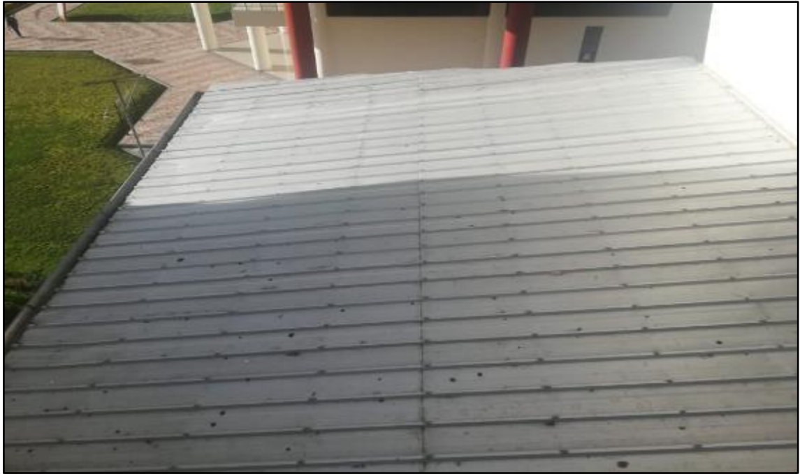
Fotografía N.º 17: Techo de la Oficina de Decanatura de la Facultad de Ingeniería de la Universidad Peruana Los Andes, 2019.
