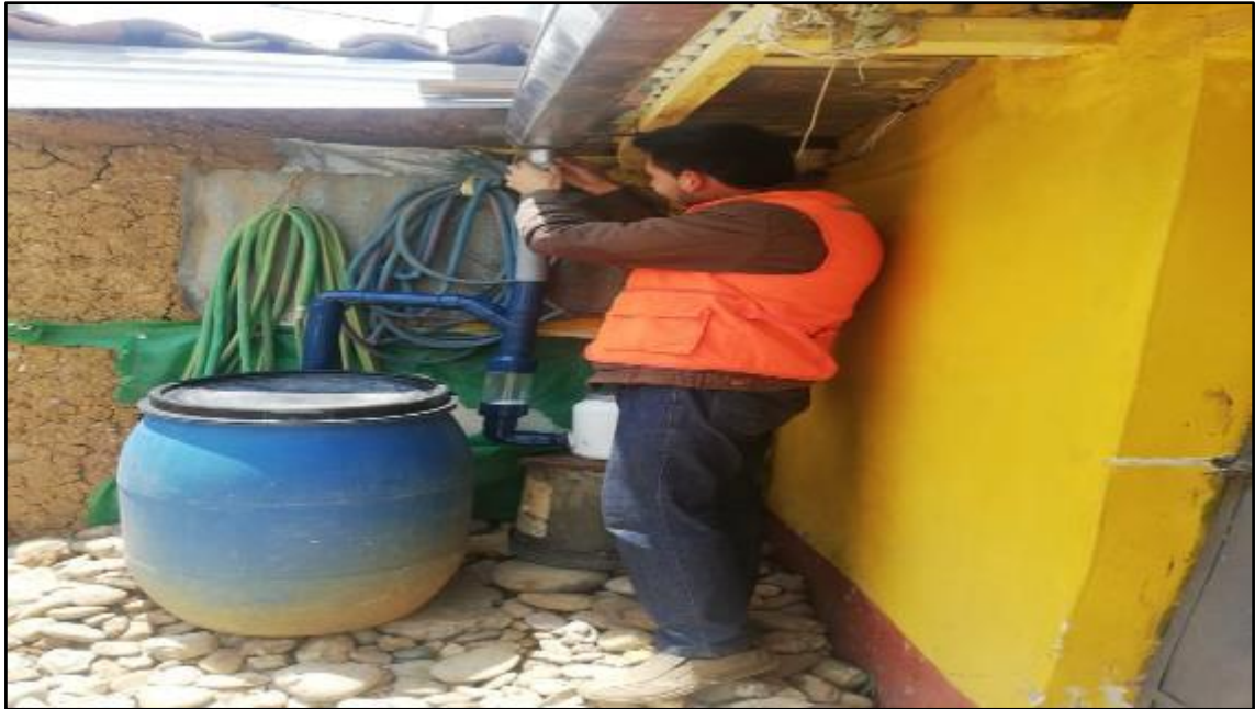
Fotografía N.º 15: Instalación del Sistema Interceptor de Primeras Aguas y Tanque de Almacenamiento de 50 litros para uso de riego de jardines en la vivienda.
