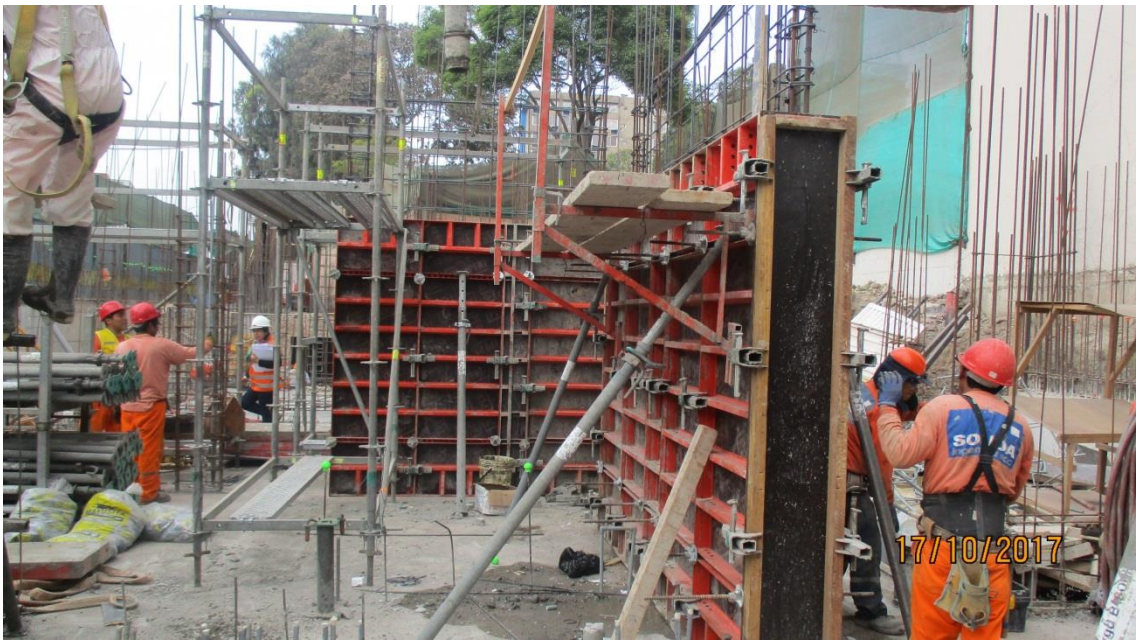
Fotografía 14 – Vaciado de Concreto en Placas
