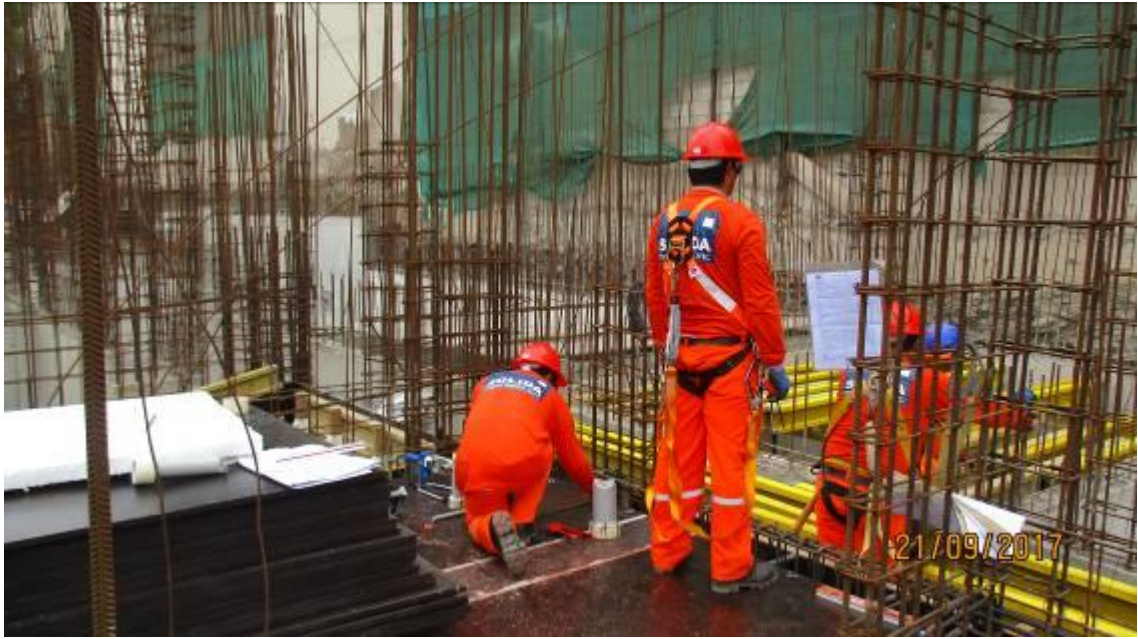
Fotografía 7 – Encofrado de Fondo de losa
