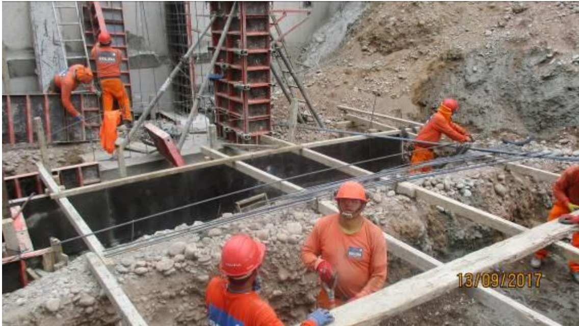
Fotografía 3 – Encofrado de Sobrecimiento
