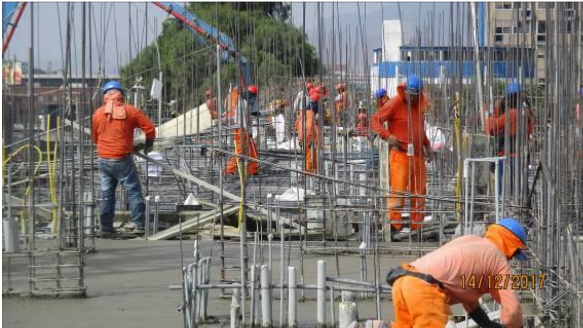
Fotografía 19 – Nivelado del Vaciado de Concreto en Losas y Vigas
