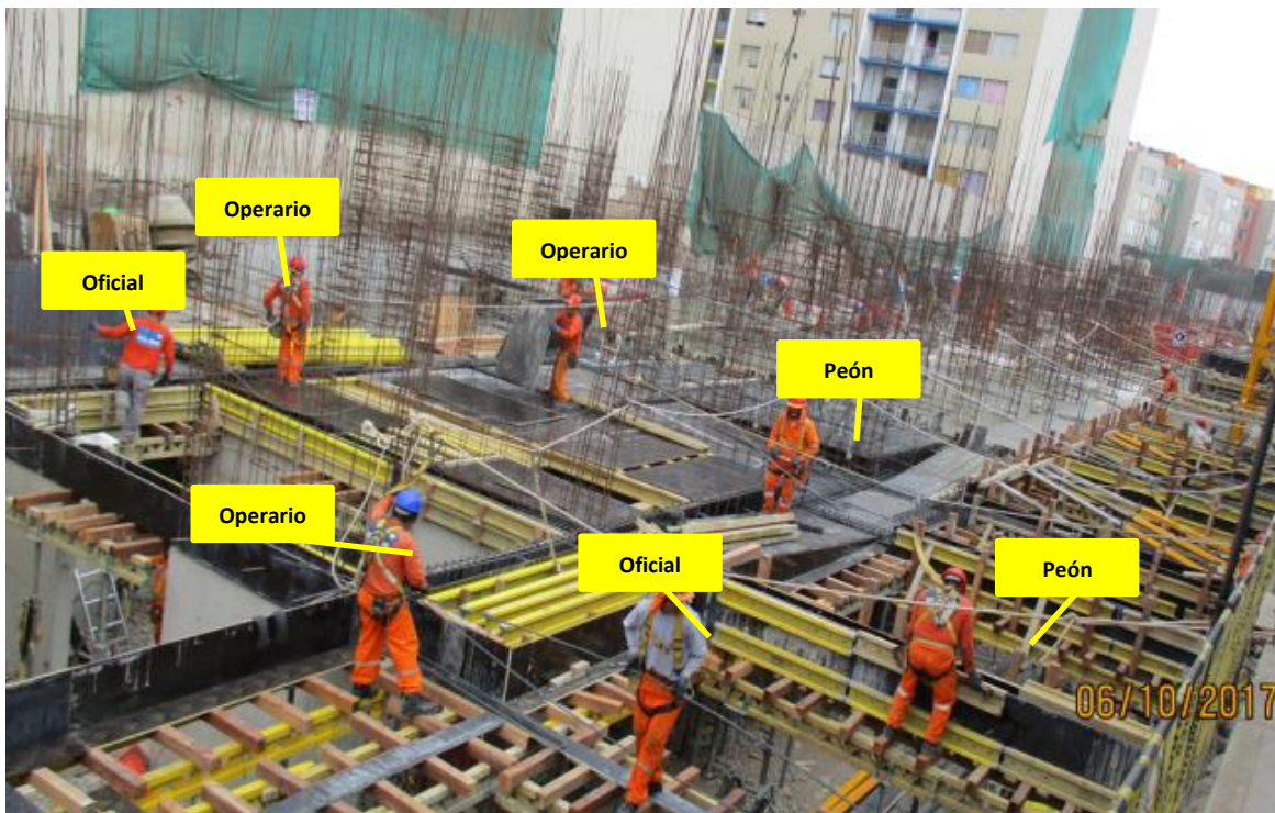
Imagen 49 - Encofrado y Apuntalamiento de Vigas y Losas
