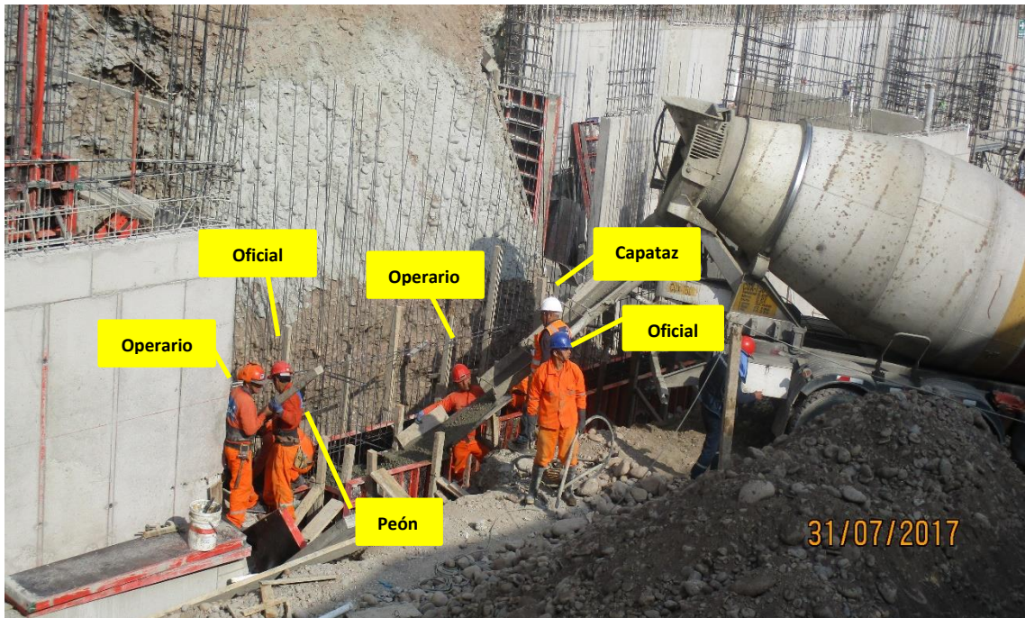
Imagen 13 – Vaciado de Concreto en Zapata
