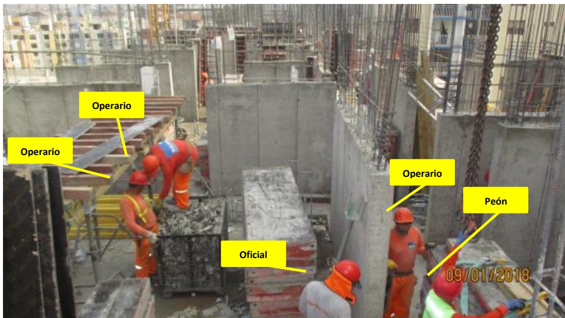
Imagen 126 - Encofrado y Apuntalamiento de Vigas y Losas
