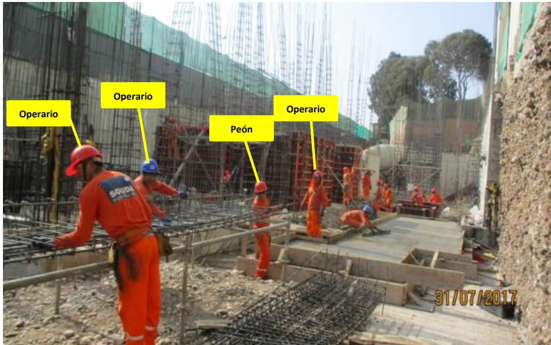
Imagen 24 – Habilitado y colocado de Acero en Placas y Columnas
