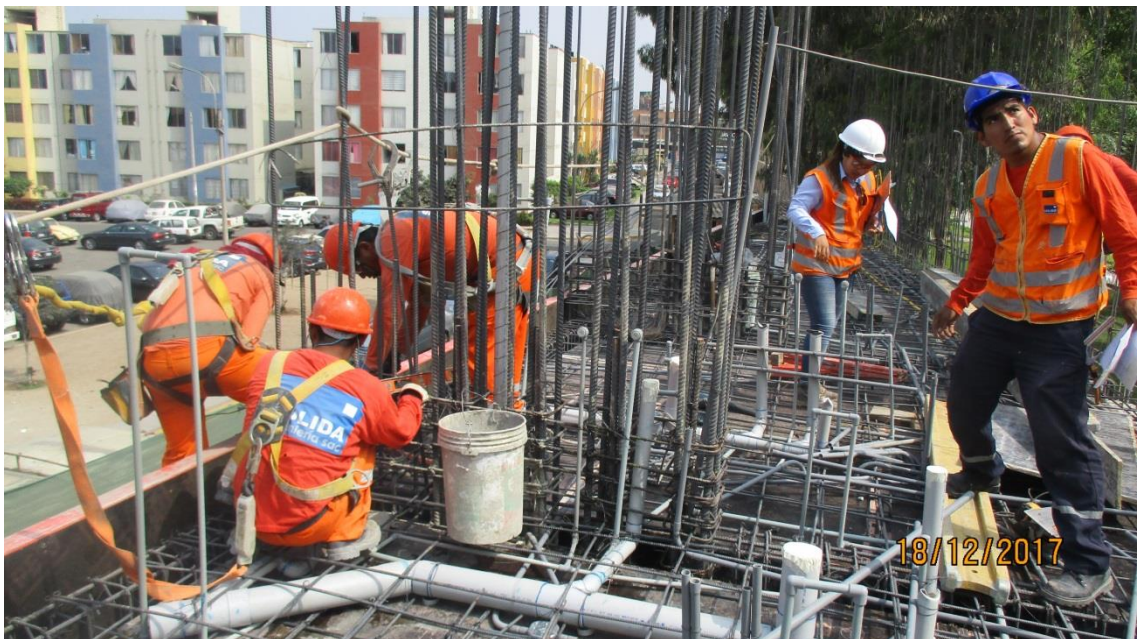
Fotografía 18 – Encofrado de Friso
