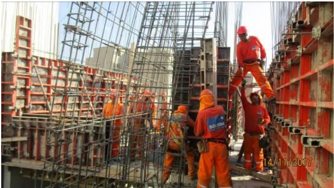
Fotografía 16 – Encofrado de Placas
