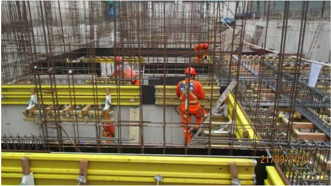
Fotografía 5 – Encofrado de Frisos
