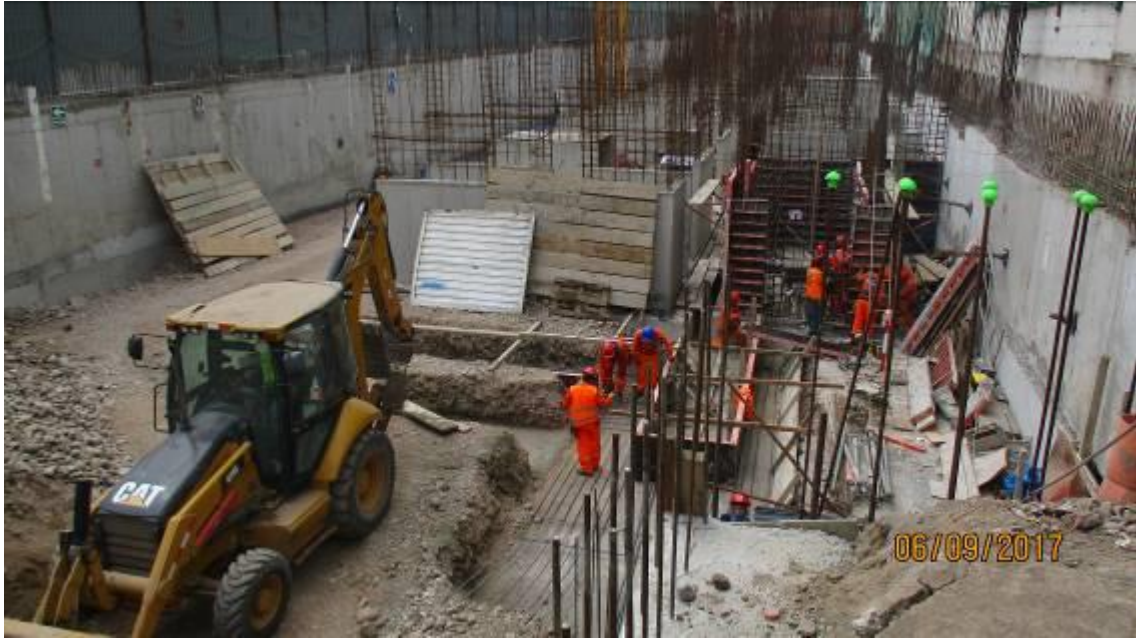
Fotografía 1 – Trabajos de Acero en Cimentación
