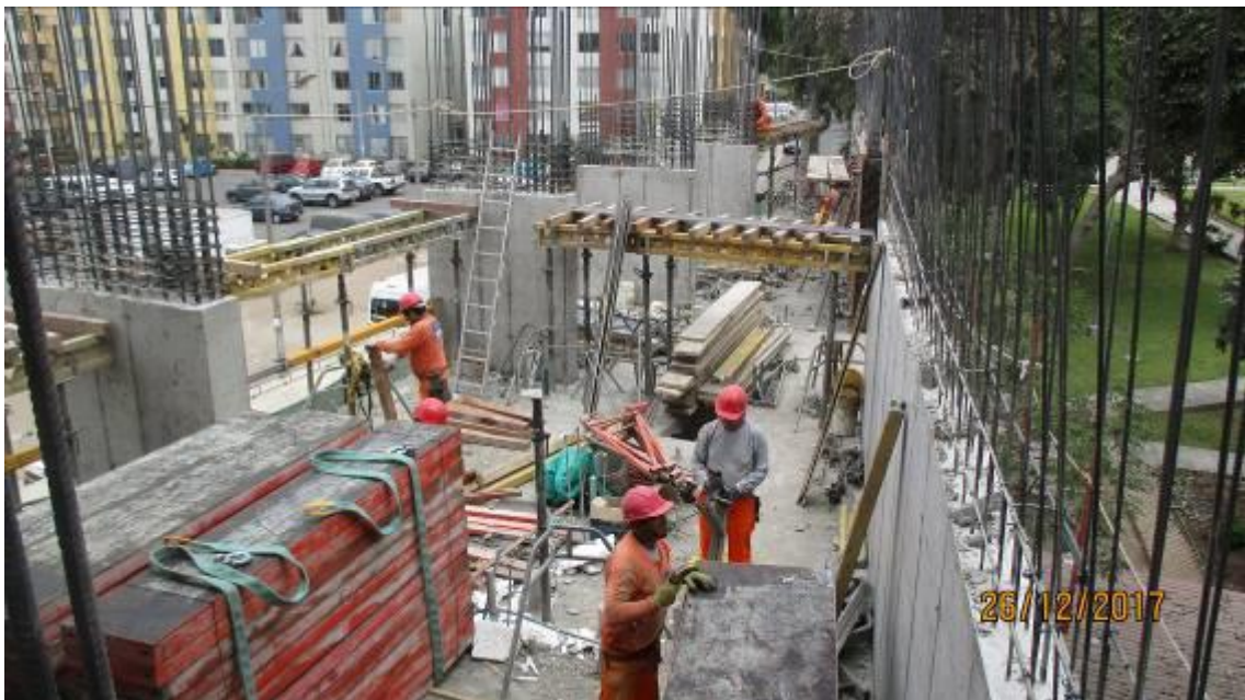
Fotografía 22 – Apuntalamiento y Encofrado de Fondo de Viga
