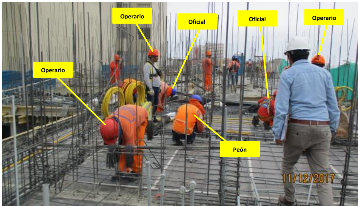
Imagen 136 - Habilitado y colocado de Acero en Vigas y Losas
