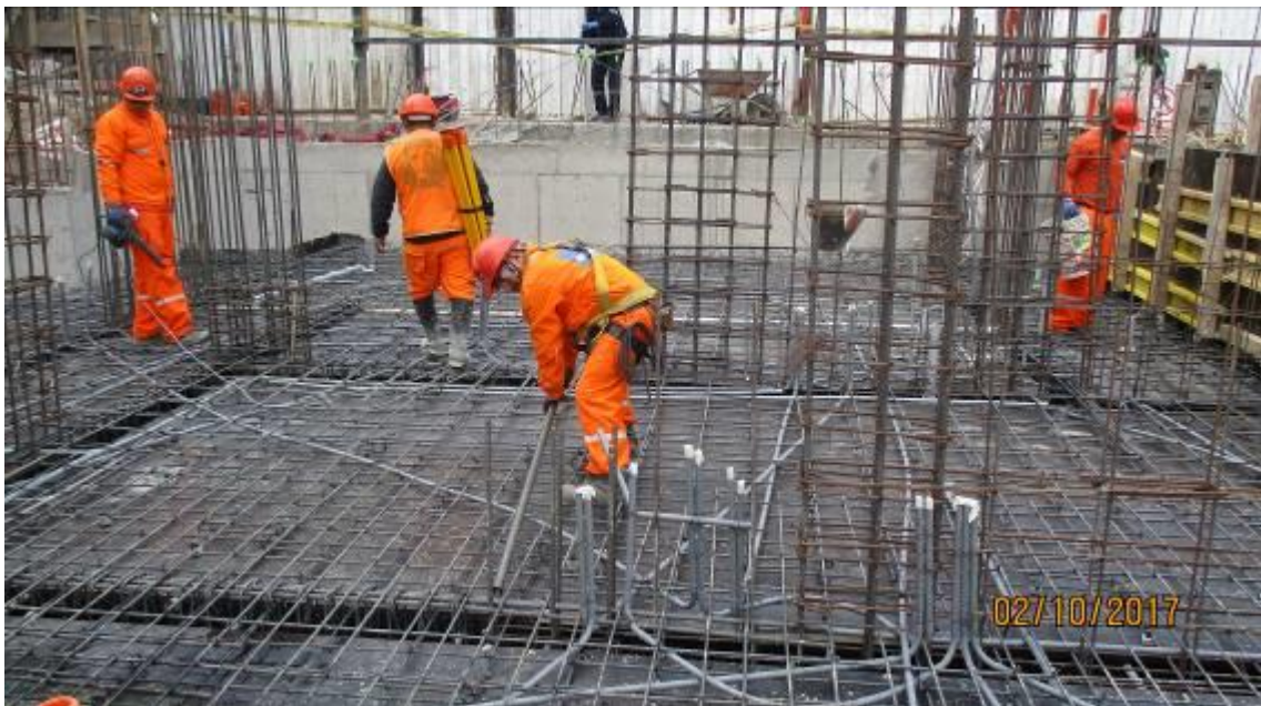
Fotografía 10 – Colocación de Acero en Losa
