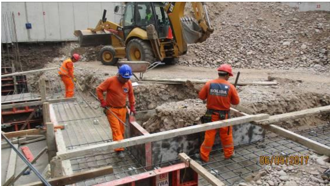
Fotografía 2 – Trabajos de Acero en Zapatas
