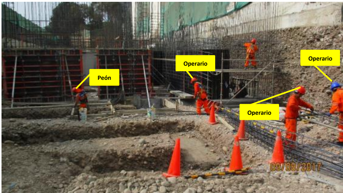
Imagen 4 – Habilitado y Colocado de Acero en Zapata
