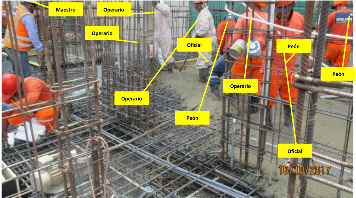
Imagen 74 - Vaciado de Concreto en Vigas Y Losas
