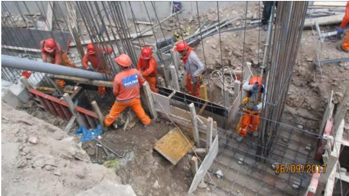
Fotografía 9 – Vaciado de Cimientos y Zapatas
