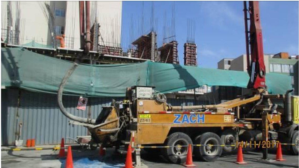
Fotografía 17 – Bomba estacionaria Para trabajos de vaciado de Concreto
