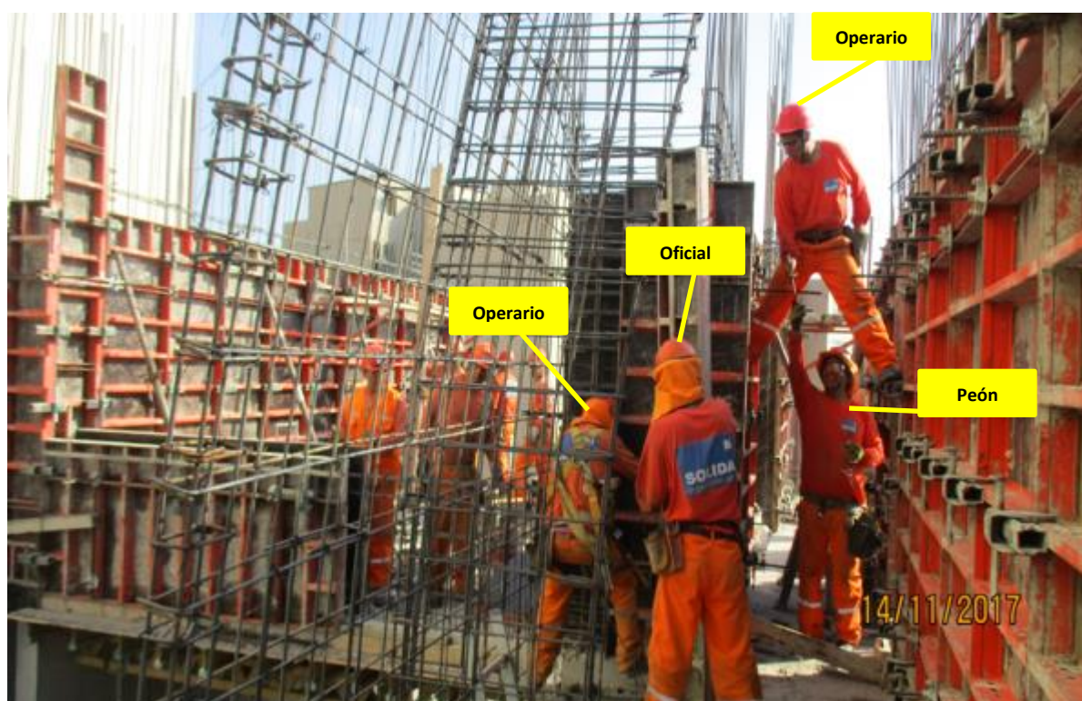
Imagen 109 – Encofrado de Placas y Columnas
