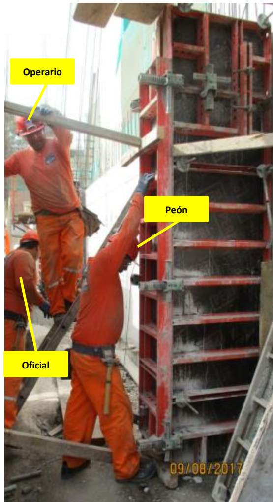
Imagen 33 – Encofrado de Placas y Columnas
