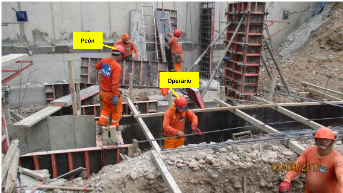
Imagen 86 – Habilitado y Colocado de Acero en Zapata - Reevaluación
