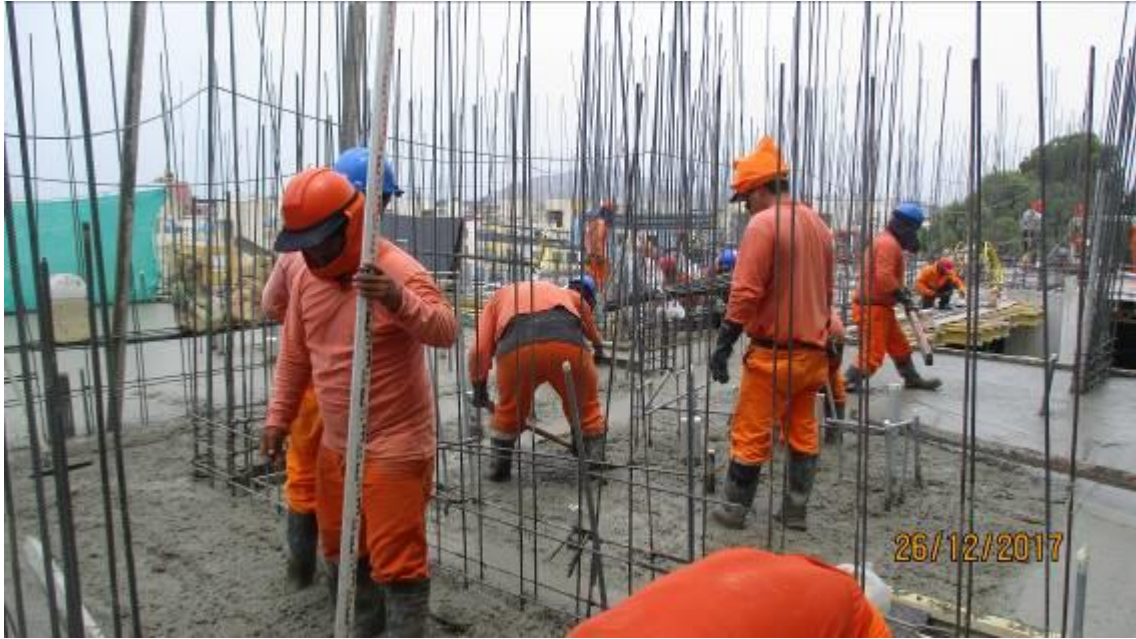
Fotografía 21 – Trabajos de Nivelado en Vaciado de Concreto en Losas y Vigas
