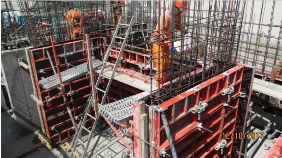
Fotografía 13 – Preparación para Vaciado de Concreto en Placas
