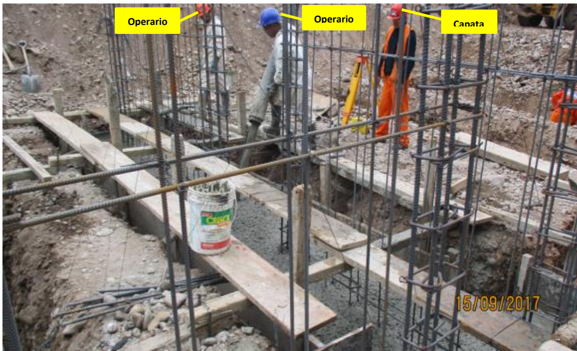
Imagen 93 – Vaciado de Concreto en Zapata
