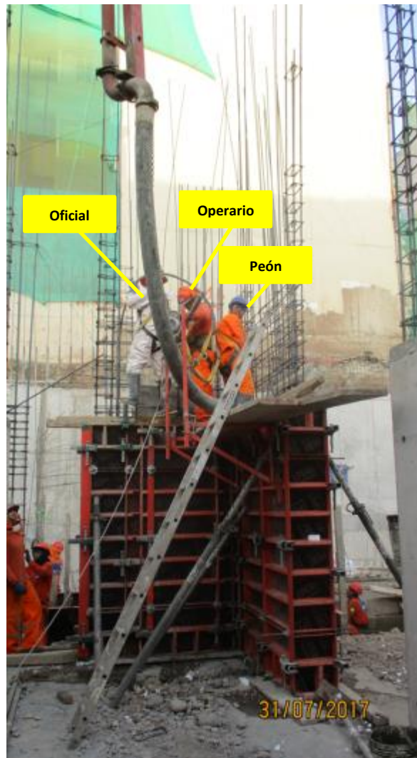
Imagen 41 – Vaciado de Concreto en Placas y Columnas
