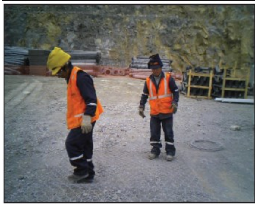
Fotografía 1.- eliminar las irregularidades de la cola de refuerzo
