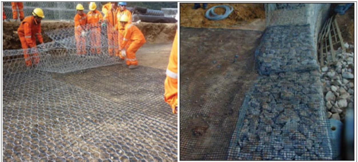
Fotografía 8.- Colocación de la Geomalla
