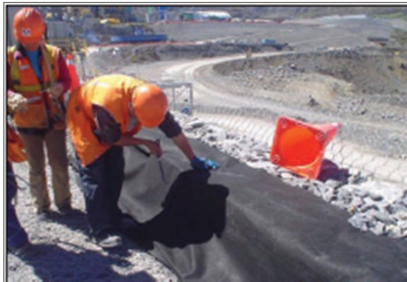
Fotografía 6.- Colocación del geotextil
