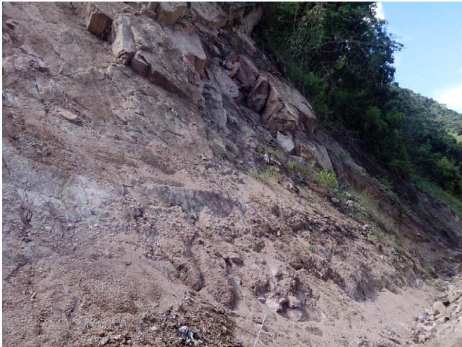
Fotografía 06 – Presencia de Rocas Inestables Aguas Arriba de la Relavera.
