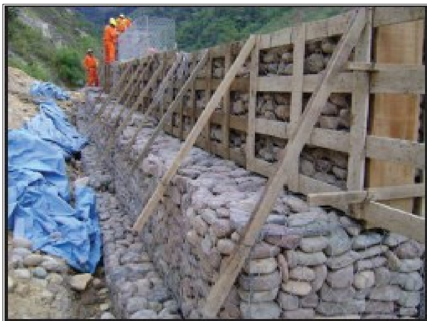
Fotografía 4.- Uso de encofrado de madera
