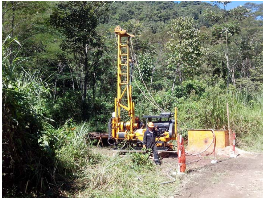
Fotografía 44 – Vista del proceso de perforación del punto P-03.
