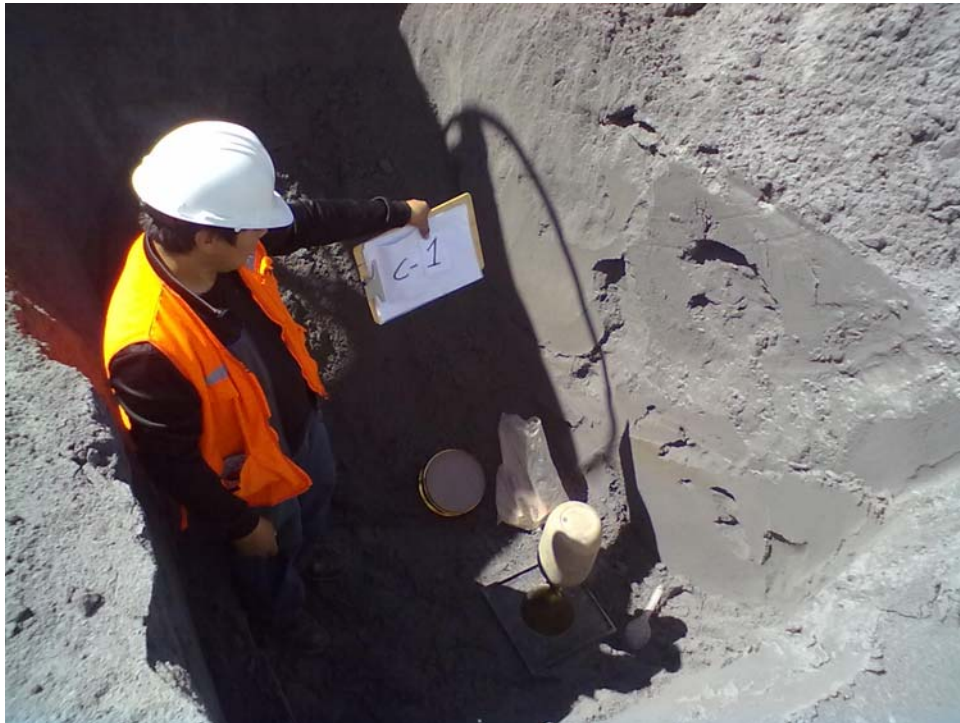
Fotografía 08 – Vista de ensayo de densidad in situ en la calicata C-01.
