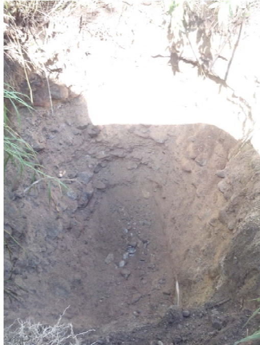
Fotografía 21 – Vista Panorámica de la Calicata C-07.
