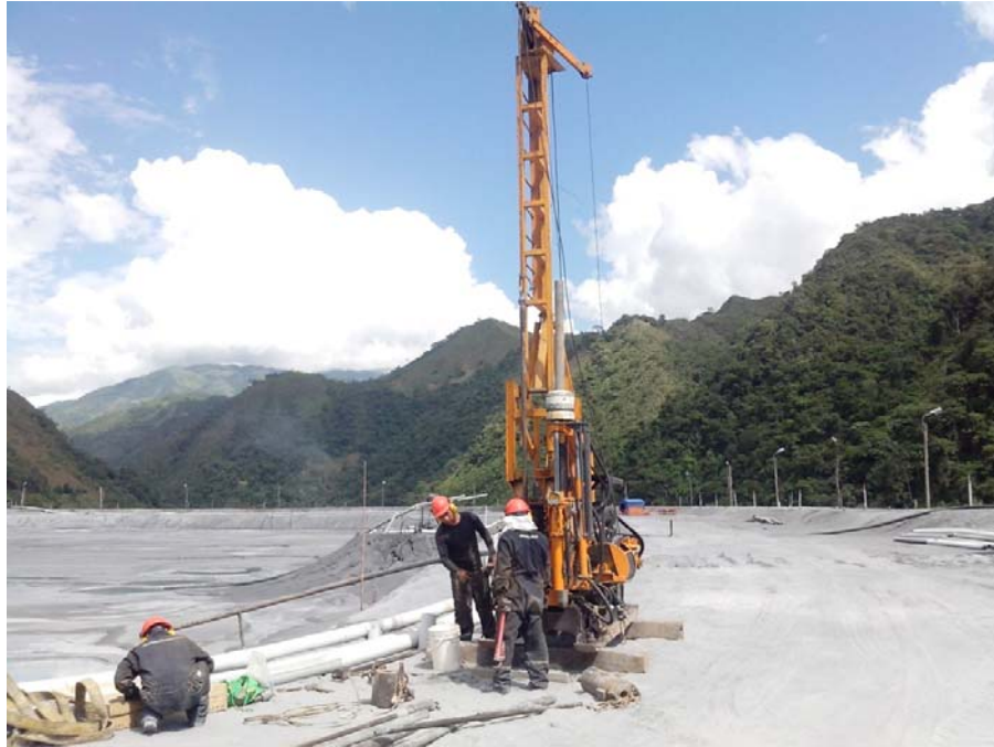
Fotografía 52 – Vista durante la Ejecución del Ensayo SPT-01.
