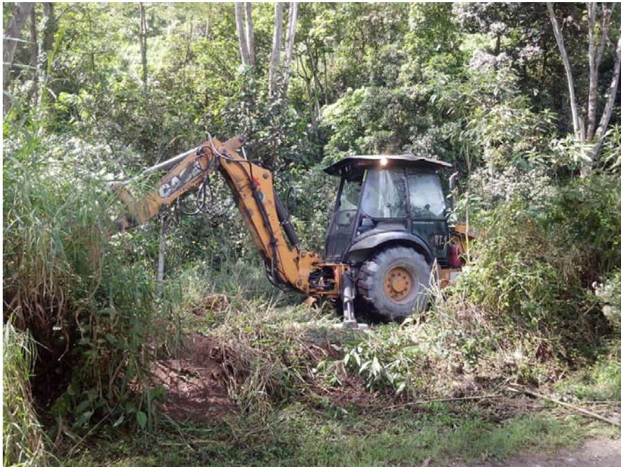
Fotografía 23 – Vista Durante la Ejecución de la Calicata C-08.
