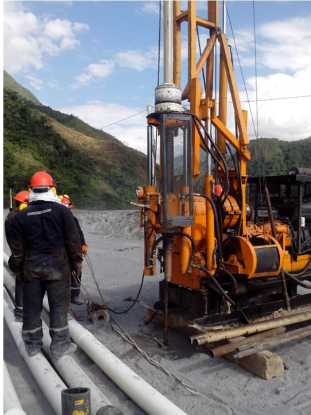
Fotografía 54 – Vista durante la Ejecución del Ensayo SPT-03.
