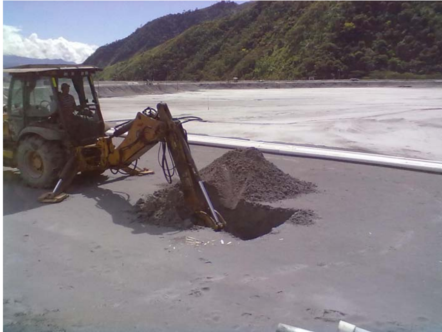
Fotografía 09 – Vista Panorámica Durante la Ejecución de la Calicata C-02.
