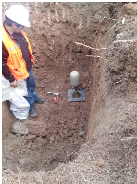
Fotografía 18 – Vista de ensayo de densidad in situ en la calicata C-05.
