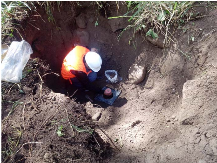
Fotografía 25 – Vista de ensayo de densidad in situ en la calicata C-08.
