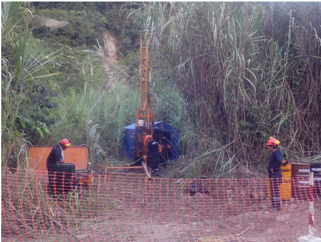
Fotografía 37 – Vista del proceso de perforación del punto P-02.
