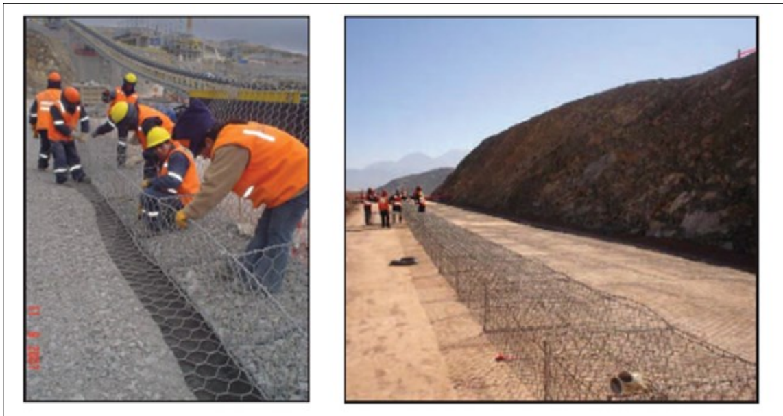
Fotografía 3.- Elementos terramesh contiguos
