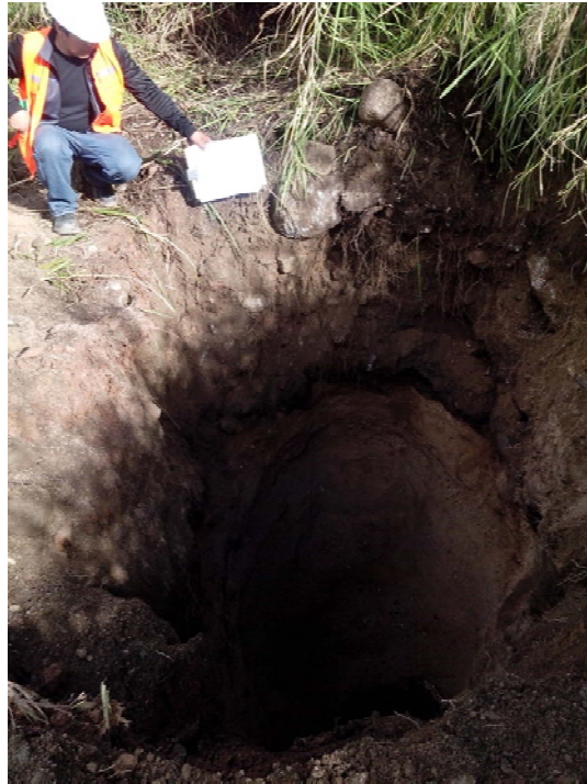
Fotografía 19 – Vista Panorámica de la Calicata C-06.
