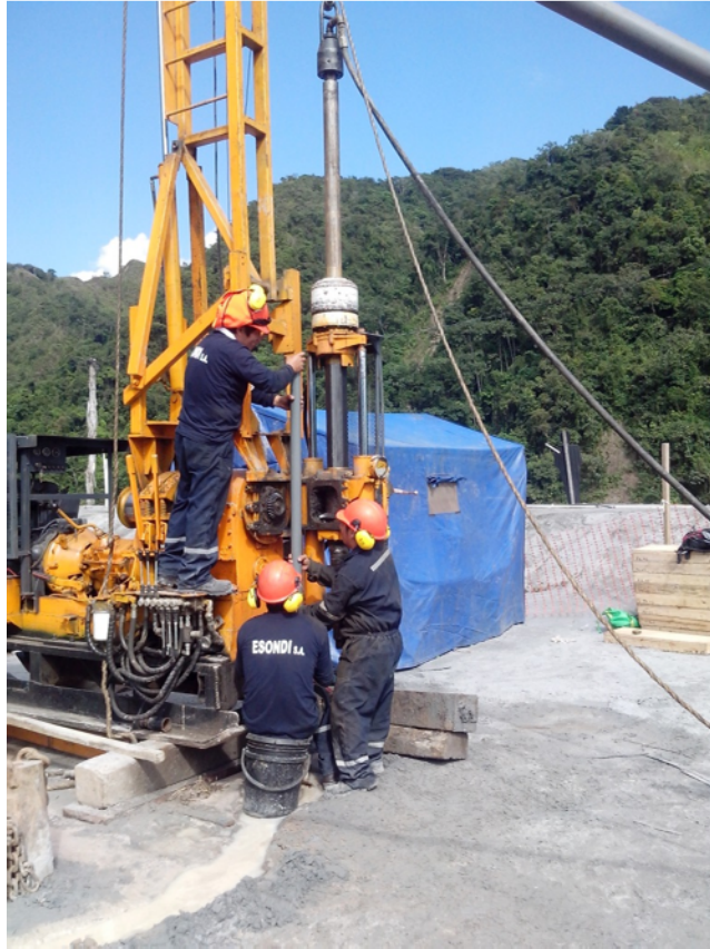
Fotografía 50 – Vista de la Instalación del Piezómetro en la Perforación P-01.
