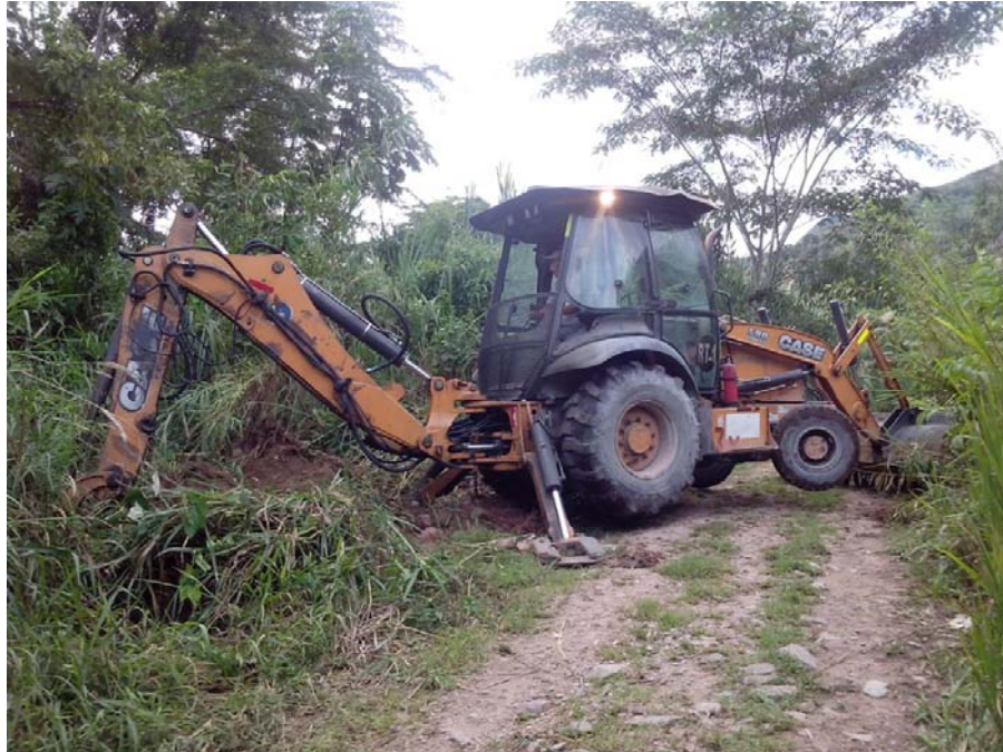
Fotografía 15 – Vista Panorámica Durante la Ejecución de la Calicata C-04.
