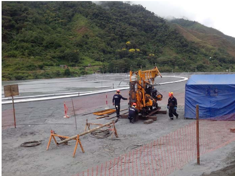
Fotografía 27 – Vista del Proceso de Instalación de Perforadora en Punto P-01.
