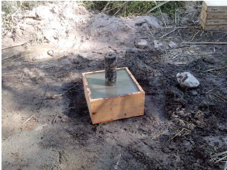
Fotografía 51 – Vista del Piezómetro Instalado en la Perforación P-02.
