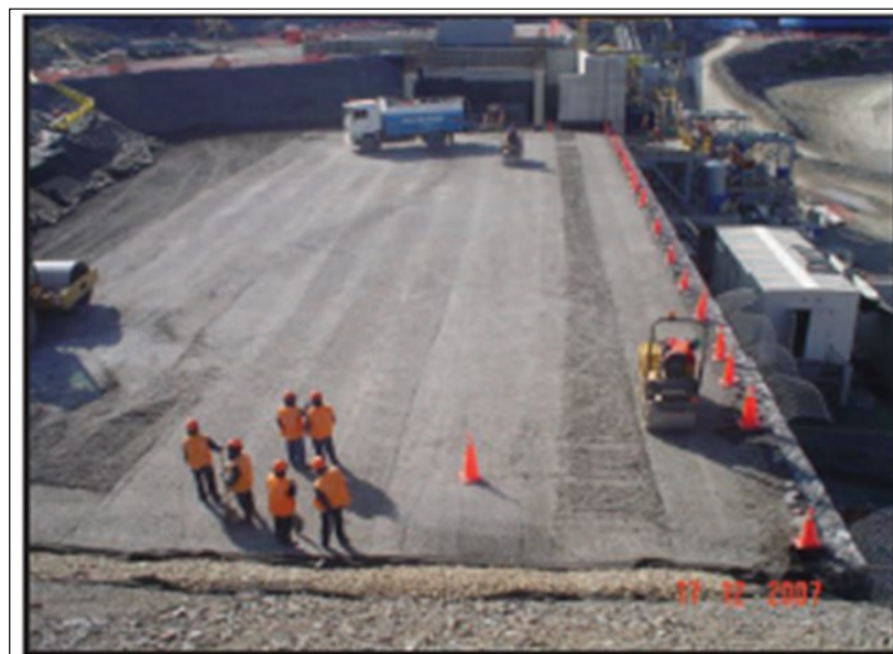
Fotografía 7.- Compactacion del relleno
