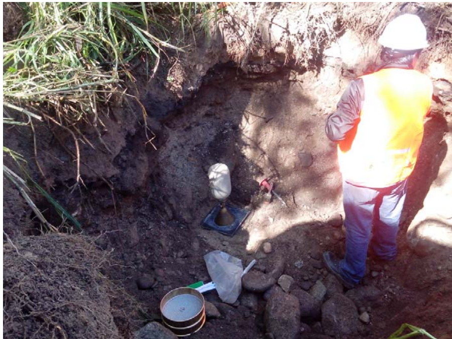
Fotografía 22 – Vista de ensayo de densidad in situ en la calicata C-07.
