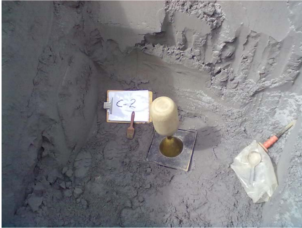
Fotografía 11 – Vista de ensayo de densidad in situ en la calicata C-02.
