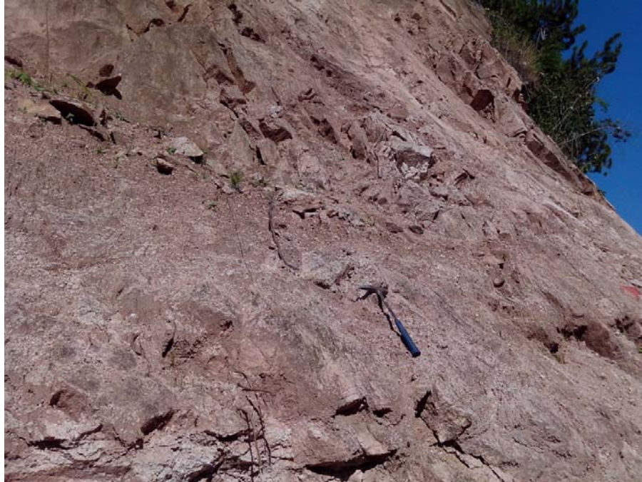
Fotografía 56 – Vista de la Estación Geomecánica EG-02.
