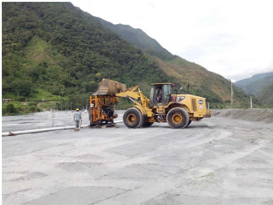
Fotografía 53 – Vista de la Instalación de la Máquina en el Punto SPT-02.
