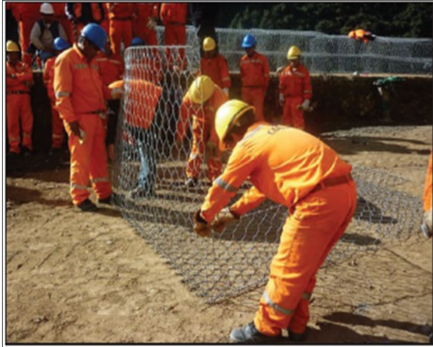
Fotografía 2.- Pre-Armado De La Unidad Terramesh
