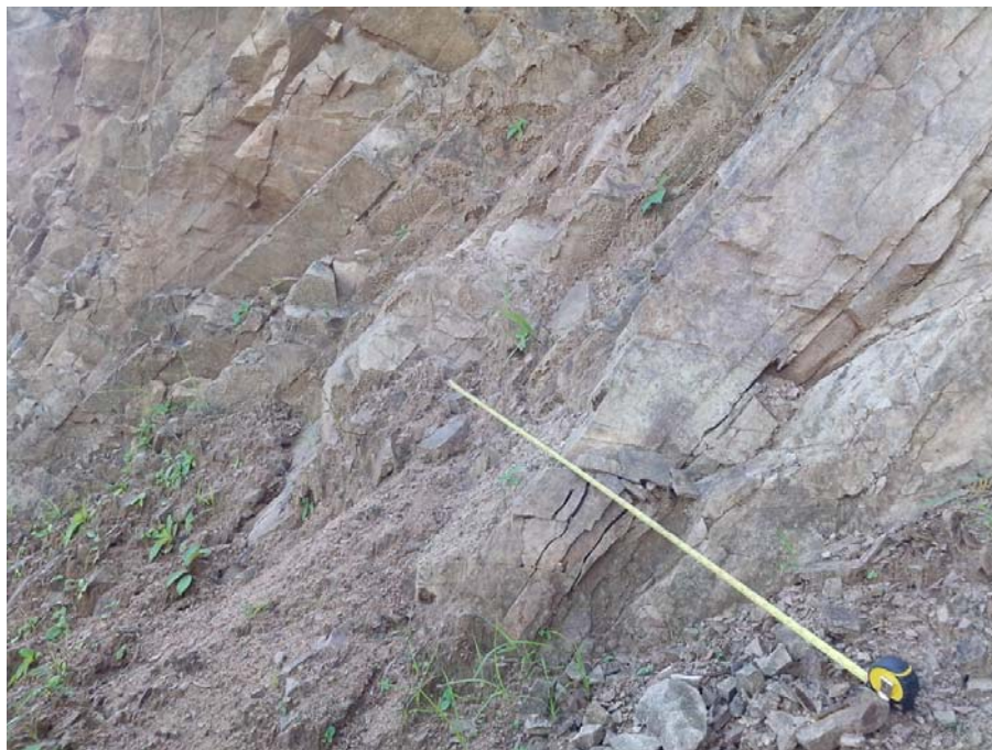
Fotografía 55 – Vista de la Estación Geomecánica EG-01.
