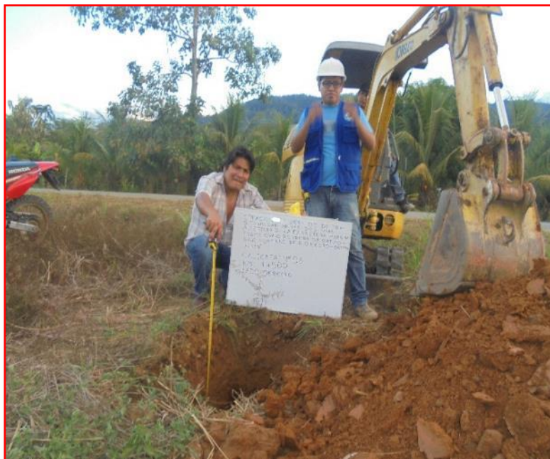
Figura 6: registro de excavación
