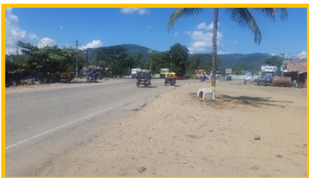
Figura 50: Vista de Capilla, Progresiva 0+03
