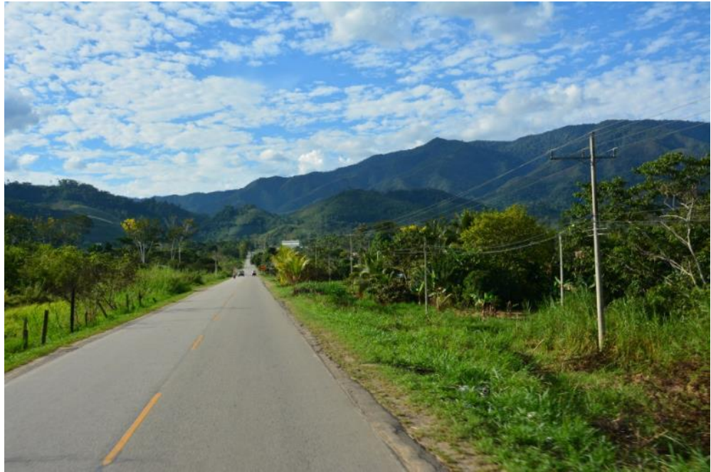
Vía Principal Tramo 6+000km
