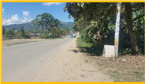
Figura 52: Vista de Capilla, Progresiva 0+640
