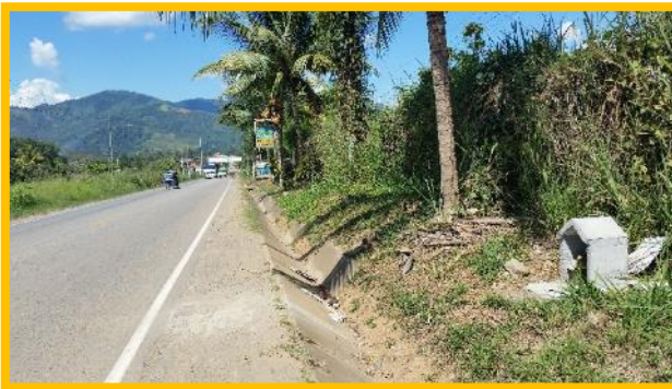
Figura 53: Vista de Capilla, Progresiva 1+360
