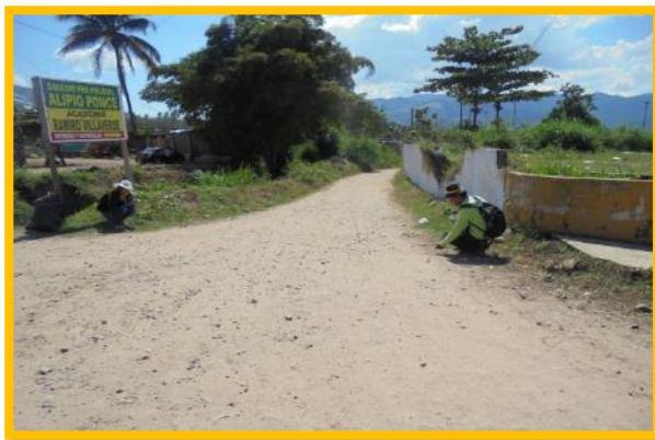
Figura 59: Ingreso a Urbanización San Crisanto
