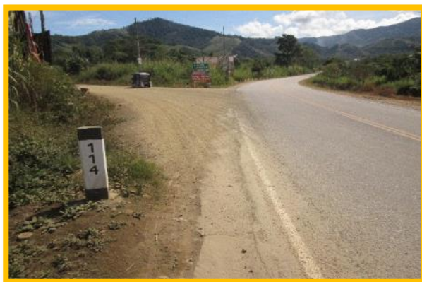
Figura 57:: Ingreso a C.P la Union, ubicado en plena curva.
