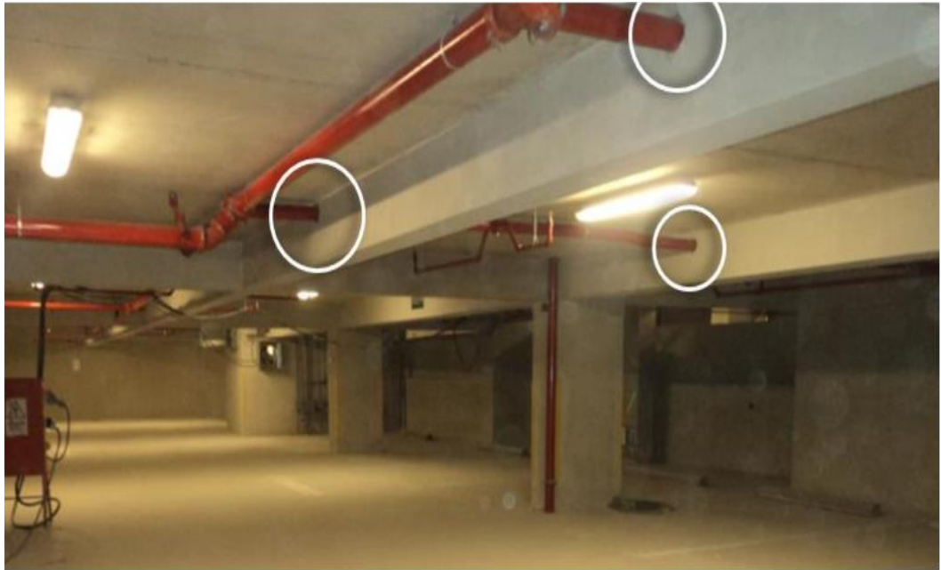
Figura 34 : Pases en vigas mediante perforaciones diamantinas
