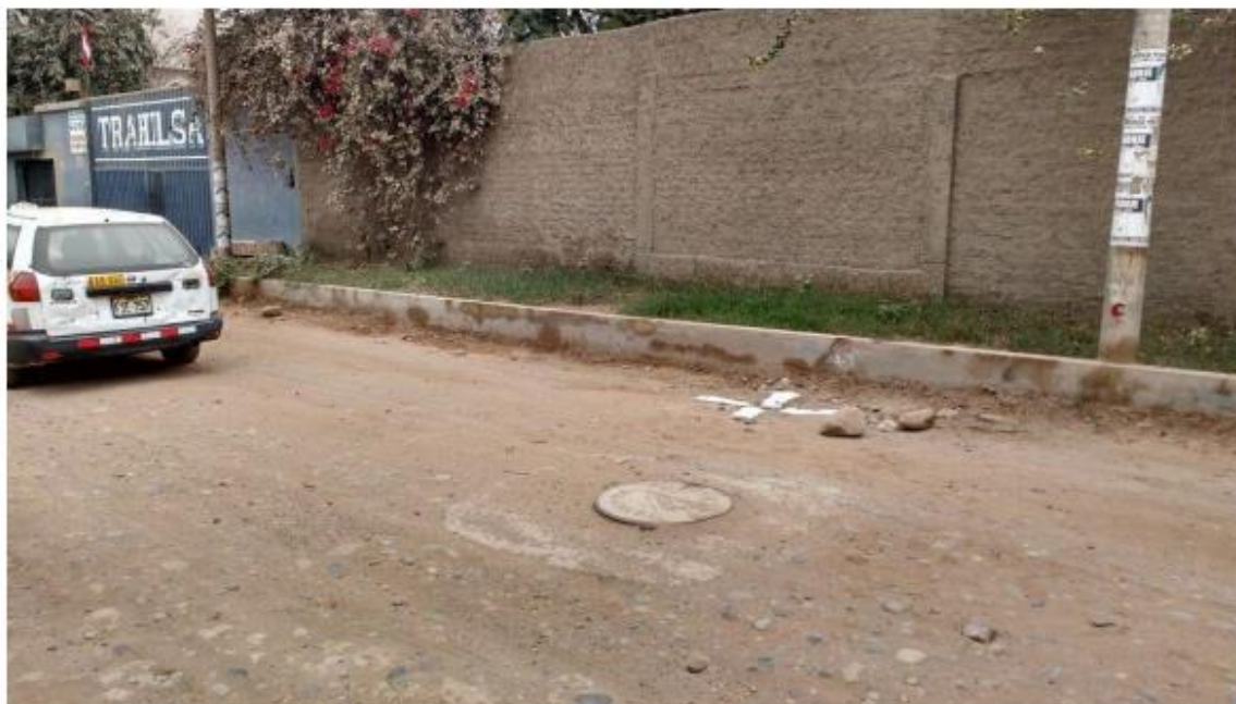
Foto N° 06.- Monumentación de los Puntos de Control
