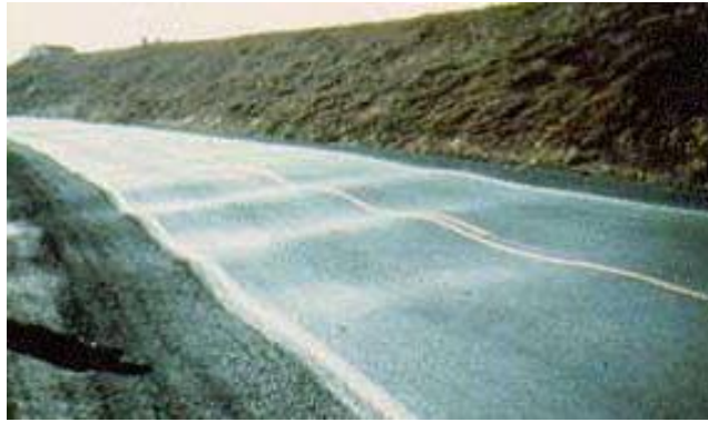
Figura 14. Imagen de Hinchamiento de un Pavimento Tomado de "diseño de carreteras" curso virtual (2015) [digital]. Recuperado de http://.eduvirtual/gnss/.org/?/pág./592 .
