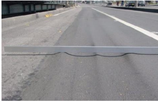
Figura 17. Imagen de depresión Tomada de "diseño de carreteras "curso virtual (2015) [digital]. Recuperado de http://.eduvirtual/viales/.org/? /pág./98 .
