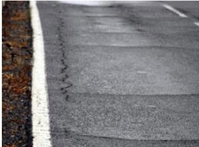
Figura 12. Corrugación Tomado de "diseño de carreteras" curso virtual (2015) [digital]. Recuperado de http://eduvirtual/viales.org/?/pág./111 .
