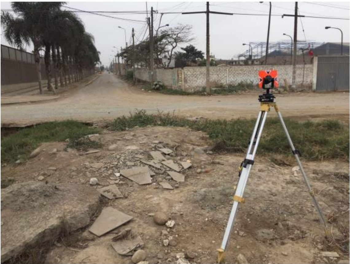
Foto N° 03 y 04.- Proceso de Levantamiento y cierre de Poligonal
