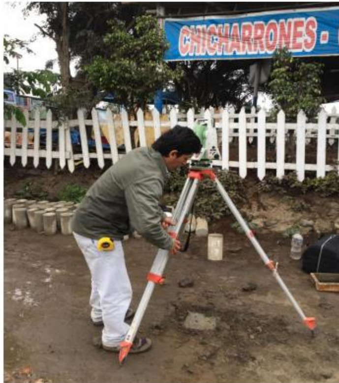
Foto N° 10.- Posicionamiento para la toma de datos con Estación Total
