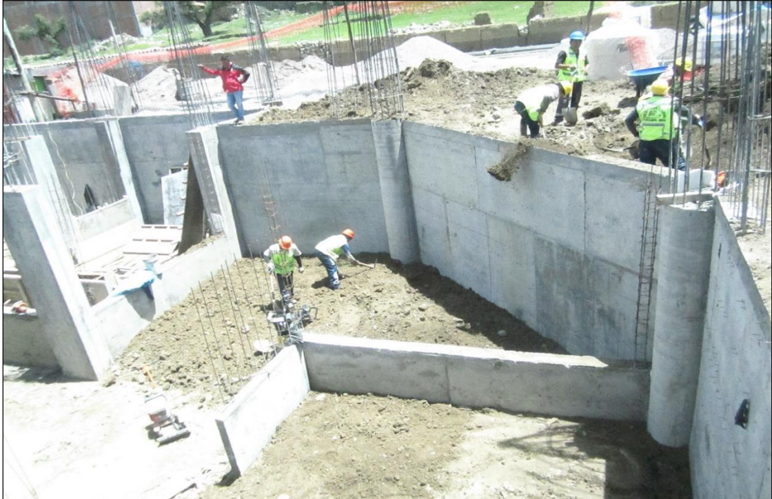
Fotografía A2-7. Se muestra el muro de contención del semisótano e=0.20\text{m} . Bloque – III.
