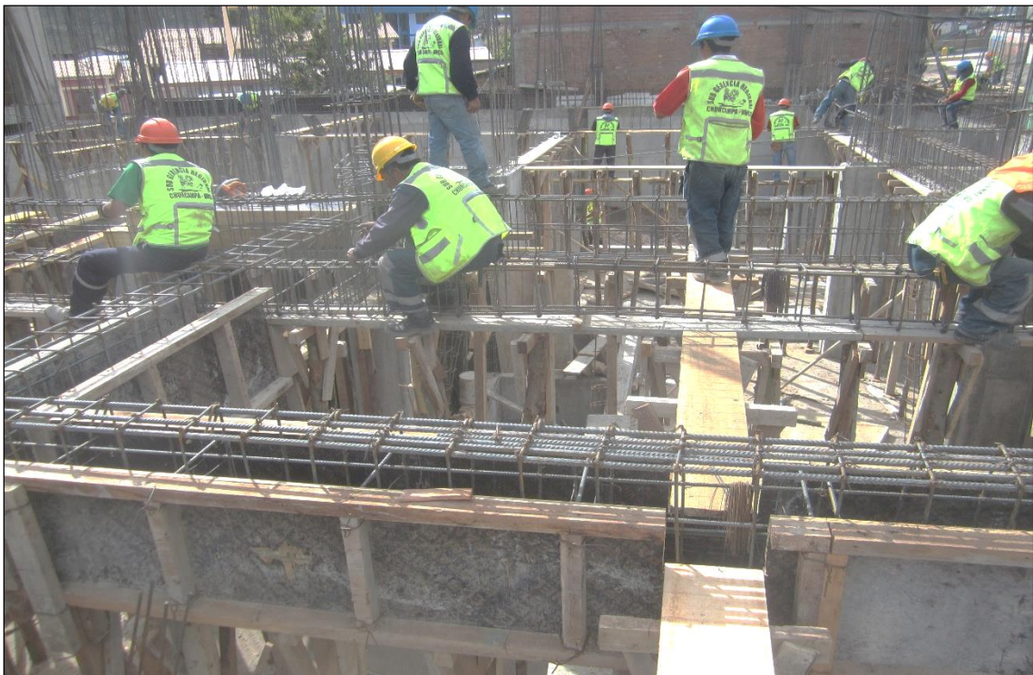
Fotografía A2-8. Se muestra los trabajos realizados de acero en vigas principales y secundarias del Semisótano. Bloque – III.
