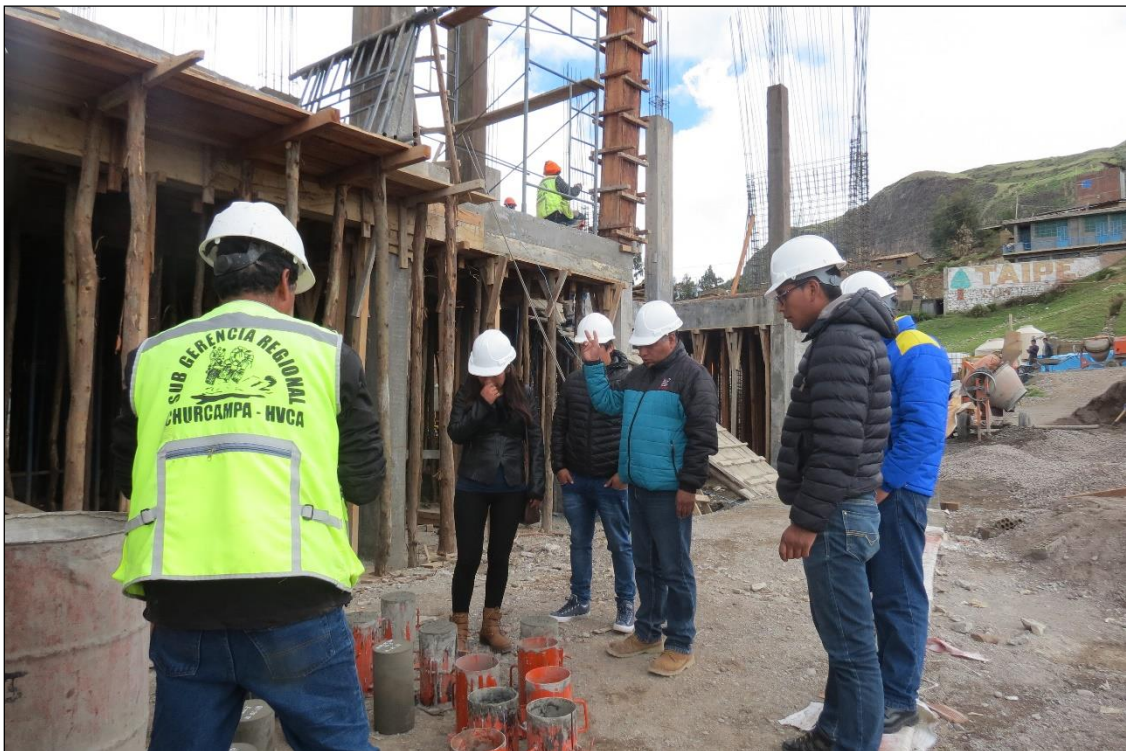
Fotografía A2-6. Verificación de los trabajos realizados respecto al control de calidad del concreto por parte de funcionarios de la Gerencia Sub Regional de Churcampa y Consejería Regional de Huancavelica.
