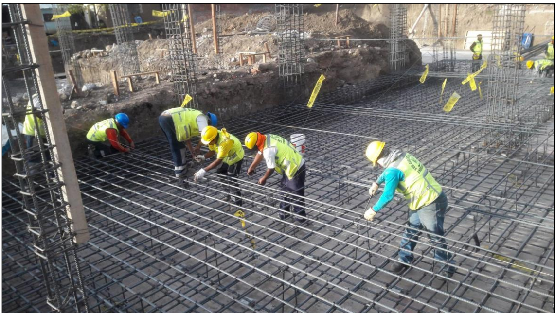
Fotografía A2-2. Se muestra la disposición de acero de refuerzo para la losa de cimentación H=0.60\text{m} , del bloque – II.
