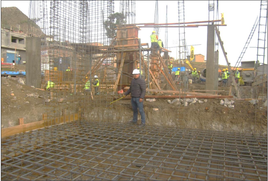
Fotografía A2-3. Verificación de los trabajos de disposición de acero de refuerzo tanto en la losa de cimentación de H=0.60\text{m} , como en las columnas C-1 y Placas PL-1. B – I.
