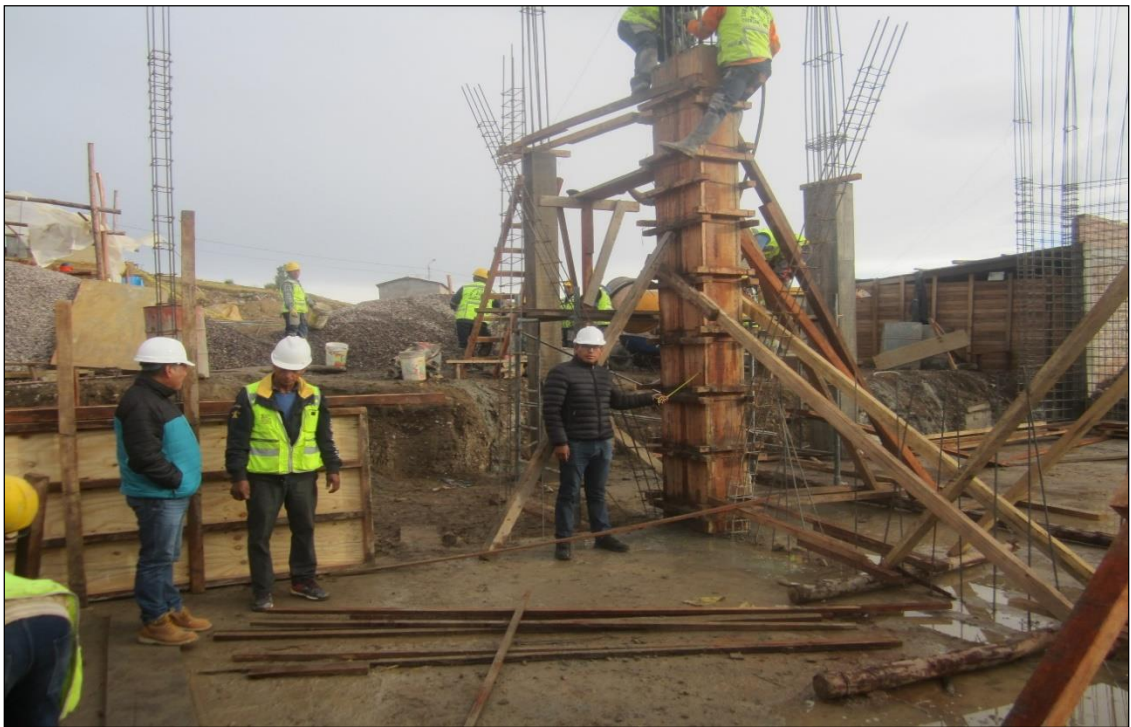
Fotografía A2-4. Verificación de los trabajos de encofrado de las columnas Tipo C-3. Bloque – II.
