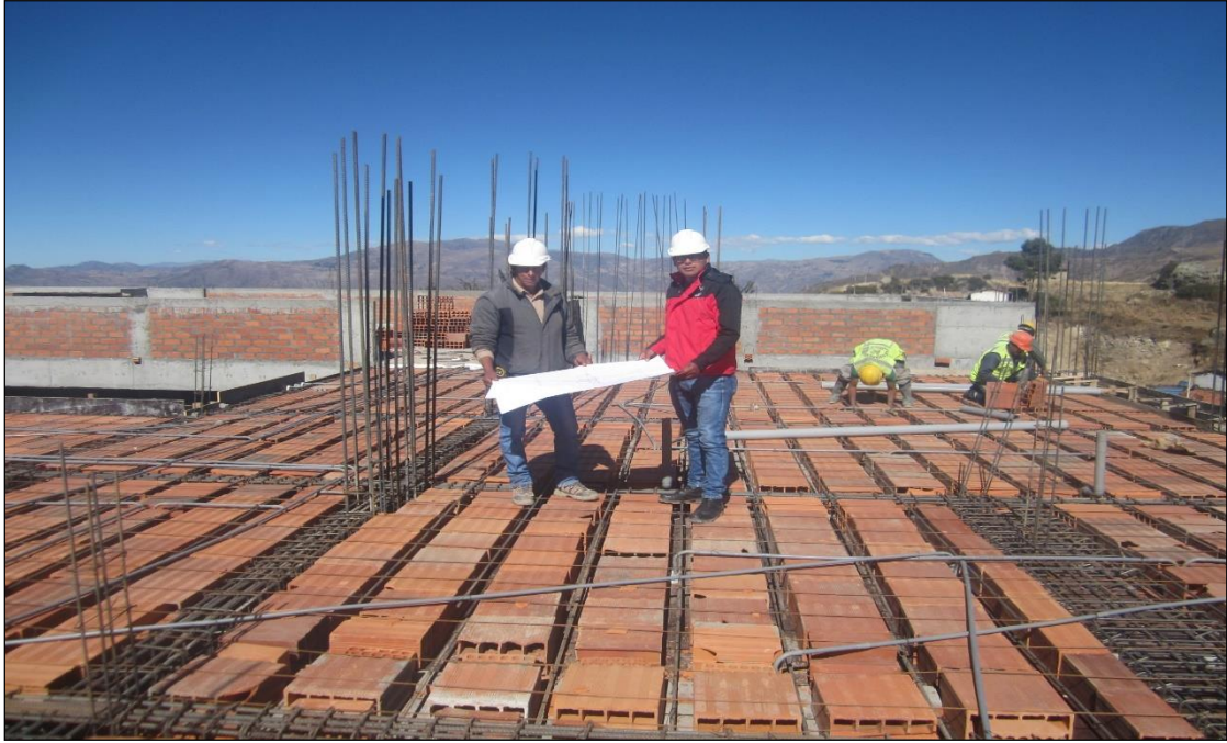
Fotografía A2-11. Trabajos de supervisión en la disposición de acero de refuerzo para vigas principales, secundarias y losa aligera h=0.20\text{m} del cuarto piso. Bloque – III.
