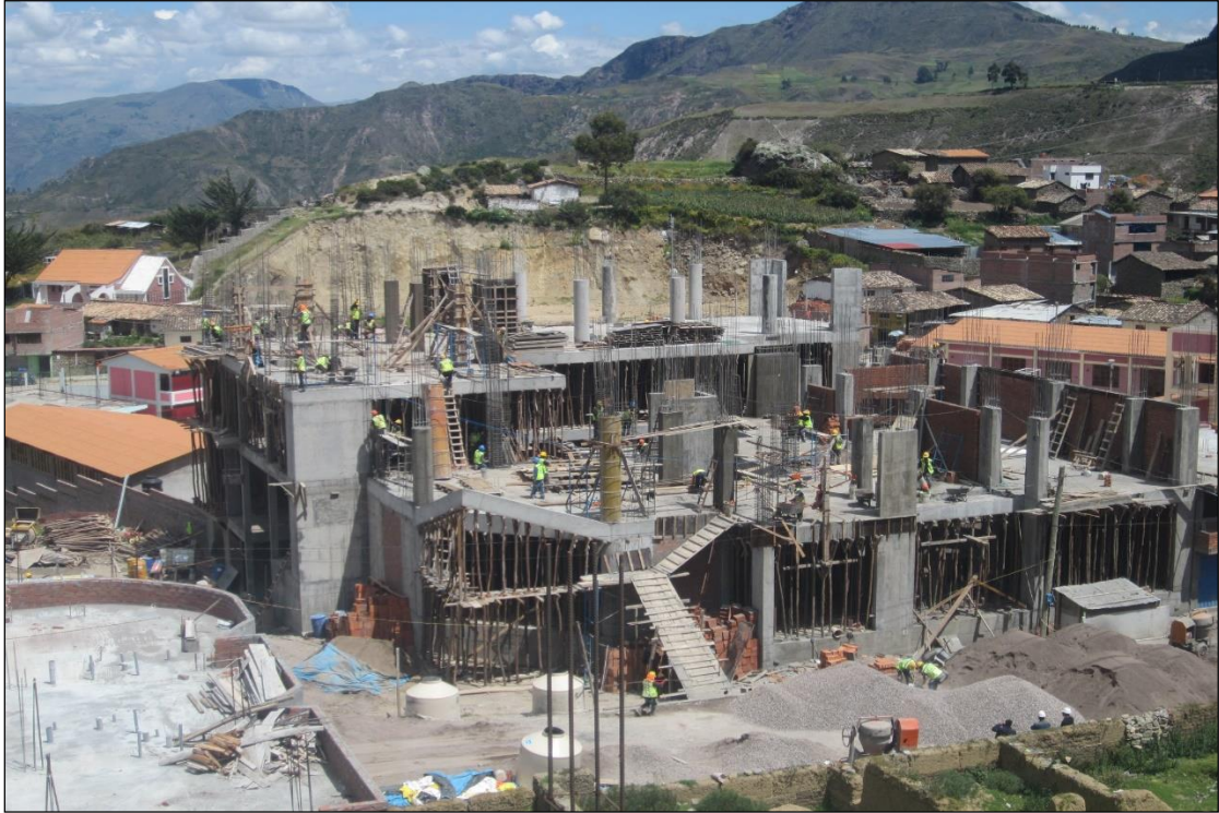
Fotografía A2-9. Vista panorámica de los Bloque – I, II y III en construcción.
