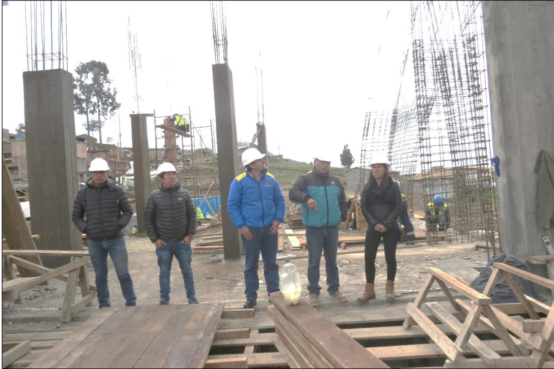
Fotografía A2-5. Verificación de los trabajos realizados por parte de funcionarios de la Gerencia Sub Regional de Churcampa y Consejería Regional de Huancavelica.
