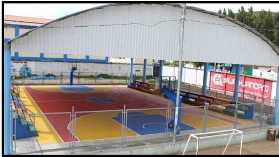
Foto N°28: Losa deportiva de básquet pintada según el reglamento de básquet.
