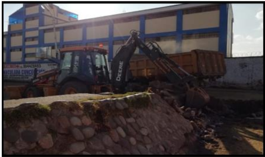
Foto N°12: Demolición de las tribunas existentes.
