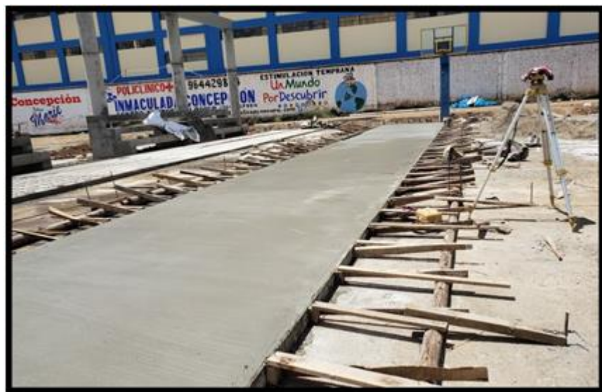
Foto N° 22: Nivelación del concreto f'c 175 kg/cm 2 .
