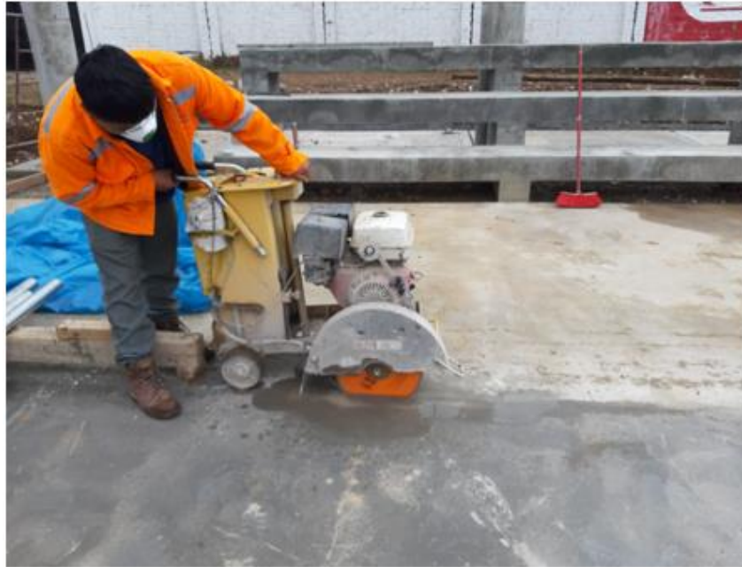
Foto N°25: Aserramiento del concreto con cortadora de disco de diamantina.
