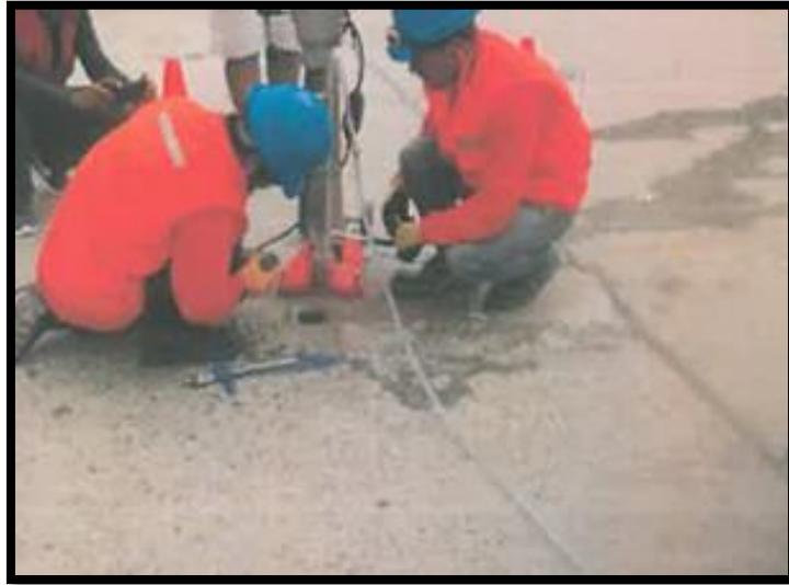
Foto 1 . Testigos Diamantinos de la losa antigua (diámetro de 3.70 pulg)
