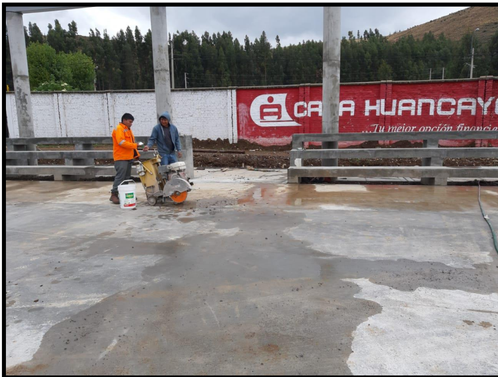
Foto N°26: Aserramiento del concreto con cortadora de disco de diamantina.
