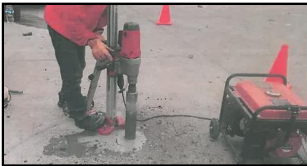
Foto N°5: Extracción del Testigo Diamantino, Diamantina N° 1
