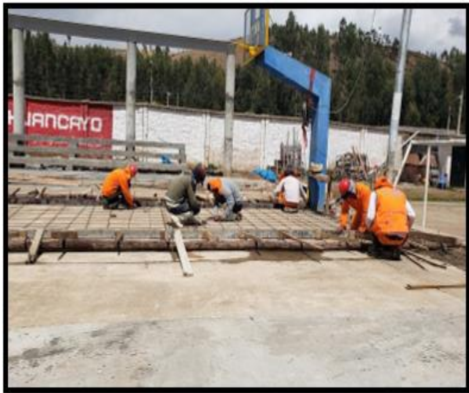
Foto N°17: Encofrado para el vaciado del concreto de la losa deportiva.
