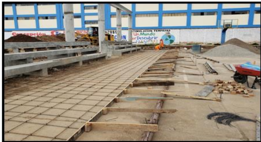
Foto N°14: Colocación de parrilla de acero en la losa deportiva de básquet.
