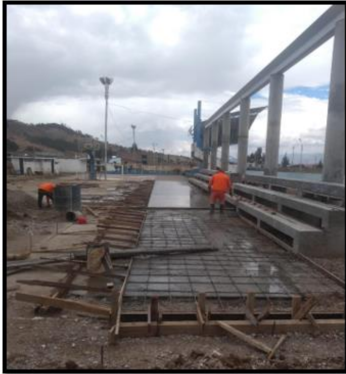
Foto N°24: Aplicación del aditivo Sikacem curador.
