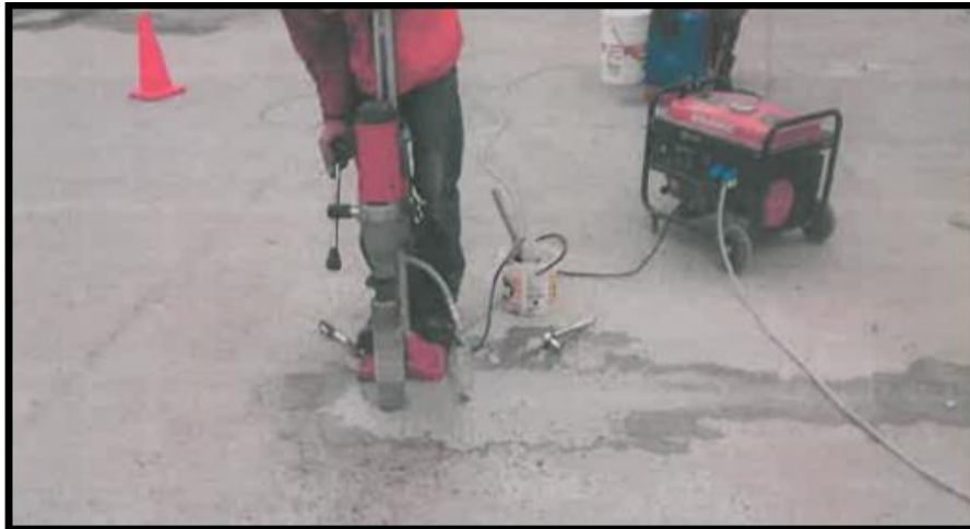
Foto N°7: Extracción del Testigo Diamantino, Diamantina N° 2
