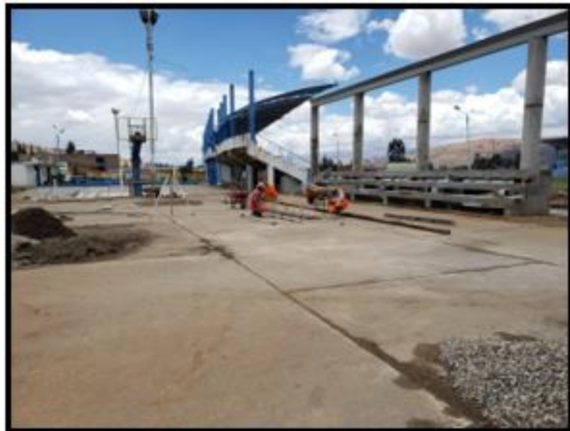
Foto N°16: Perforación y colocación de anclajes de ½" a distancia de 2m
