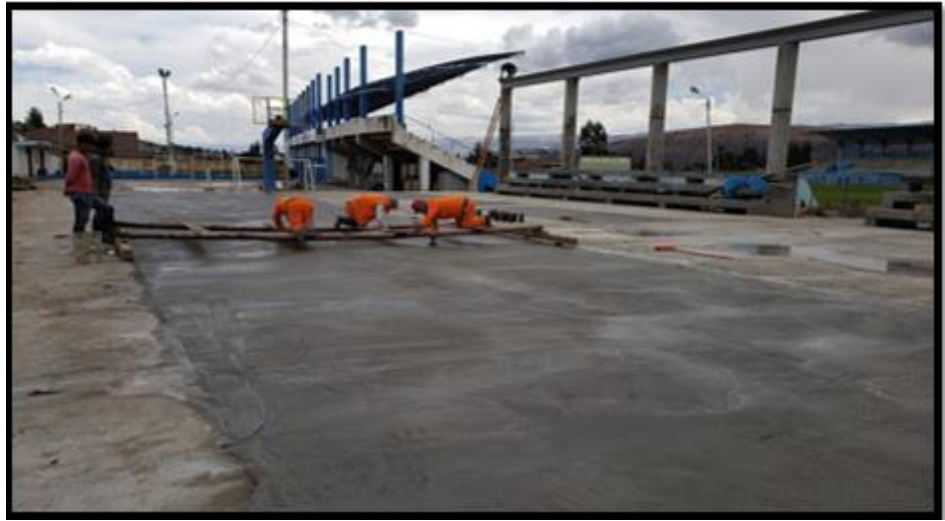
Foto N°23: Frotachado y acabado semipulido.
