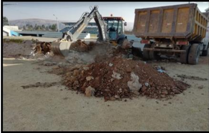
Foto N°13: Acarreo y eliminación de material excedente.
