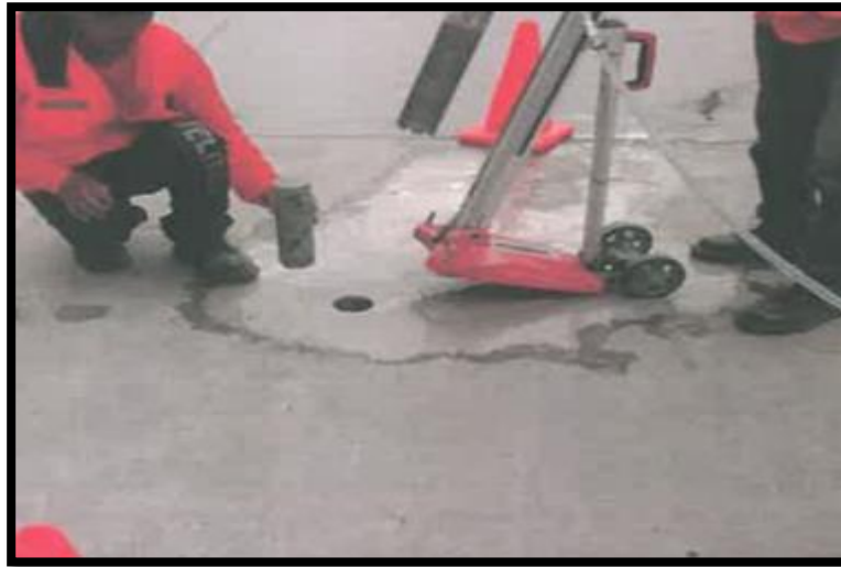
Foto N° 8: Extracción del Testigo Diamantino, Diamantina N° 2
