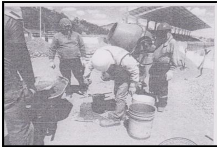
Foto N°19: Medición del asentamiento del concreto (Slump).
