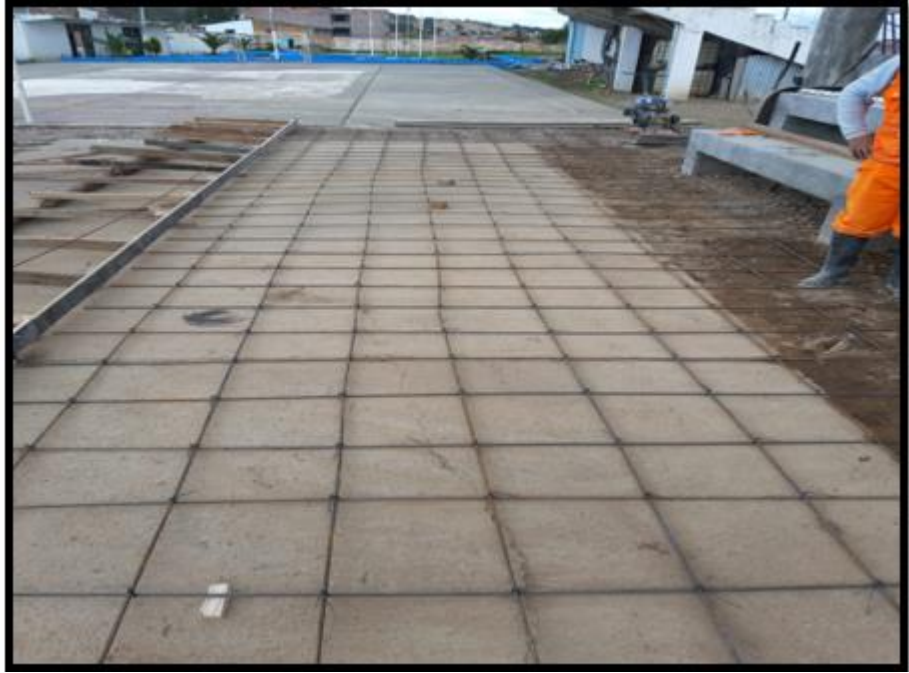
Foto N°15: Parrilla de acero en toda la losa deportiva de básquet.
