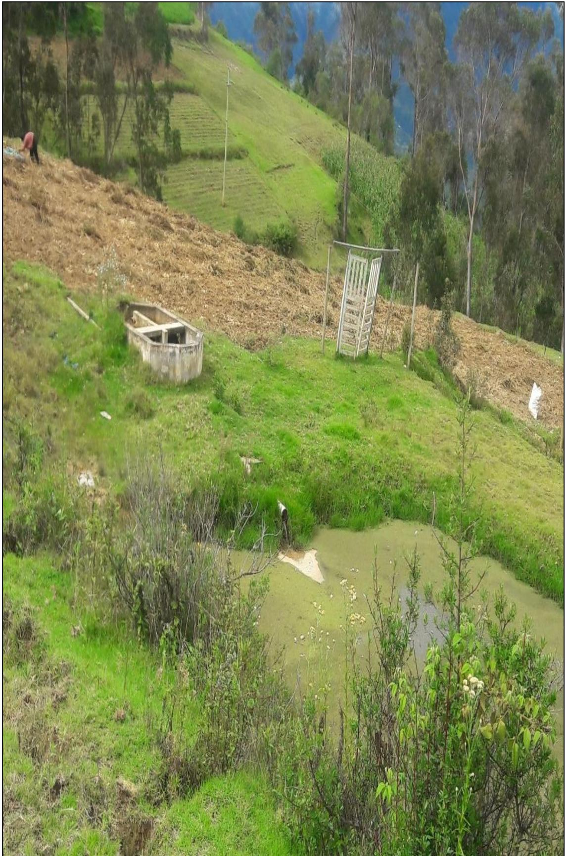
Fotografía 4. Se puede apreciar la entra de la línea emisora la cual llega a una cámara de rejillas la cual no está en funcionamiento.
