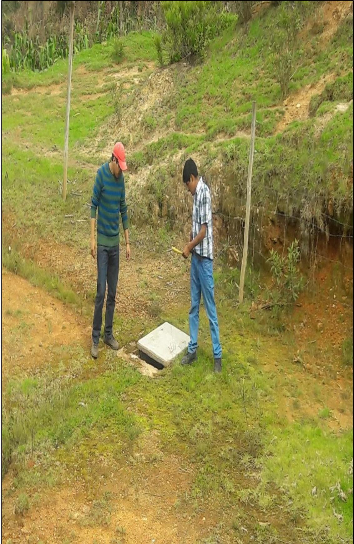
Fotografía 14. Se observa las cajas de distribución y unión de las dos lagunas las cuales no están en funcionamiento.
