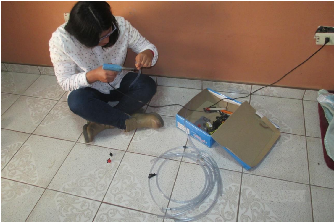
Elaboración de Tuberías para el paso del agua para el Sistema de Riego por Goteo.
