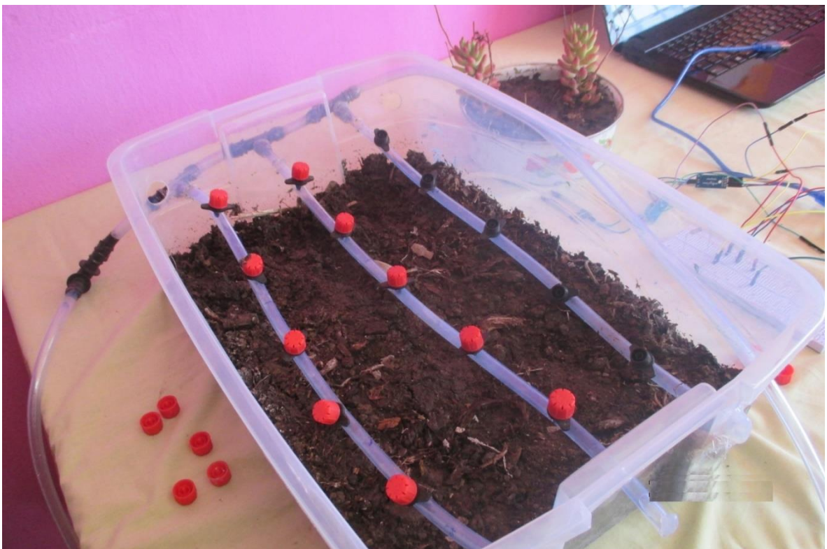
Instalación del Sistema de riego por Goteo.
