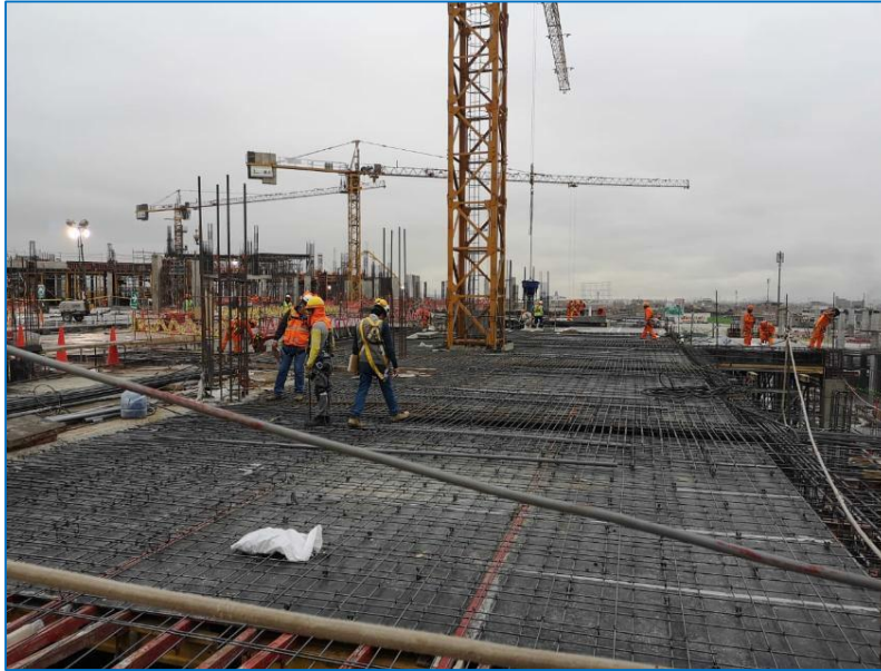
Encofrado de losa y liberación de II.EE. - Techo de piso 2, Sector 2C.
