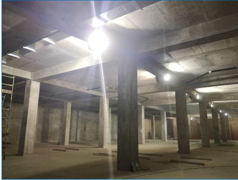
Estacionamientos – Sótano 1, Sector 2D
