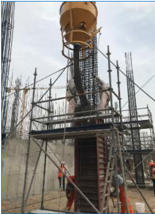
IZQ. Revisión de la verticalidad del elemento. DER. Montaje de acero pre dimensionado para columna.
