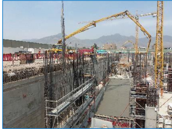
IZQ. Revisión de verticalidad en elementos encofrados. DER. Colocación de concreto en rampa
