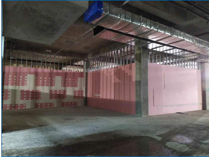
Tabiques de drywall Sótano 1 – Sector 2C
