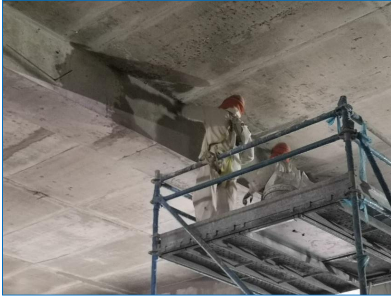
Solaqueo de vigas y losas – Sótano 1, Sector 2D
