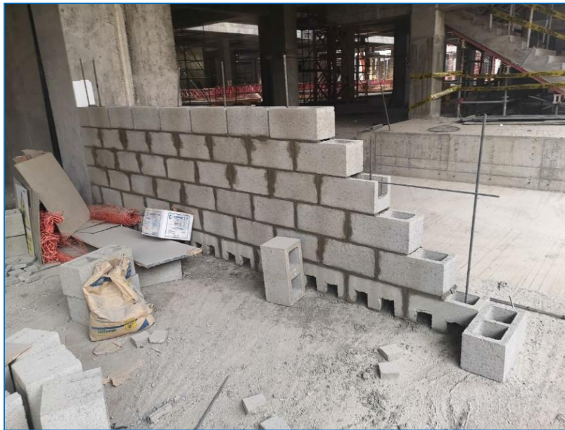
Colocación de ladrillo King Block – Piso 1, Sector 2D.
