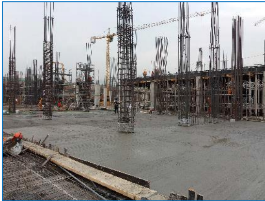
IZQ. Colocación de concreto en losa. placa.
