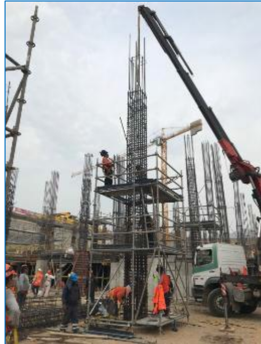
IZQ. Revisión de la verticalidad del elemento. DER. Montaje de acero pre dimensionado para columna.
