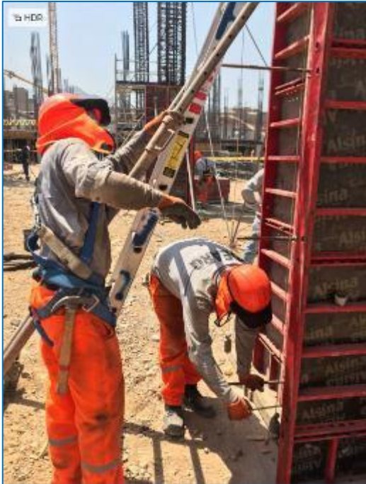
IZQ. Revisión de la verticalidad del elemento. DER. Montaje de acero pre dimensionado para columna.
