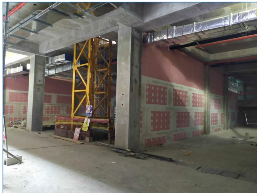
Tabiques de Drywall Sótano 1 – Sector 2C
