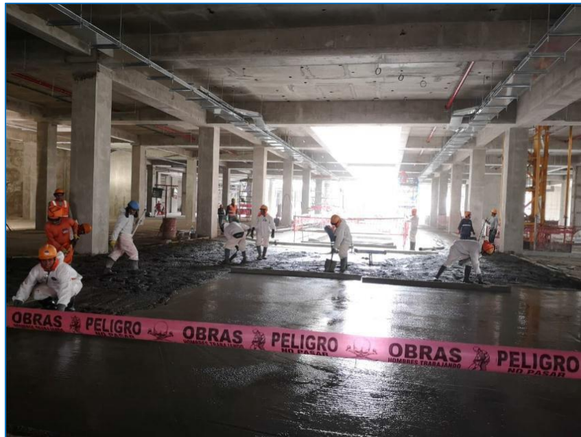
Contrapiso en Nivel +0.00m – Sector 2C
