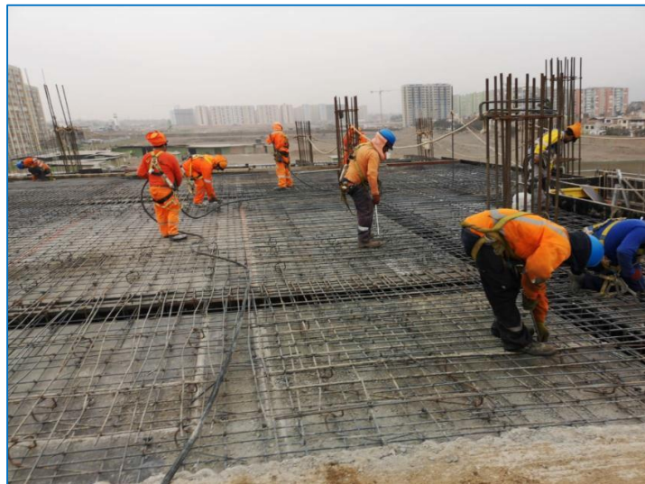
Limpieza de losas – Techo del Piso 1, Sector 2D
