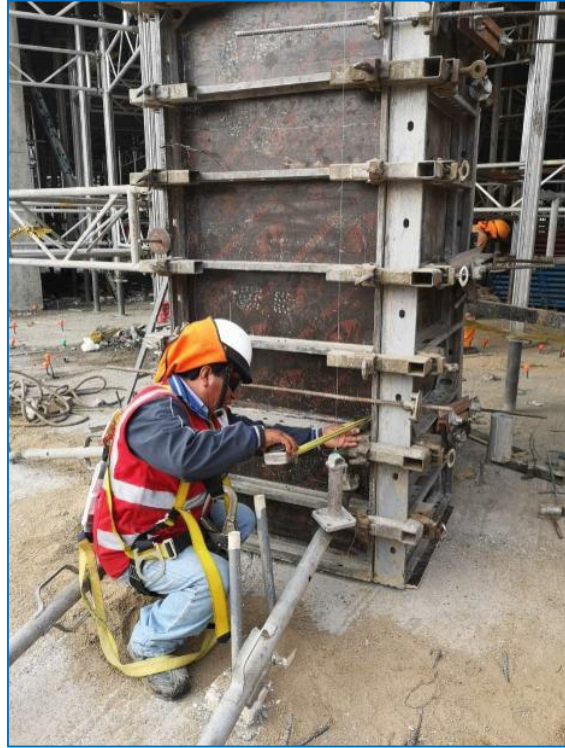
Verificación de verticalidad de encofrado de elementos verticales.
