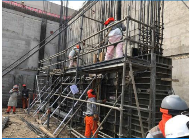
Colocación de concreto en placa.
