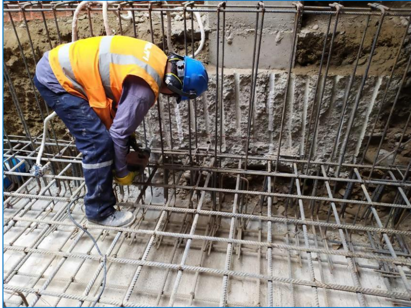
Perforación para anclajes en zapata para PIT de escalera mecánica – 2C
