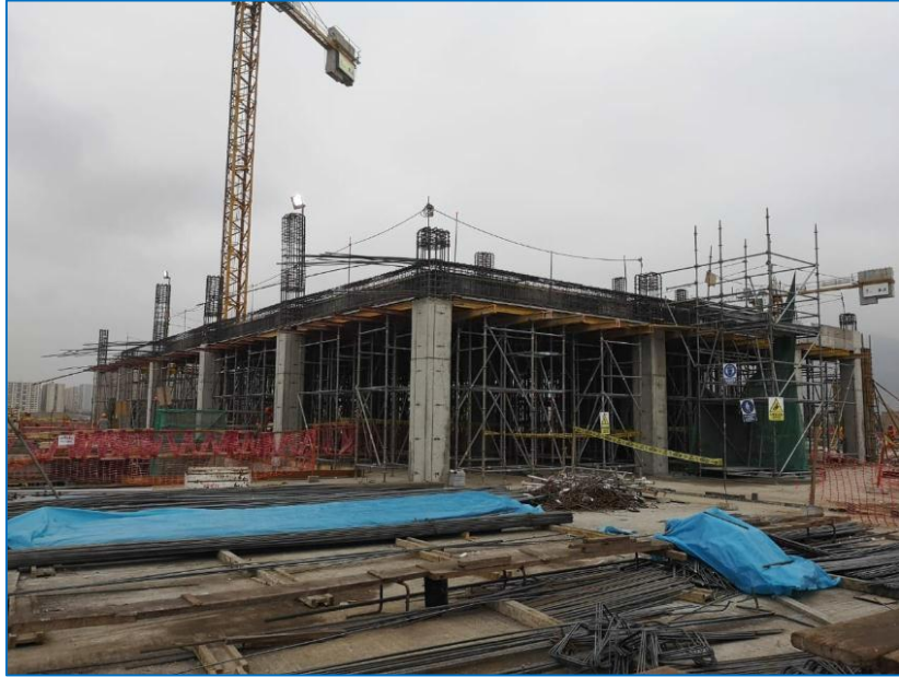
Encofrado de losa – Techo del Piso 3, Sector 2D
