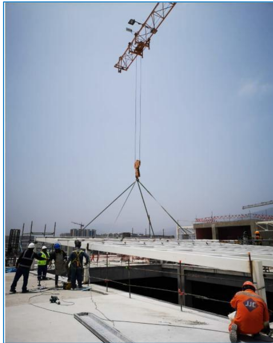
Montaje de Lucarna en Ripley – Sector 2D
