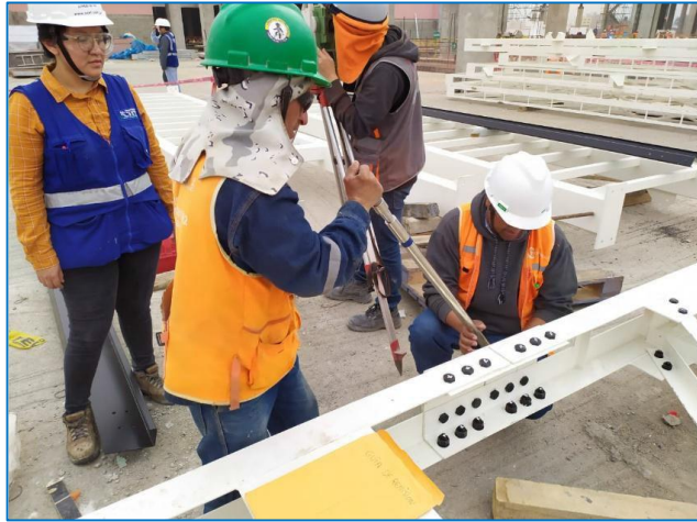
Pruebas de torque en estructura metálica – Sector 2C
