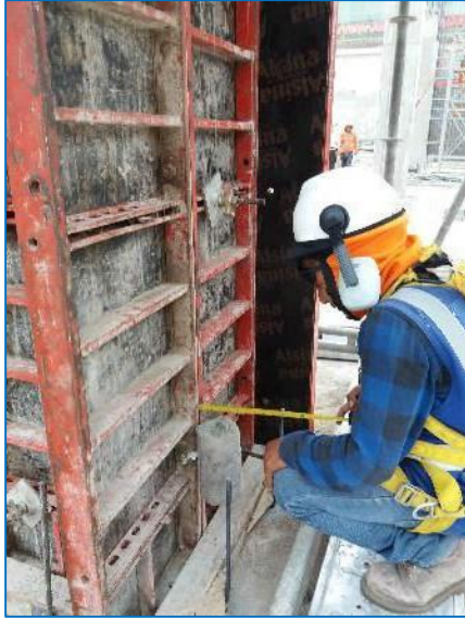
IZQ. Revisión de verticalidad en elementos encofrados. DER. Colocación de concreto en rampa
