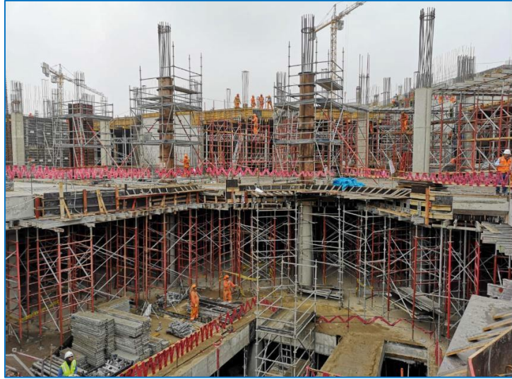
Encofrado de losa - Techo de sótano 1, Sector 2C.
