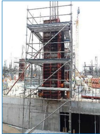
IZQ. Vista general de sector 2D. DER. Encofrado de columna
