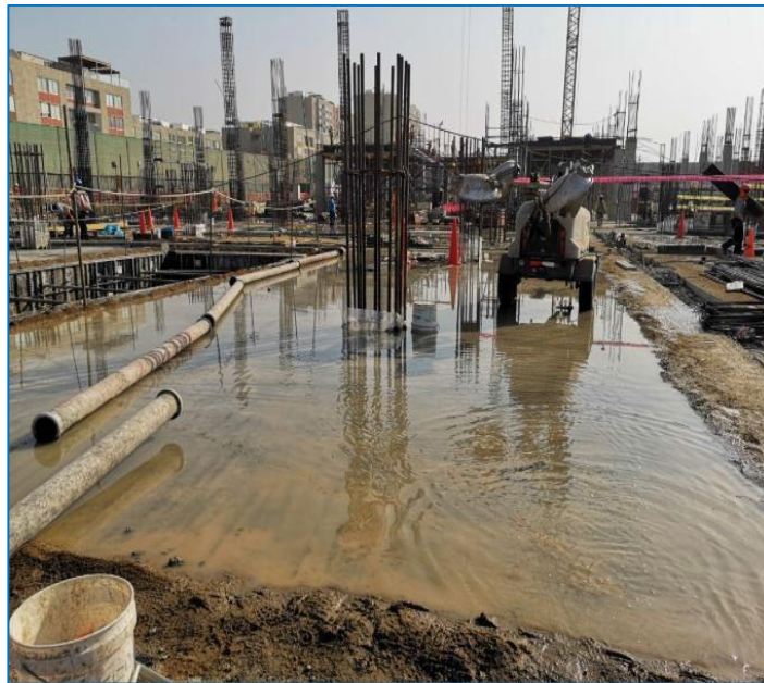
Curado de losas en Sector 2C – Nivel -0.07m
