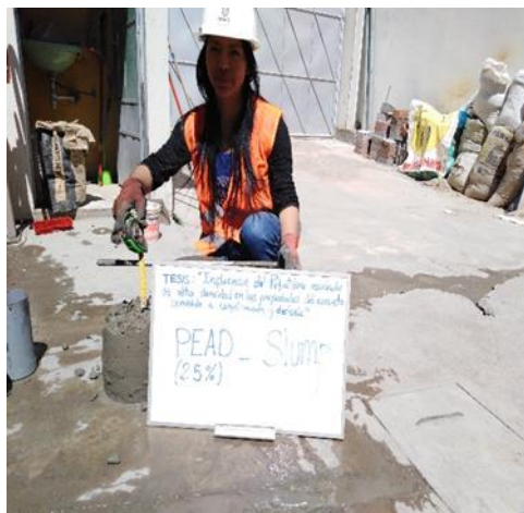
Figura 66. Asentamiento del concreto con 2.5% de PEAD
