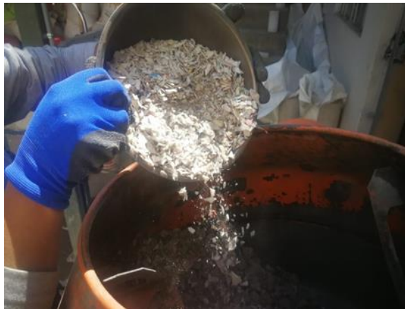
Figura 92. ELABORACION DEL CONCRETO CON PEAD. En la figura se observa la colocación de los materiales dentro del trompito.
