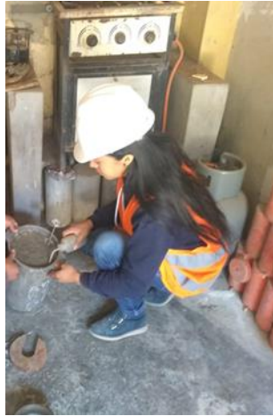
Figura 88. EXTRACCIÓN DE AGUA DE ENSAYO DE EXUDACIÓN. En la figura se observa la extracción de agua con la pizeta
