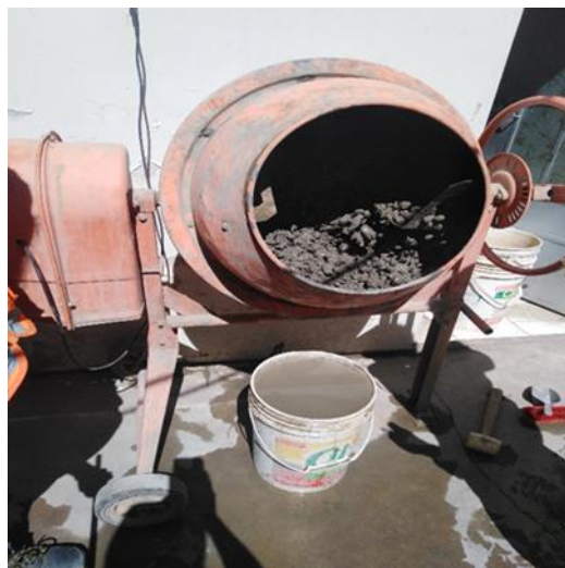
Figura 30. ELABORACIÓN DEL CONCRETO En la figura se observa la operación del trompito.
