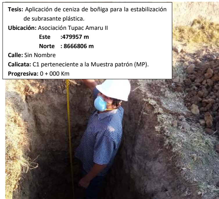
Figura 28. Extracción de la muestra patrón de la calicata 1. Fuente: Elaboración Propia
