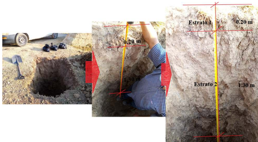
Figura 26. Estrato existente en la Calicata 1 Fuente: Elaboración propia.
