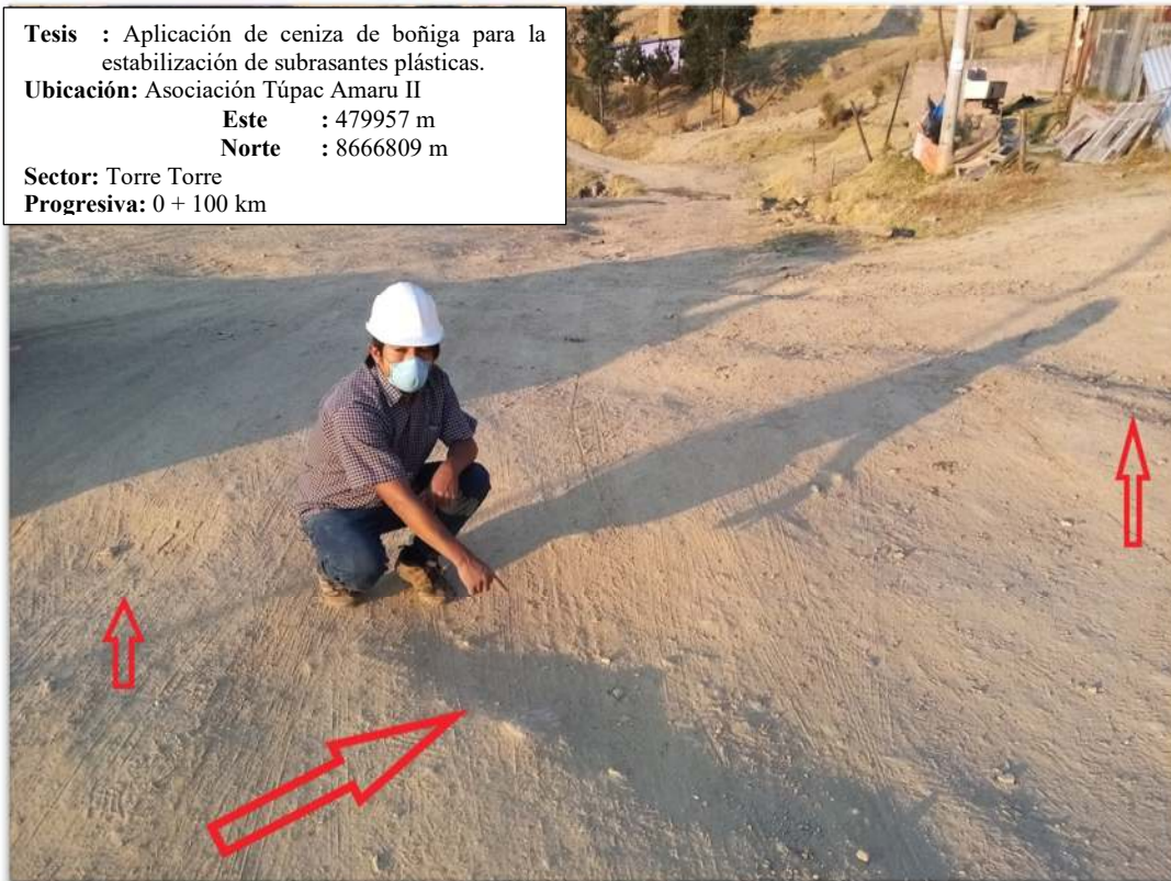
Figura 1. Problema existente en la vía de estudio.
