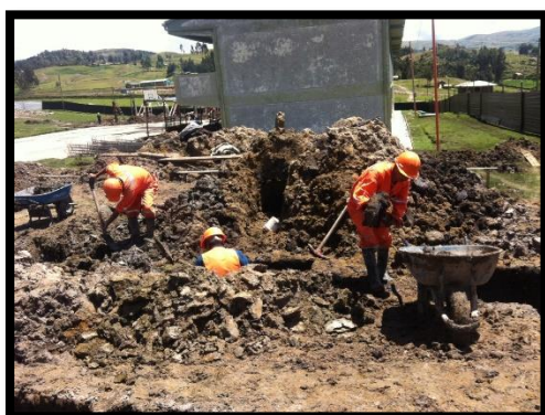
Foto N° 09 Excavación para la cimentación
