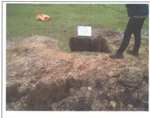
FOTO 04.- EXCAVACION DE C-2 DE 2.80 mts, INSTITUCION EDUCATIVA JORGE BASADRE
