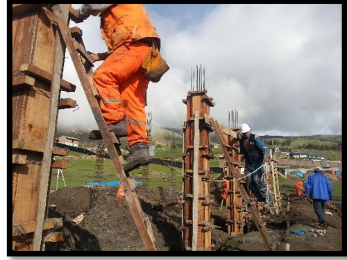
Foto N° 14 vaciado de columnas
