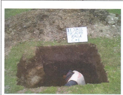
FOTO 01.- EXCAVACION DE C-1 DE 2.80 mts, INSTITUCION EDUCATIVA JORGE BASADRE.
