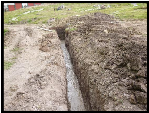
Foto N° 17 eliminación del agua para Realizar el dren tipo francés
