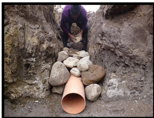
Foto N° 19 preparación del terreno Para colocado de tubería
