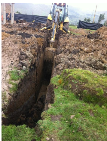
Grafico 4.2-1 excavación con maquinaria el drenaje
