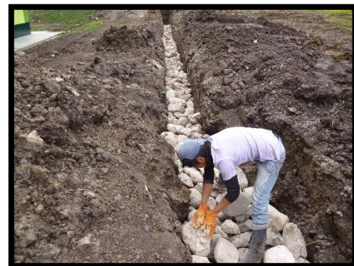
Foto N° 18 eliminación del agua para Realizar el dren tipo francés
