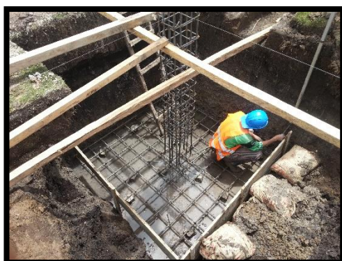
Foto N° 10 realizando la medición del Nivel fondo de cimentación
