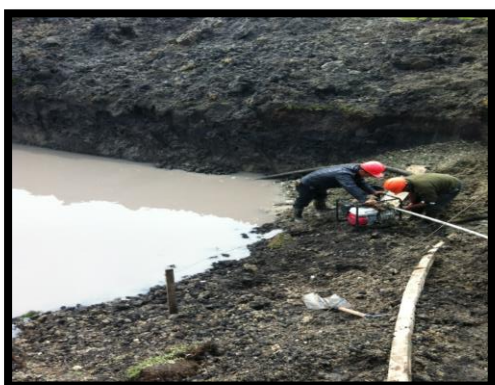
Foto N° 07 Eliminación del agua empozada Para ejecutar la cimentación
