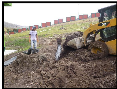
Foto N° 20 colocación de canto rodado en toda la extensión del dren
