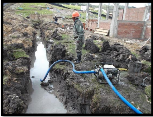
Foto N° 17 eliminación del agua para Realizar el dren tipo francés
