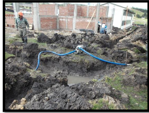
Foto N° 18 eliminación del agua para Realizar el dren tipo francés
