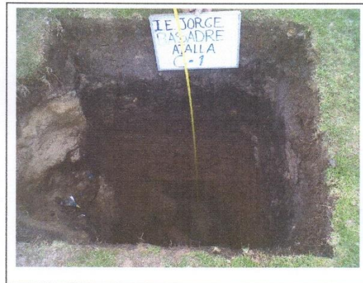
FOTO 02.- PROFUNDIDAD DE EXCAVACION 2.80 mts.
