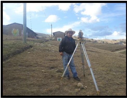
Foto N° 03 Ejecución del Trazo y Replanteo
