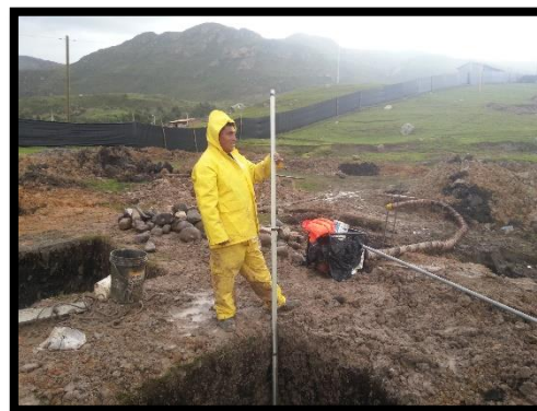
Foto N° 10 realizando la medición del Nivel fondo de cimentación
