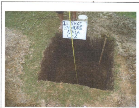
FOTO 05.- PROFUNDIDAD DE EXCAVACION DE C-1 DE 2.80 mts, INSTITUCION EDUCATIVA JORGE BASADRE.
