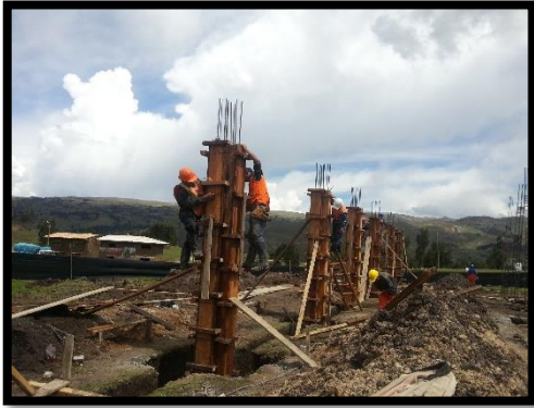
Foto N° 13 encontrado de columnas Sobre la cimentación
