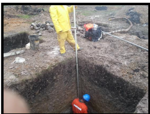
Foto N° 11 realizando la medición del Nivel donde de cimentación
