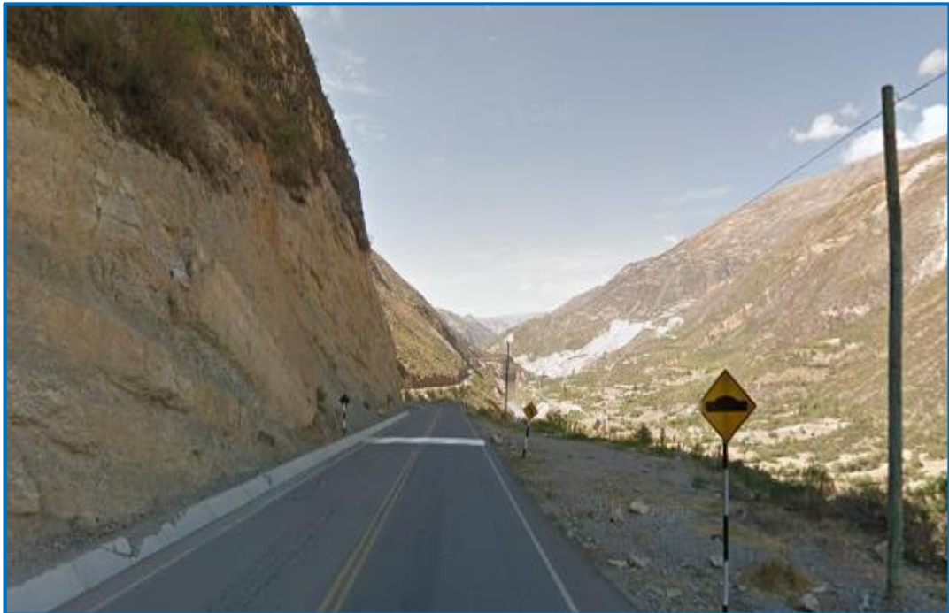
Figura N° 30. Señal de proximidad de reductor de velocidad tipo resalto
