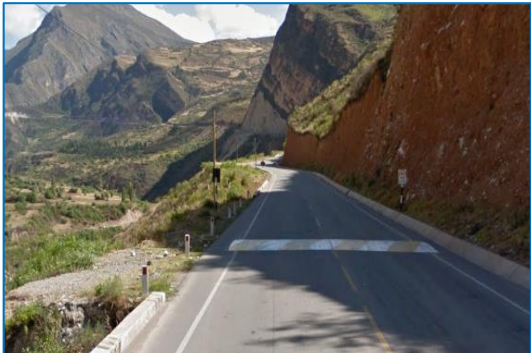
Figura N° 29. Reductor de velocidad tipo resalto antes de una curva sinuosa.
