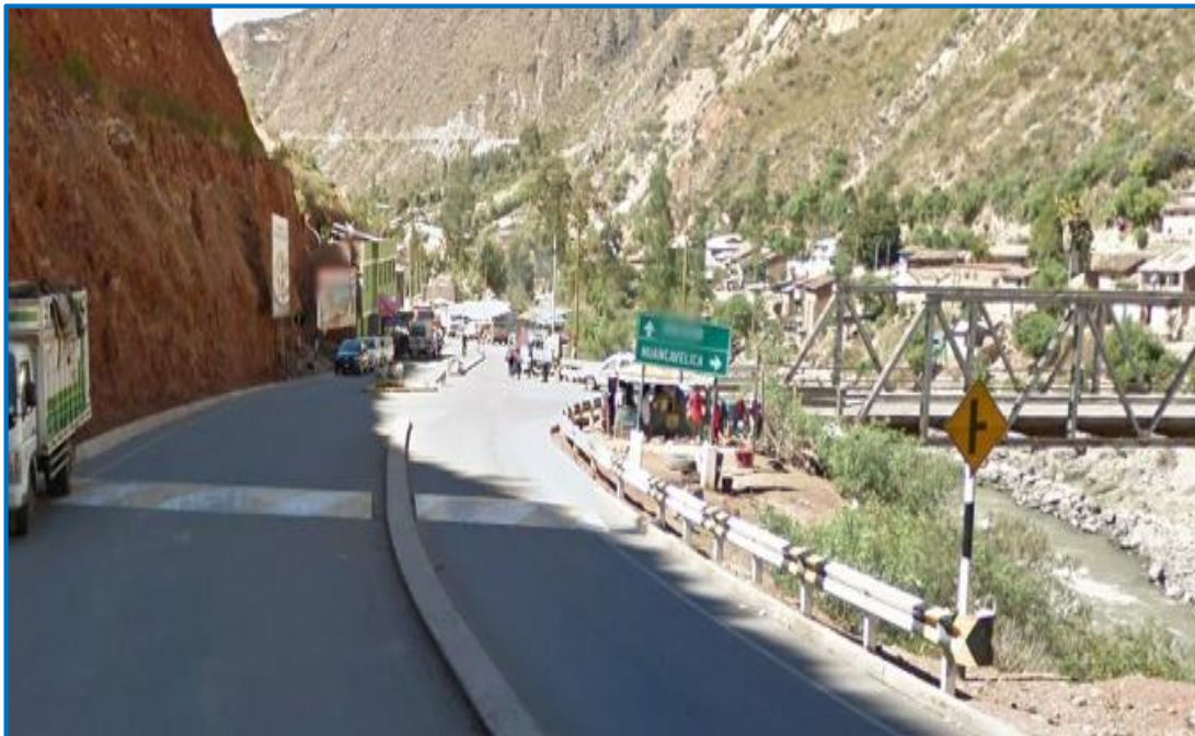
Figura N° 39. Señal empalme en el ángulo recto con vía lateral a la derecha
