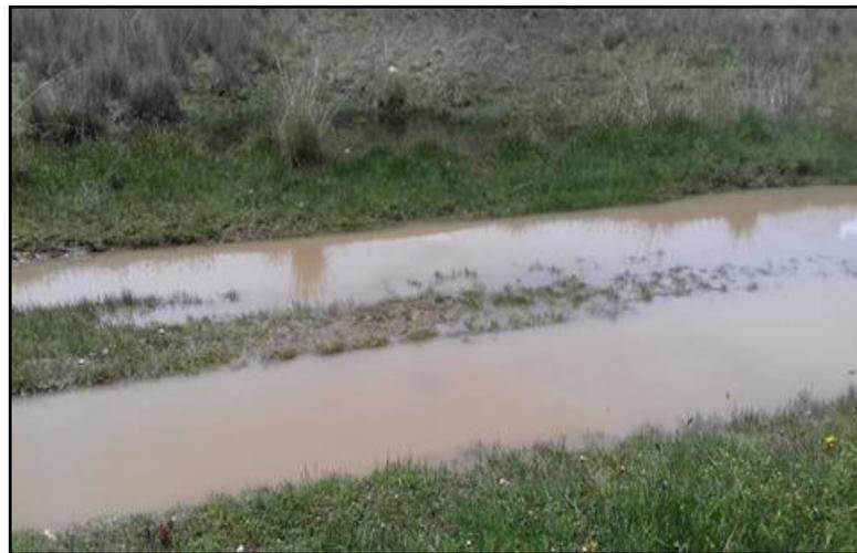
*Fotografía 7.- Se puede observar una pequeña acumulación de agua en trazo de la vía, la cual se tomó en cuenta al realizar el diseño del proyecto.*
