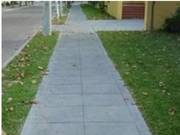
FIGURA 2 VEREDA PULIDA. FUENTE: PISOS EN CONCRETO ARTICULOS
