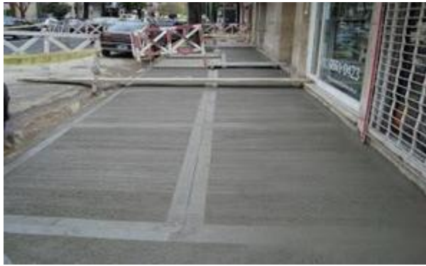
FIGURA 5: VEREDA DE HORMIGÓN PEINADO. FUENTE: VEREDAS ADOQUINADAS Y OTRAS
