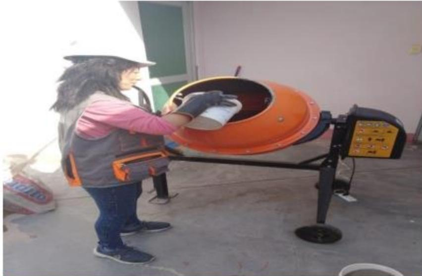
Foto N°15: Vista de adición de escoria de fundación dentro de la mezcladora
