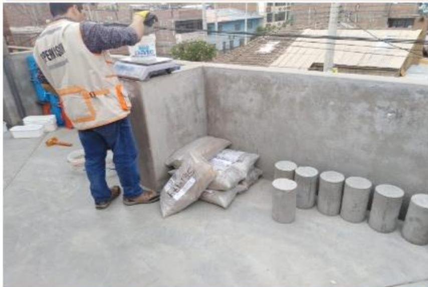
Foto N°10: Vista de control de peso de cemento dosificado
