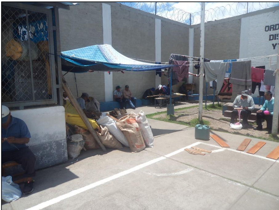
IMAGEN 7: SE PUEDE OBSERVAR EN LA IMAGEN LA FALTA DE INTERVENCION ARQUITECTONICA EN LOS ESPACIOS MOSTRADOS.
