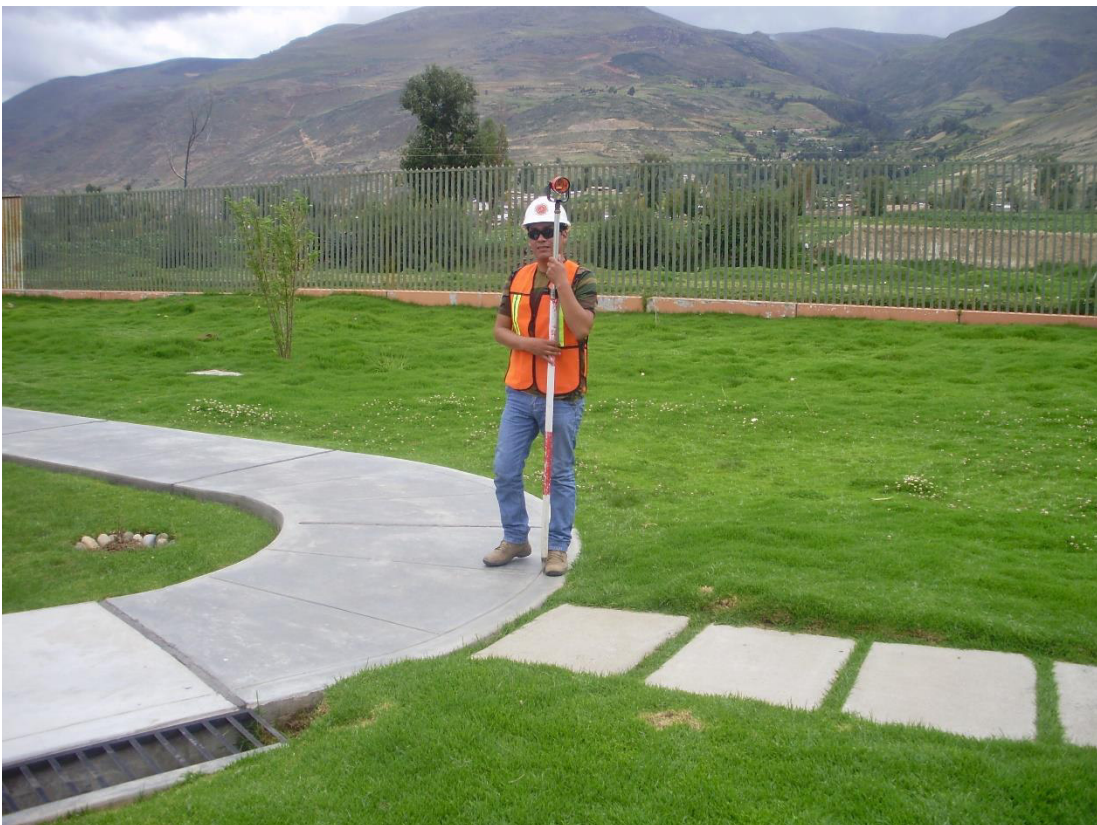
Foto 7. Nivelación del prisma para toma de datos.
