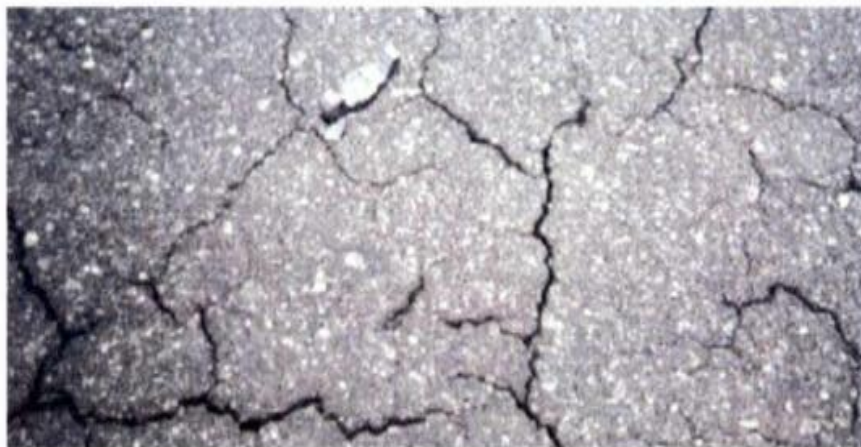
FIGURA 6: Piel de cocodrilo (gravedad 2)
