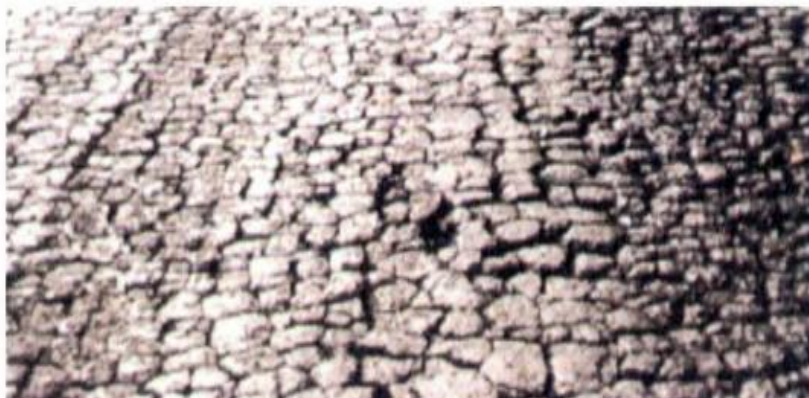
FIGURA 7: Piel de cocodrilo (gravedad 3)
