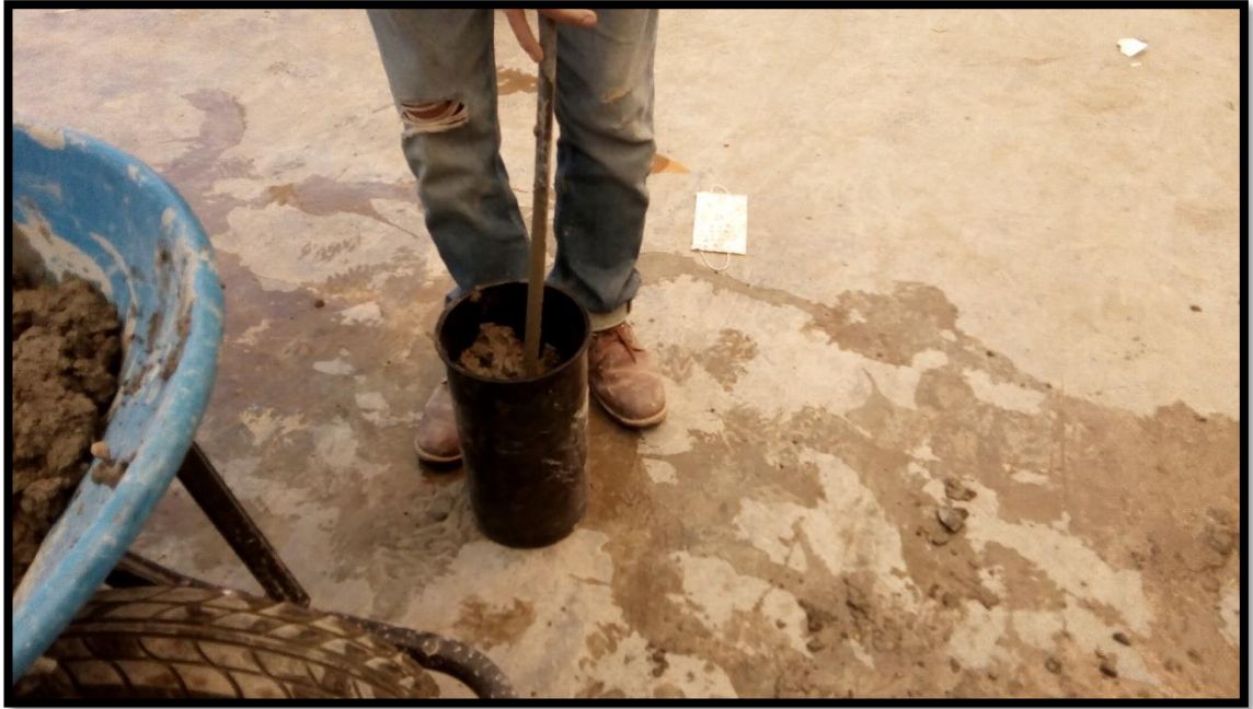
Sacando muestras para las probetas del concreto
