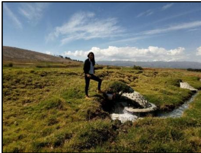
Fotografía 3. Acumulación de agua tratada
