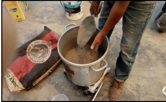
Fotografía 11. Pesaje de los agregados
