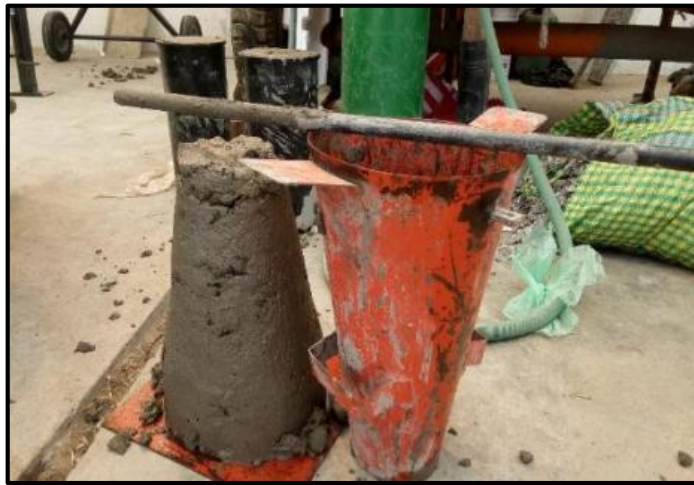
Fotografía 7. Asentamiento del concreto
