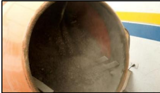
Fotografía 13. Elaboración del concreto premezclado
