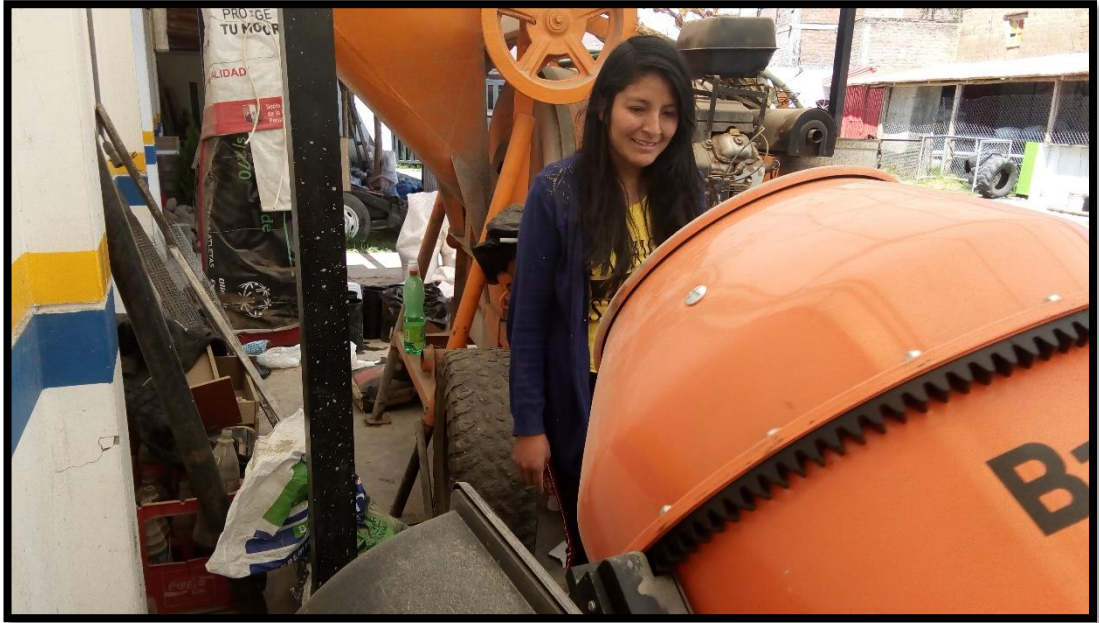
Preparado del concreto
