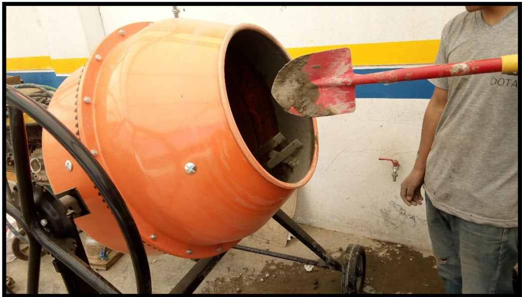
Preparado del concreto
