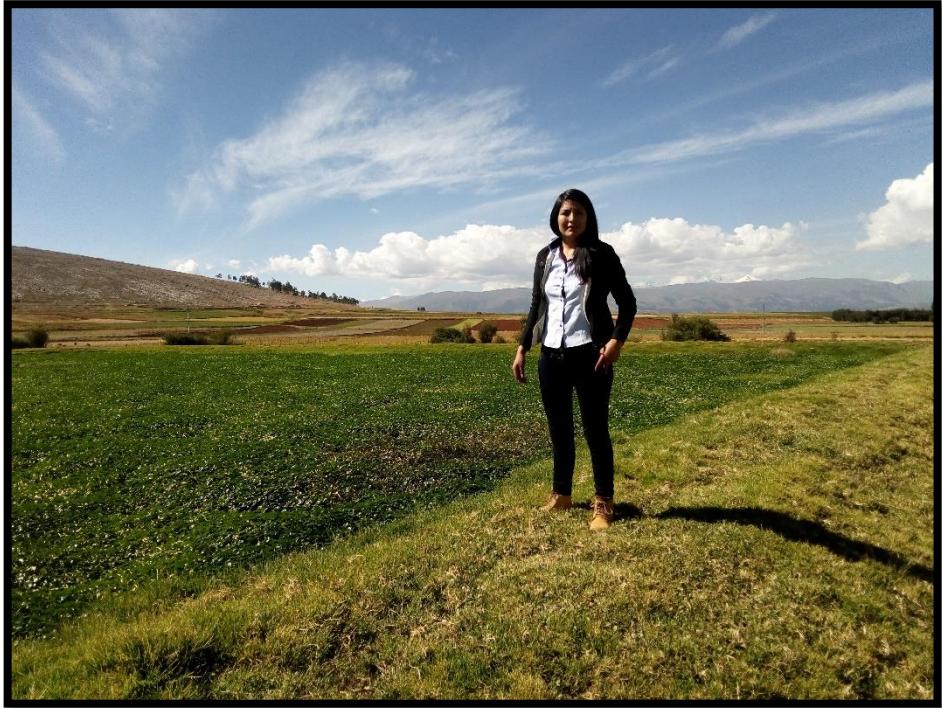
PTAR de Huachac
