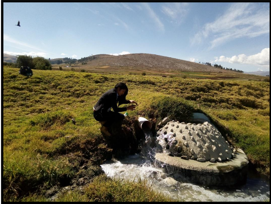
Toma de muestra del agua de PTAR de Huachac
