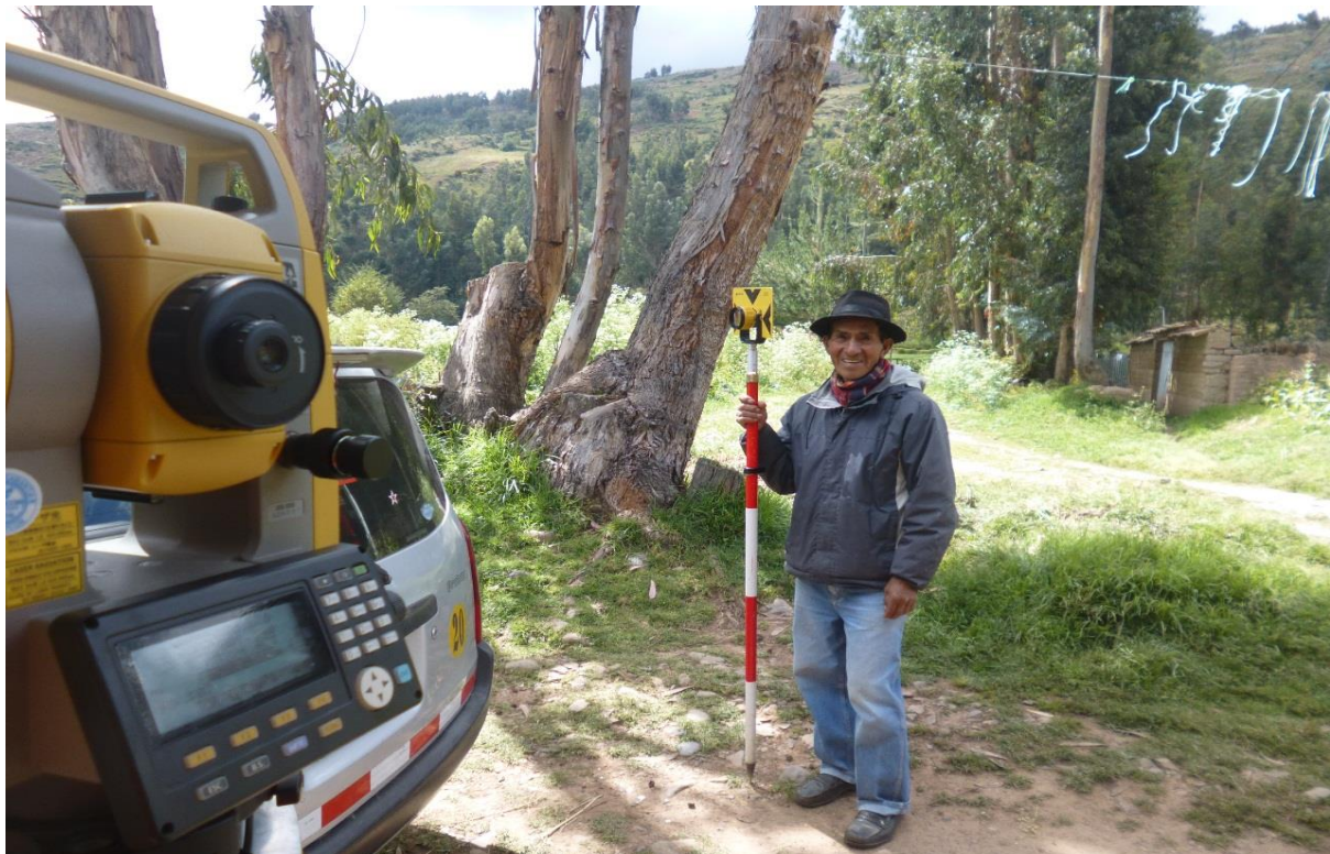
Fotografía N°6: Inicio del levantamiento con ayuda de los pobladores de la zona.
