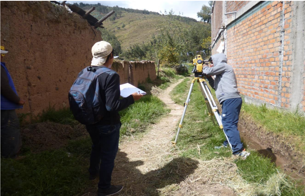
Fotografía N°10: Verificación de puntos clave en la red existente.
