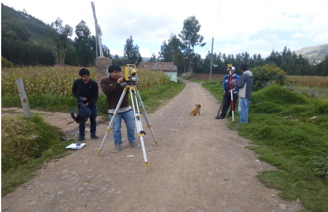
Fotografía N°11: Otra vista de la Verificación de la red existente en una calle principal de Asca.
