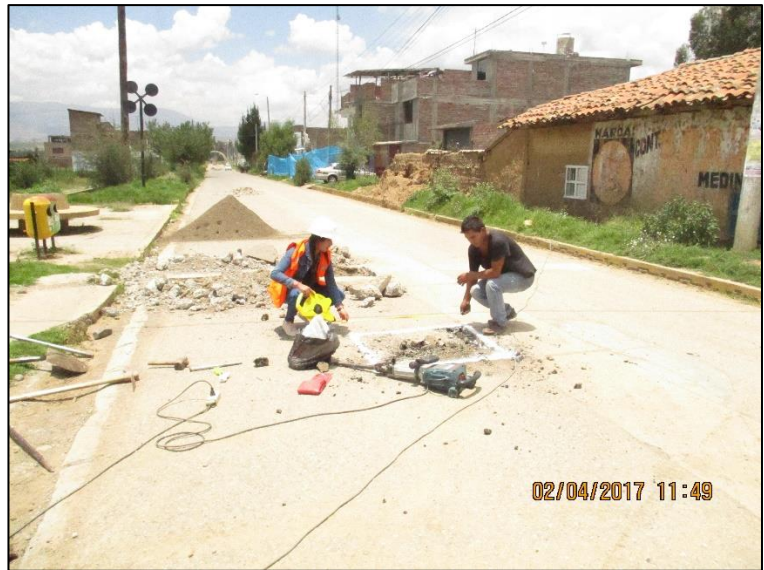
FIGURA N°3: Calicata a Cielo Abierto
