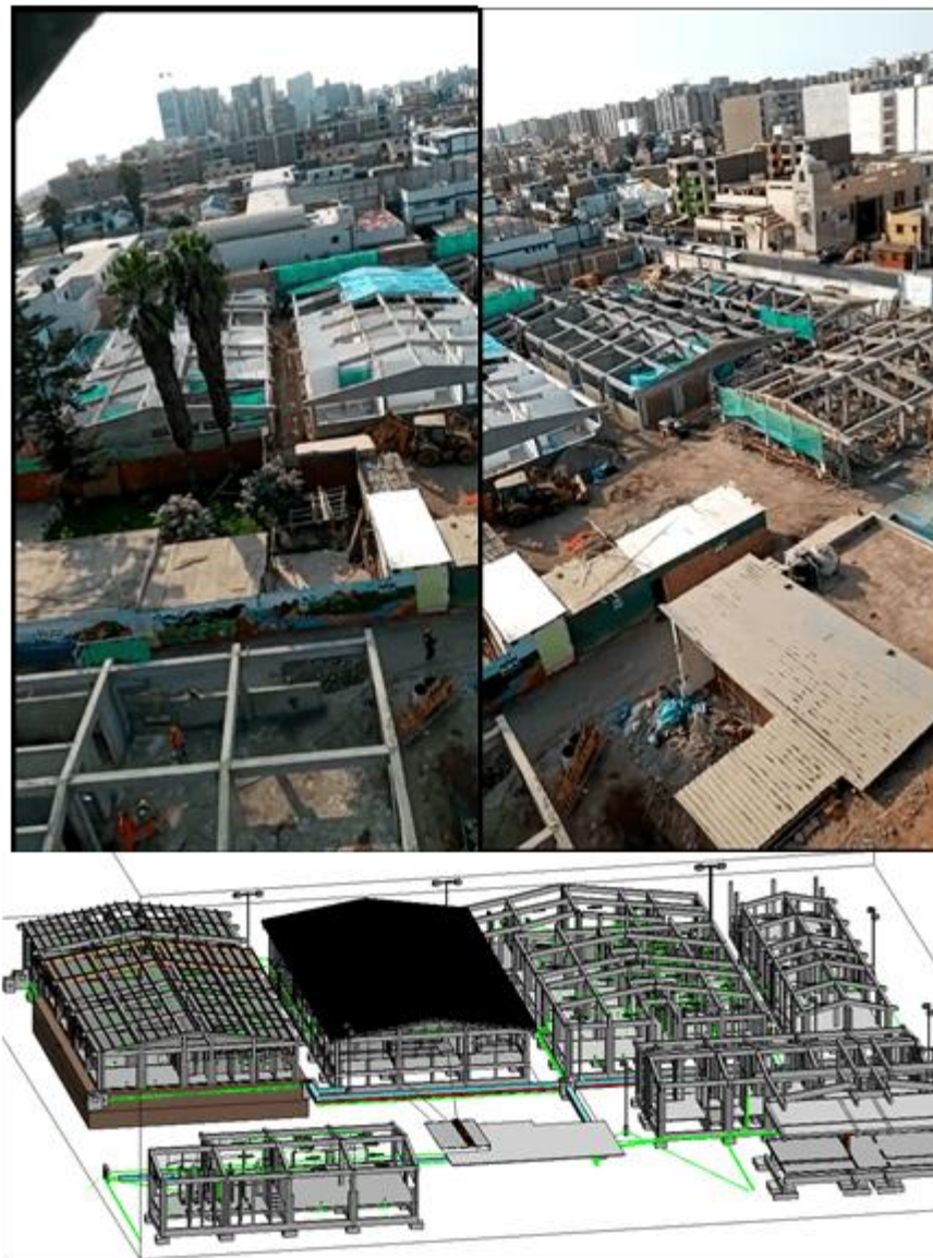
Figura 83: Vista Panorámicas de Bloques en Ejecución y Modulación
