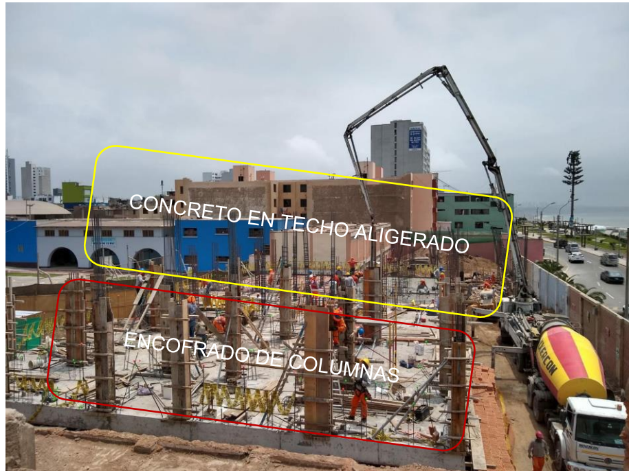
Figura 52: Ejecución según la sectorización (Verticales y Horizontales)
