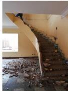
Recorrido en Modulos Existentes
