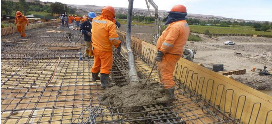
Figura 15- Se realiza el encofrado del estribo del puente Otalo..
