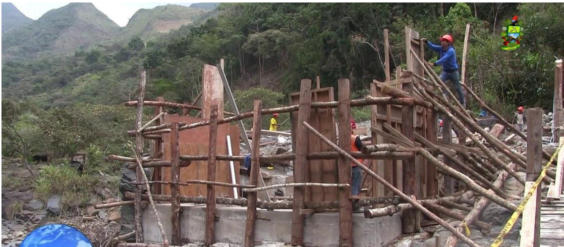
Figura 14- Se realiza el encofrado del estribo del puente Otalo..
