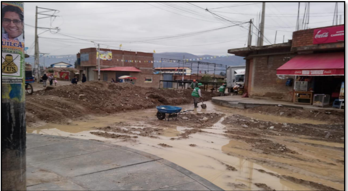
Extracción de agua de lluvia del material granular
