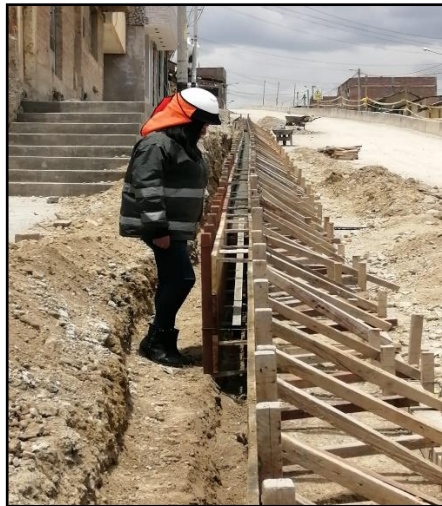
Fotografia 12.- Verificacion de encofrado para colocacion de concreto 210 kg/cm2
