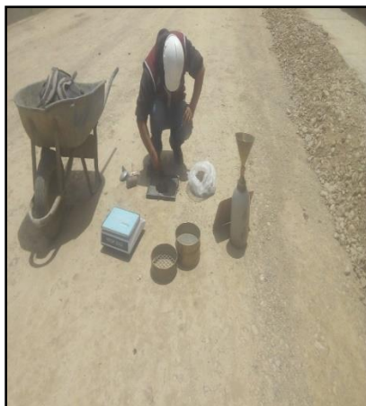
Fotografía 7.- Grado de compactación de la sub base granular
