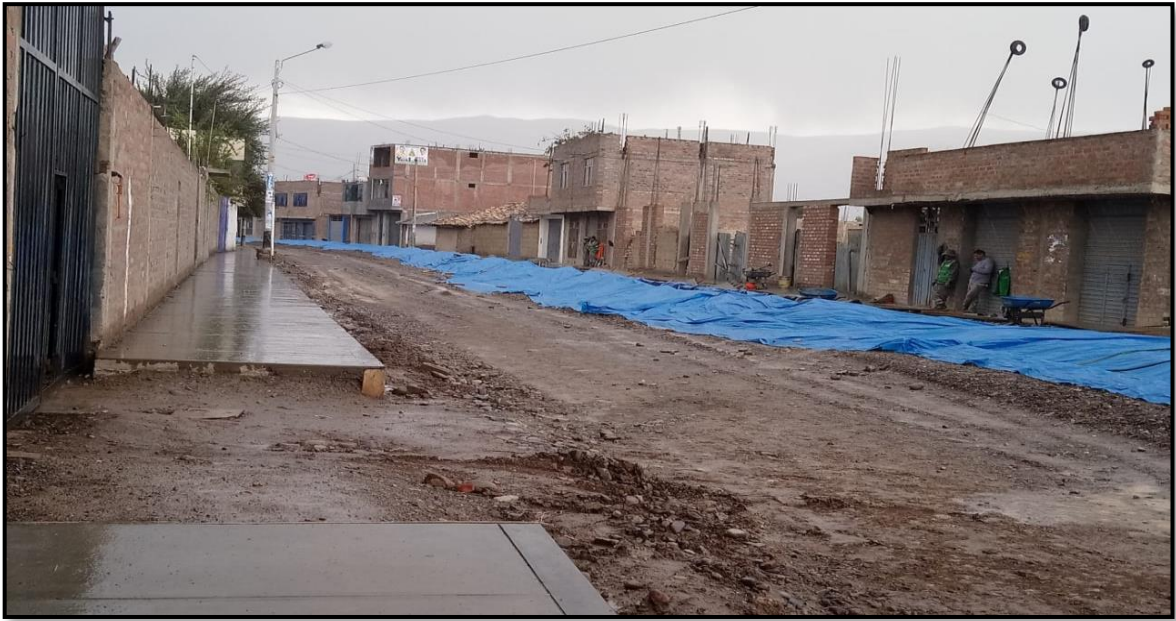
Secado de material granular extendido
