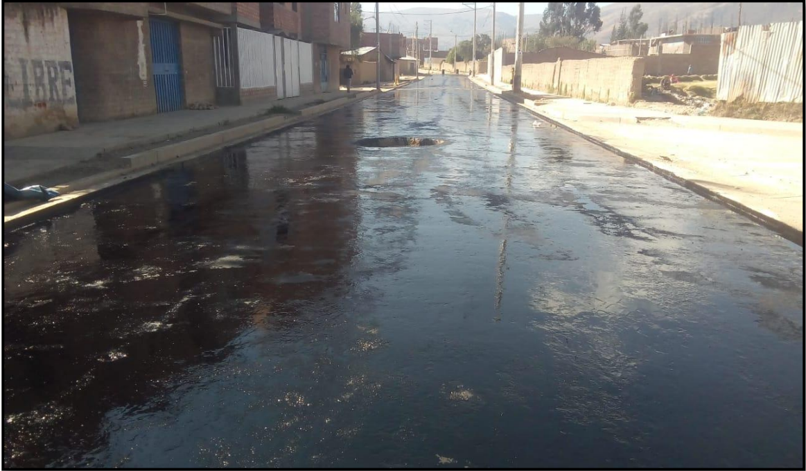
Imprimación asfáltica de la vía
