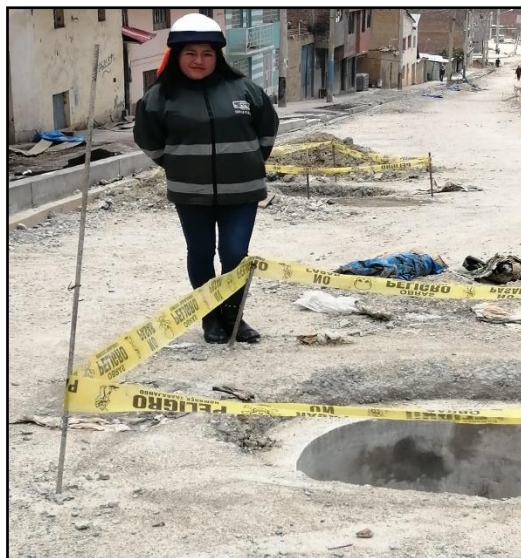
Fotografía 13.- Control de calidad de encimacion de Buzones
