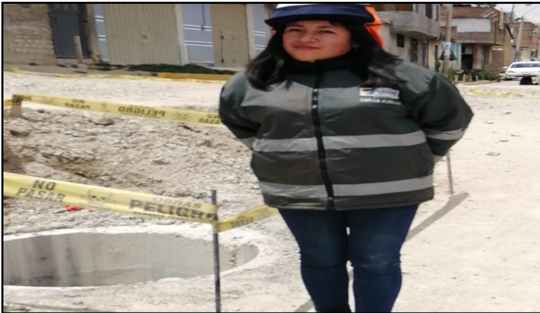
Verificación de encimacion de buzones
