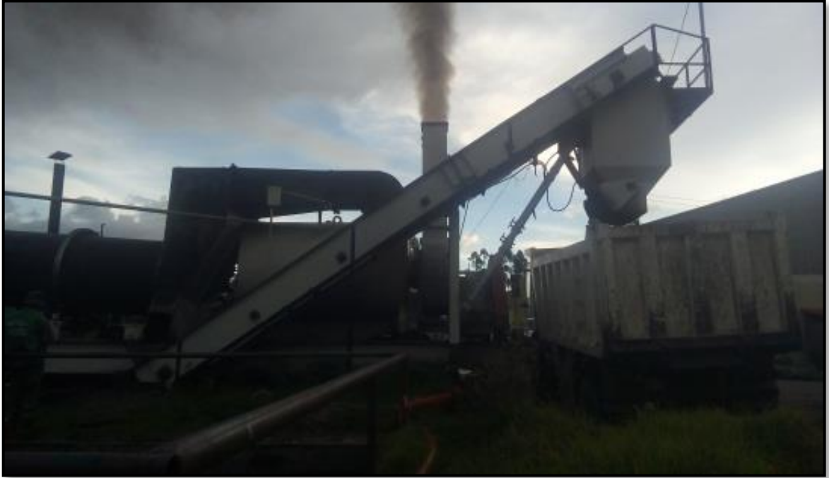
Verificación de los trabajos realizados en la planta asfáltica
