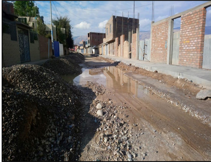
Fotografía 2.- Antecedentes de la construcción
