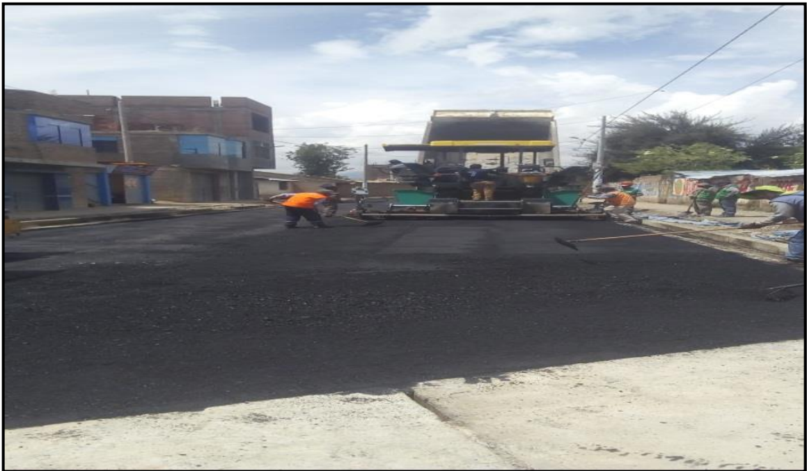
Colocación de carpeta asfáltica en la vía intervenida
