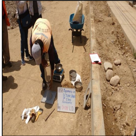
Fotografía 6.-.- Grado de compactación de la sub base granular
