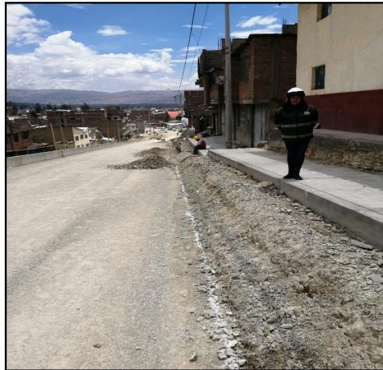
Fotografía 11.- Verificación de trabajos con Diseño de concreto 175 kg/cm2
