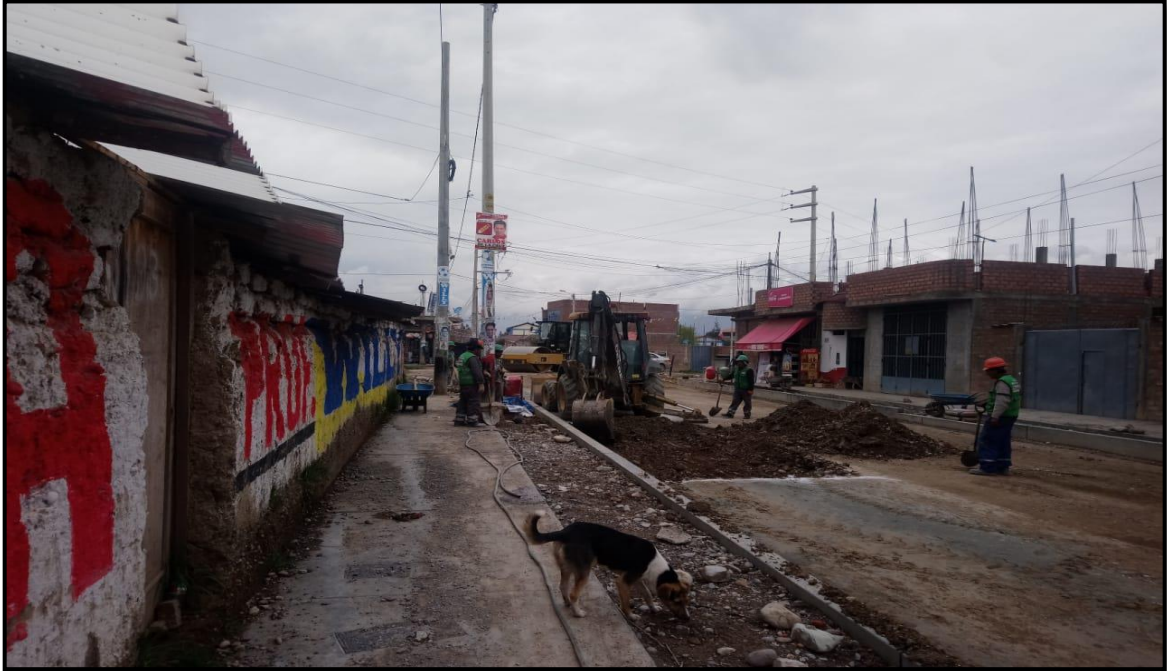
Excavacion para cunetas
