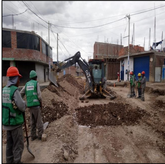
Fotografía 5.- Puntos para alineamiento y estudio de mecánica de suelos
