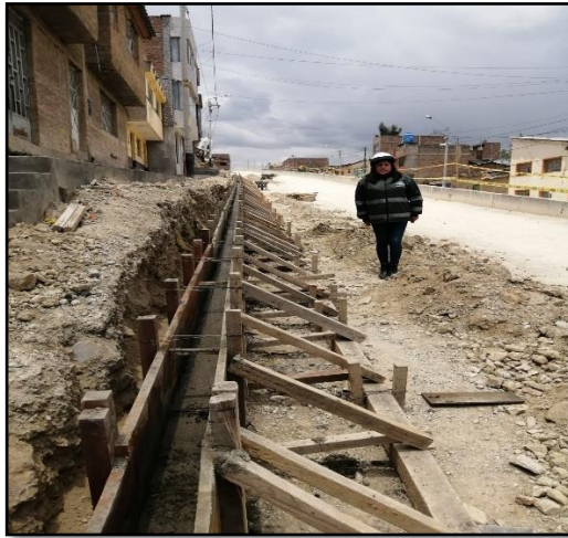
Fotografía 14.- Verificación para sardinel Expuesto
