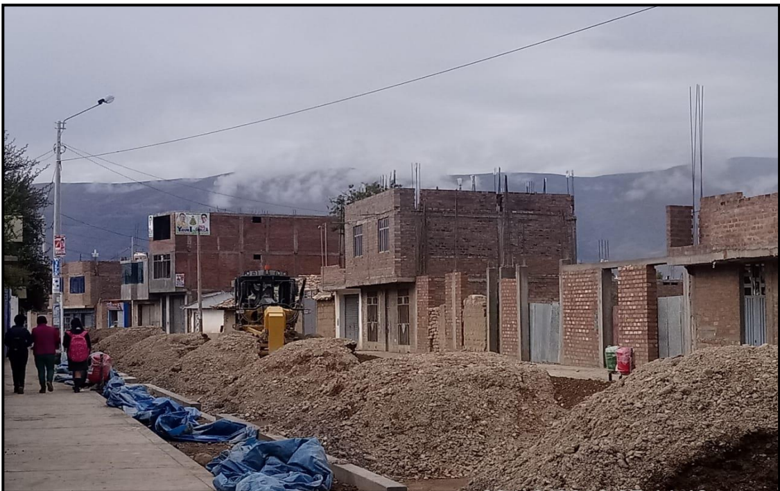
Acopio de material granular en la vía a intervenir
