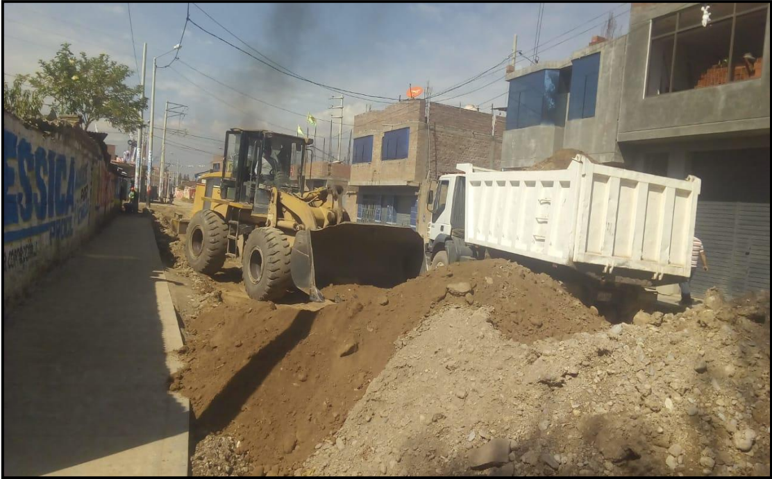
Evacuación de Material en la vía intervenida
