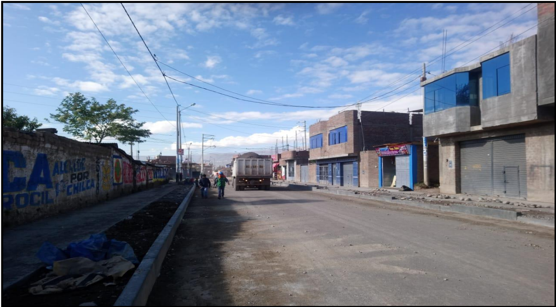
Acopio de material de base granular
