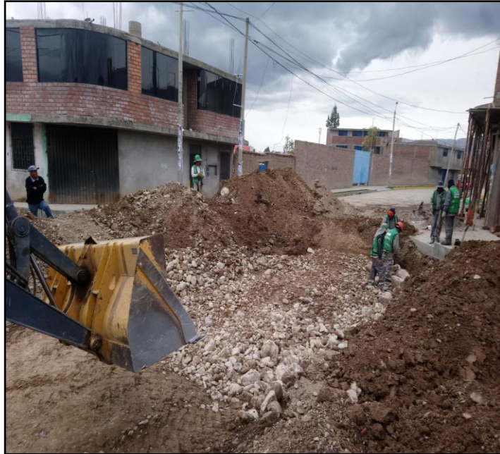
Fotografía 3.- Trabajos de movimiento de Tierras
